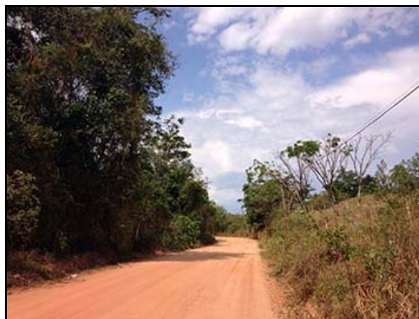
Figura 3.4.3-24 - Estrada Vicinal em São José do Rio Pardo.
