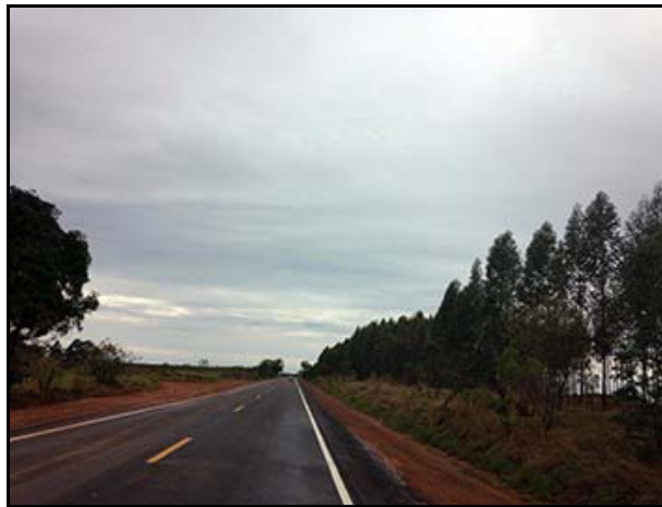
Figura 3.4.3-10 - Rodovia João Traficante.
