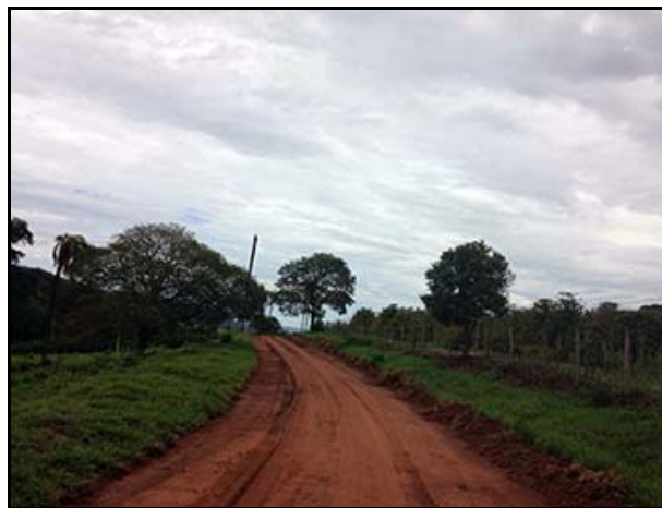
Figura 3.4.3-9 - Estrada Vicinal em Franca.
