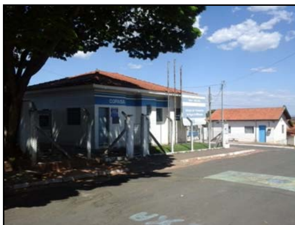
Figura 3.4.3-1 - Estação de Tratamento de Água do Bairro Milagre - Município de Monte Santo de Minas (MG).
