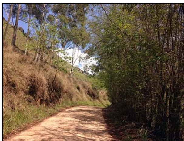
Figura 3.4.3-26- Estrada Vicinal em Divinolândia.
