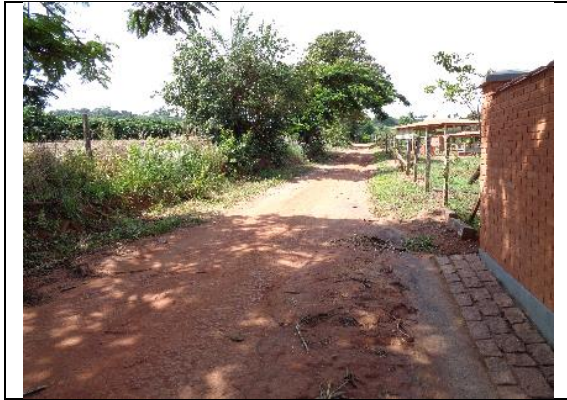
Acesso existente até as áreas agrícolas.
