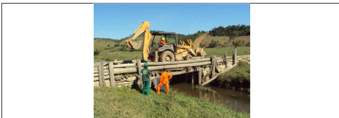
Figura 7 – Construção de ponte.
