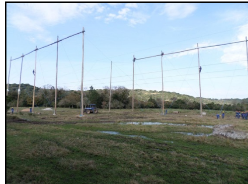
Figura 1.4-11 - Cavaletes utilizados para cruzamentos da linha em construção com outras linhas, rodovias, estradas, rios
