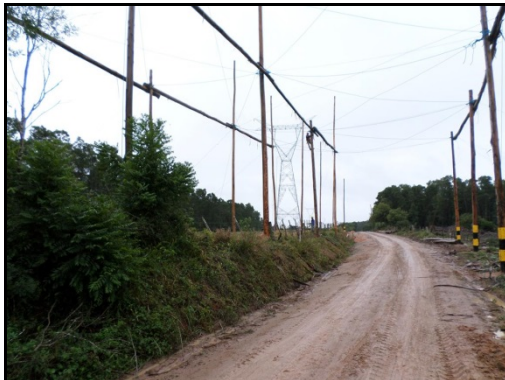
Figura 1.4-11 - Cavaletes utilizados para cruzamentos da linha em construção com outras linhas, rodovias, estradas, rios
