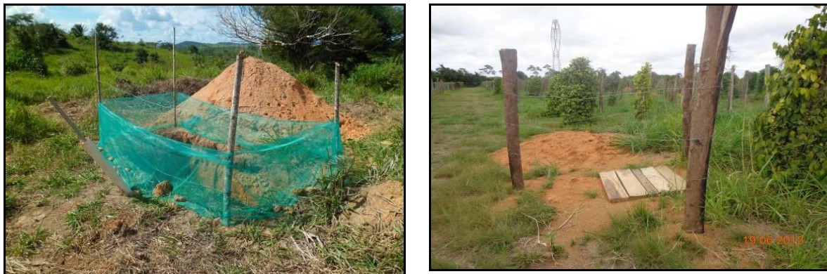
Figura 4.5-1 - Cercamento e cobertura de cavas de fundações
