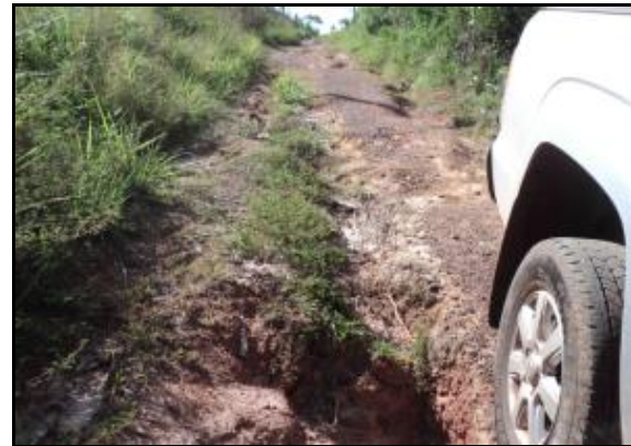
Figura 2.2.4.4.8-49 - Estrada vicinal de difícil circulação-Curimatã.
