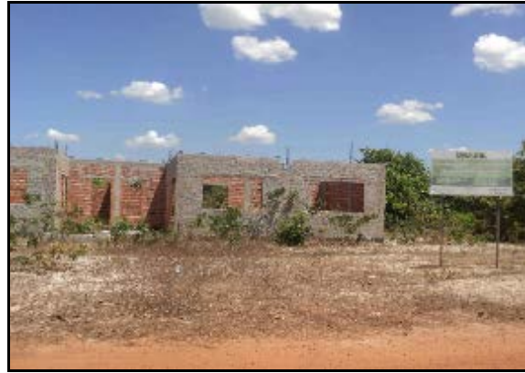
Figura 2.2.4.4.8-250 - Escola em construção.
