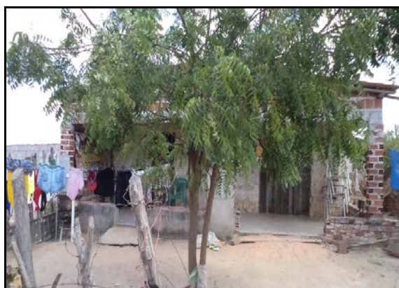
Figura 2.2.4.4.8-732 - Residência no Povoado Baixa Grande
