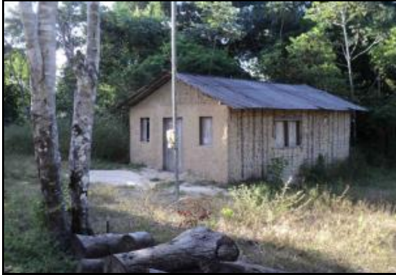
Figura 2.2.4.4.8-50 - Residência de taipa.
