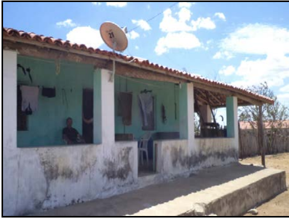
Figura 2.2.4.4.8-605 - Residência no Povoado Sítio do Joá
