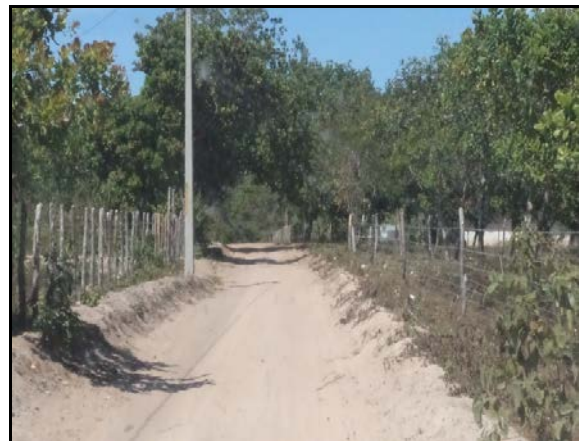
Figura 2.2.4.4.8-705 - Vicinal de acesso ao Povoado Carro Quebrado
