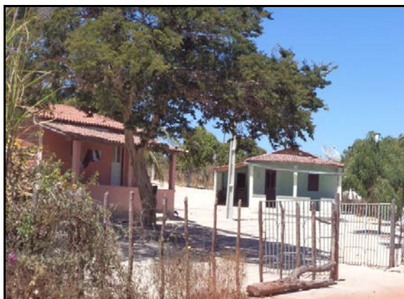
Figura 2.2.4.4.8-530 - Residências no Povoado São João
