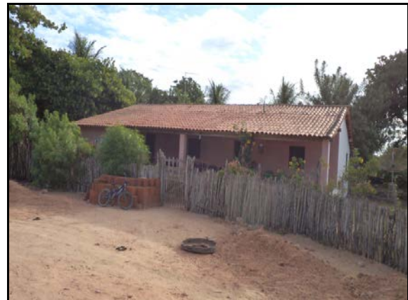
Figura 2.2.4.4.8-671 - Residência no PA Melancias
