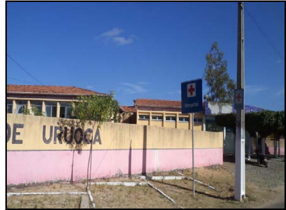
Figura 2.2.4.4.8-593 - Hospital - Sede do Município de Uruoca
