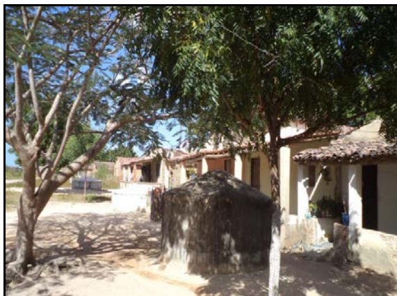
Figura 2.2.4.4.8-613 - Residências no Povoado Vila São Benedito
