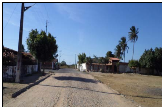
Figura 2.2.4.4.8-754 - Via e residências no Distrito de Serrote
