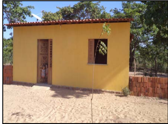
Figura 2.2.4.4.8-629 - Residência no Povoado Belém de Cima
