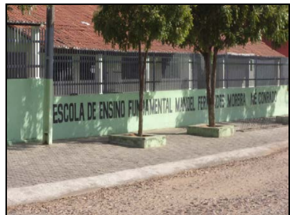
Figura 2.2.4.4.8-583 - Escola Municipal de Ensino Fundamental - Distrito Campanário
