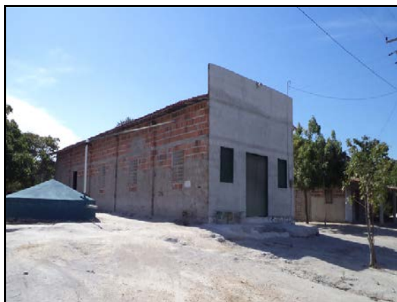
Figura 2.2.4.4.8-692 - Igreja em construção no Povoado Córrego do Tanque
