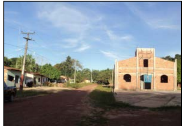
Figura 2.2.4.4.8-125 - Residências e Igreja.
