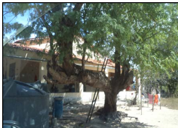
Figura 2.2.4.4.8-763 - Residência no Povoado Lagoa da Onça
