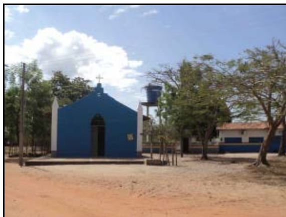
Figura 2.2.4.4.8-347 - Igreja e Escola Municipal
