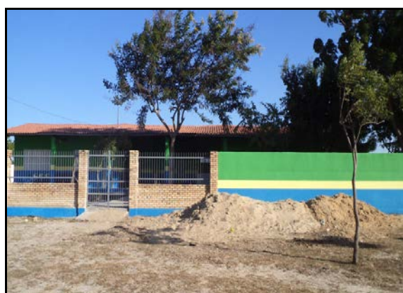
Figura 2.2.4.4.8-657 - Escola Municipal de Ensino Fundamental no PA Lagoa dos Negros
