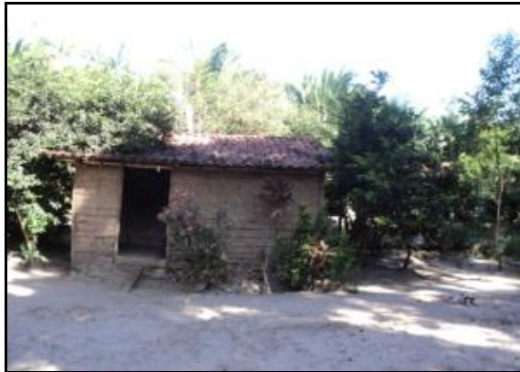
Figura 2.2.4.4.8-117 - Residência de taipa.
