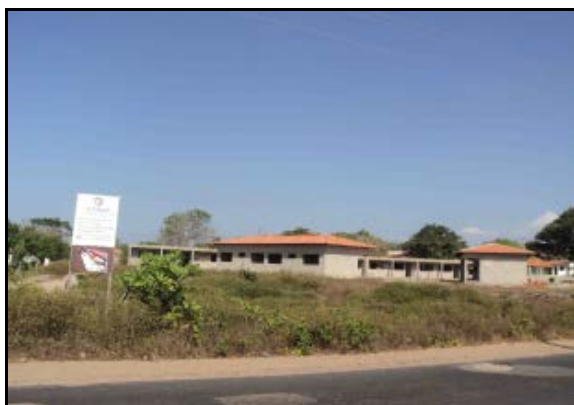
Figura 2.2.4.4.8-296 - Escola em construção
