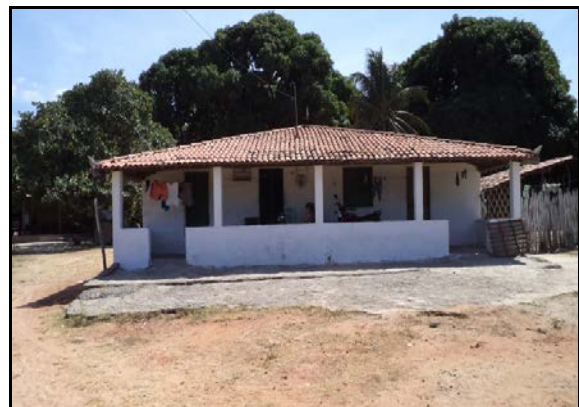
Figura 2.2.4.4.8-777 - Residência no Distrito Padre Holanda
