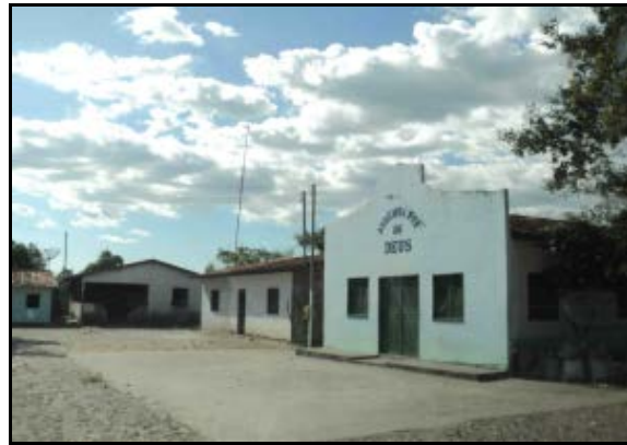
Figura 2.2.4.4.8-175 - Residências e Igreja.
