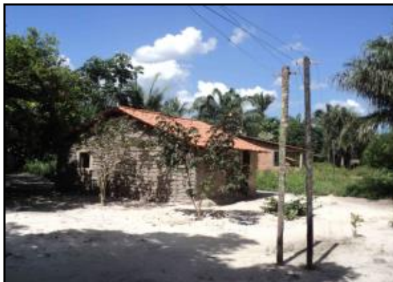
Figura 2.2.4.4.8-30 - Residência de Taipa.
