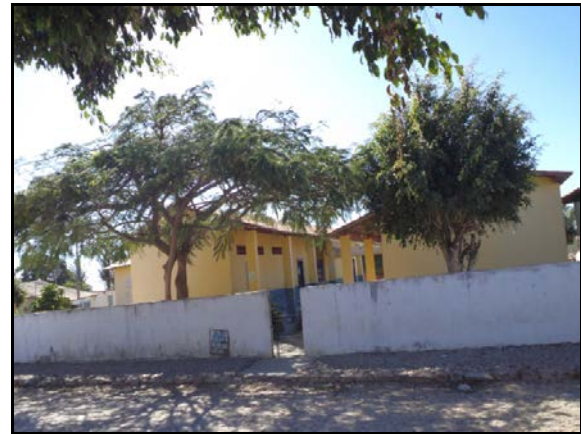
Figura 2.2.4.4.8-541 - Escola Municipal de Ensino Fundamental - Distrito de Inharim
