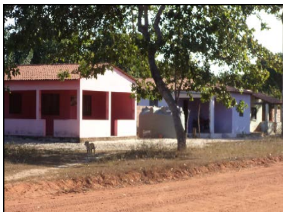
Figura 2.2.4.4.8-624 - Residências no Povoado Lagoa do Grosso
