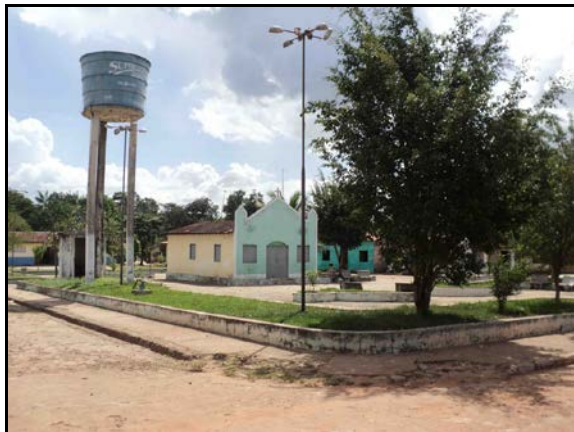
Figura 2.2.4.4.8-782 - Caixa d'Água central Boa Vista dos Pinhos - Presidente Juscelino (MA)
