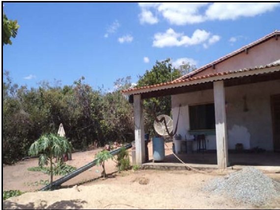
Figura 2.2.4.4.8-632 - Residência no Povoado Córrego das Varas
