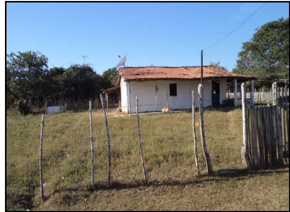
Figura 2.2.4.4.8-743 - Residência no Povoado Raposa
