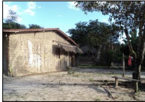
Figura 2.2.4.4.8-51 - Residência de taipa.
