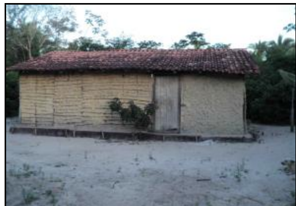
Figura 2.2.4.4.8-57 - Residência de taipa.
