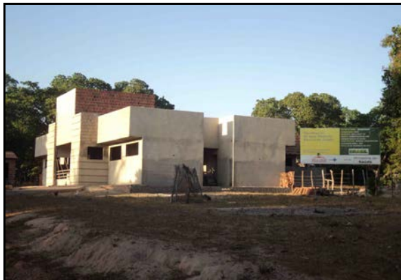
Figura 2.2.4.4.8-790 - Povoado Santo Izídio - Posto de Saúde em construção (Bela Cruz)
