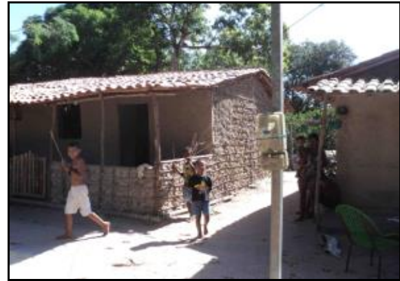
Figura 2.2.4.4.8-35 - Residência de taipa.
