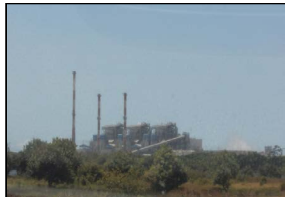
Figura 2.2.4.4.8-21 - Usina Termelétrica Pecém.
