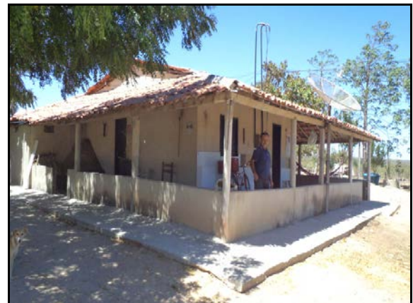
Figura 2.2.4.4.8-567 - Residência no Povoado Pedro Paulo
