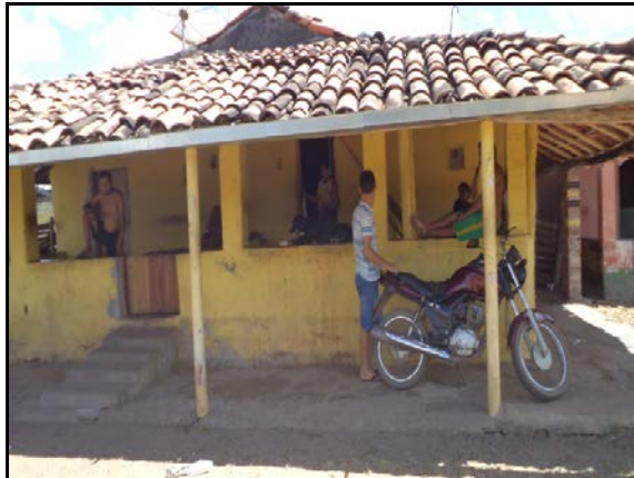
Figura 2.2.4.4.8-564 - Residência no Povoado Gado Bravo
