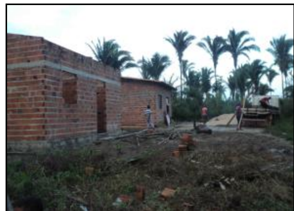
Figura 2.2.4.4.8-77 - Casas em construção.
