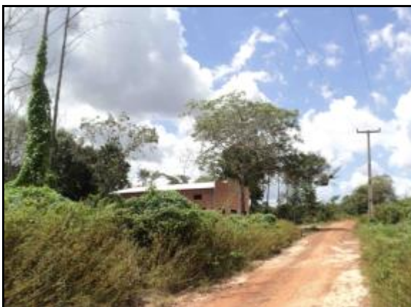
Figura 2.2.4.4.8-60 - Igreja em construção e via.
