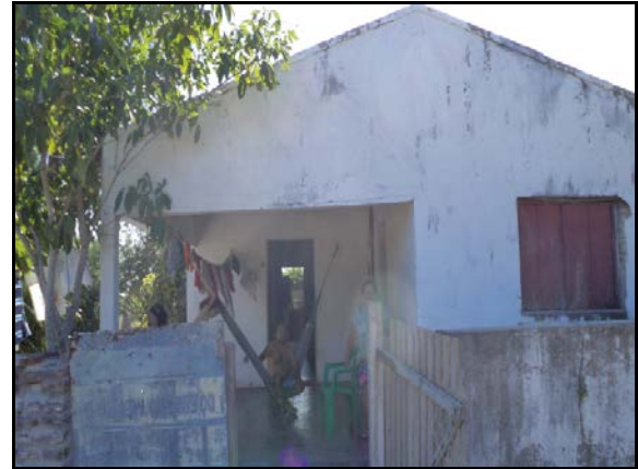
Figura 2.2.4.4.8-637 - Residência no Povoado Belém de Baixo
