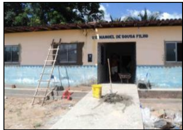
Figura 2.2.4.4.8-44 - Unidade escolar em obras - Mato Grosso.
