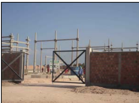
Figura 2.2.4.4.8-300 - Loteamento Parque das Dunas.
