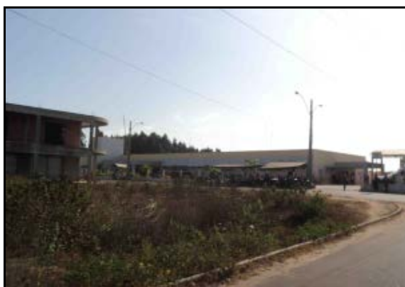
Figura 2.2.4.4.8-298 - Construção do terminal rodoviário
