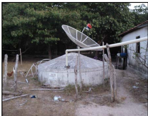
Figura 2.2.4.4.8-788 - Cisterna instalada pela ASA Barroquinha (CE)
