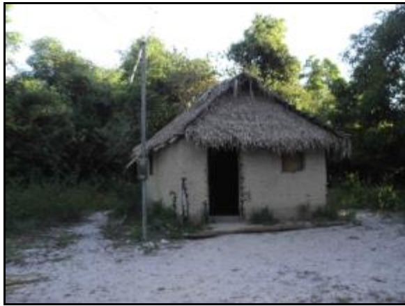
Figura 2.2.4.4.8-54 - Residência de taipa.
