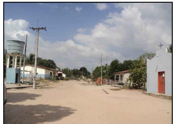
Figura 2.2.4.4.8-331 - Infraestrutura no Assentamento Belágua
