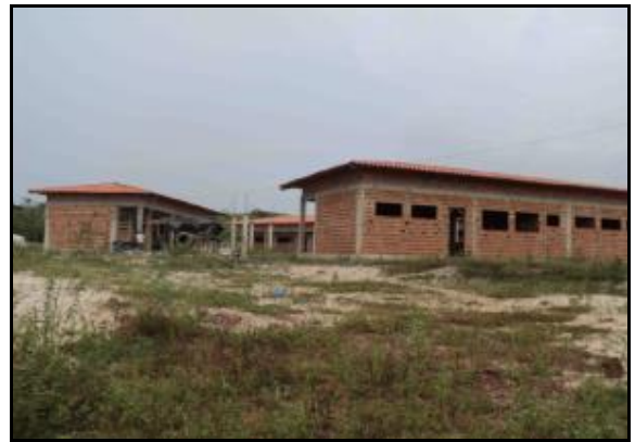
Figura 2.2.4.4.8-71 - Escola em construção.
