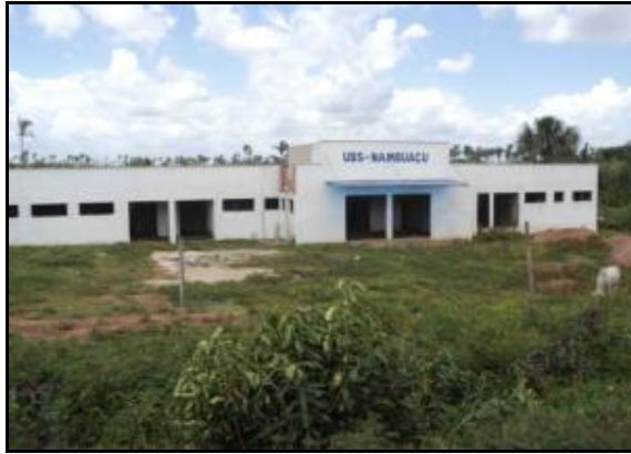
Figura 2.2.4.4.8-80 - UBS em construção.
