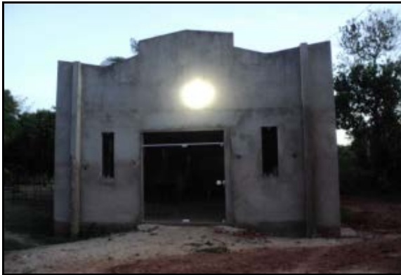
Figura 2.2.4.4.8-128 - Igreja em construção.
