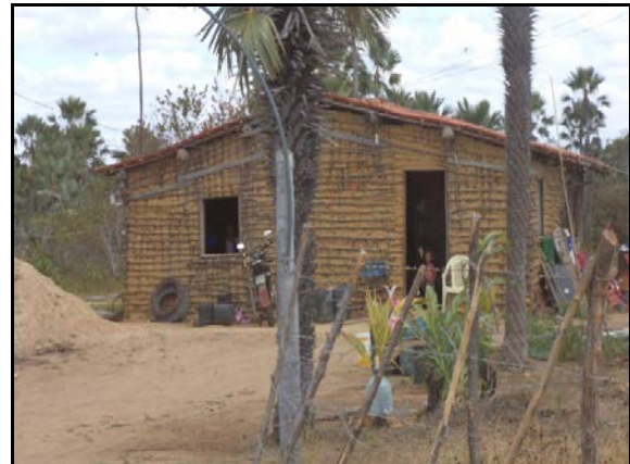
Figura 2.2.4.4.8-773 - Residência de taipa no Bairro Anil
