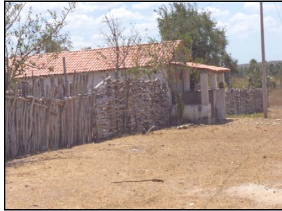
Figura 2.2.4.4.8-606 - Residência no Povoado Sítio do Joá
