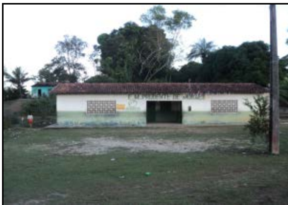
Figura 2.2.4.4.8-146 -Escola municipal - PA Pacas dos Marçal.
