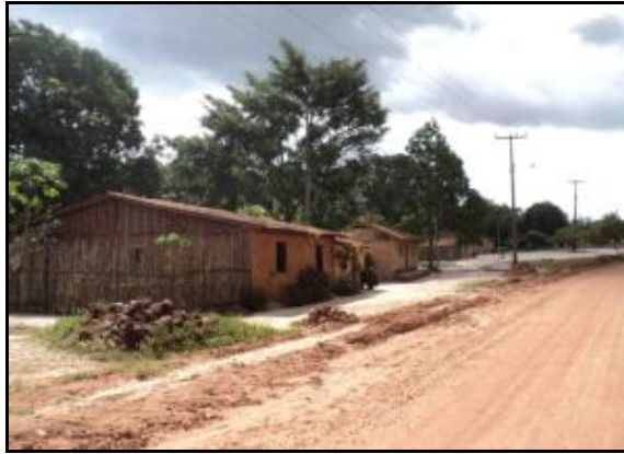
Figura 2.2.4.4.8-68 - Residência de taipa.
