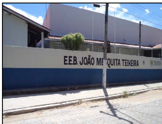
Figura 2.2.4.4.8-701 - Escola Estadual no Distrito de Barrento
