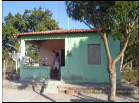
Figura 2.2.4.4.8-621 - Residência no PA Tipira
