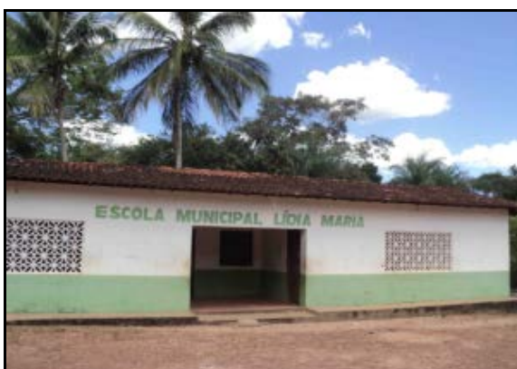
Figura 2.2.4.4.8-148 -Escola Municipal - Arruda.
