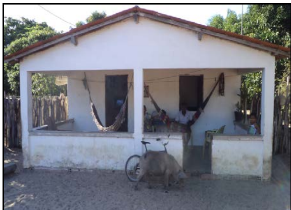
Figura 2.2.4.4.8-656 - Residência no no PA Lagoa dos Negros
