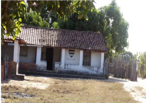
Figura 2.2.4.4.8-747 - Residência no Distrito de Jenipapo
