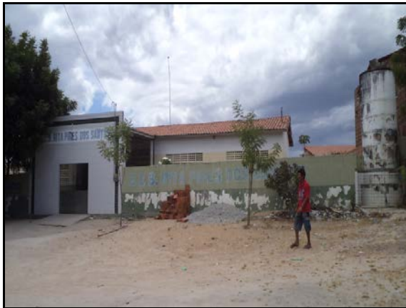
Figura 2.2.4.4.8-684 - Residência no Povoado Bulhões
