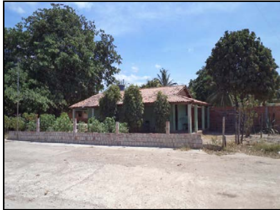
Figura 2.2.4.4.8-778 - Residência no Povoado Bolso
