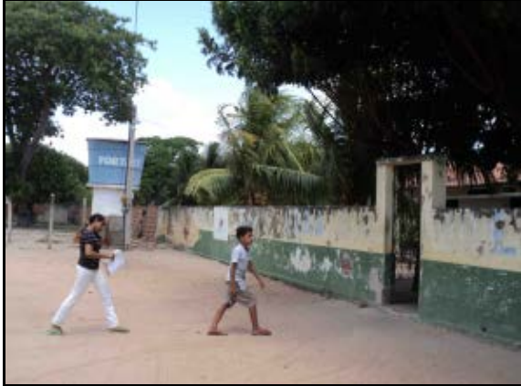
Figura 2.2.4.4.8-517 - Escola Municipal - Povoado Cambota
