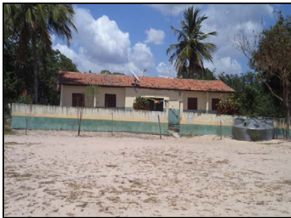
Figura 2.2.4.4.8-615 - Escola Municipal de Ensino Fundamental - Povoado Baixa Nova
