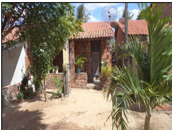
Figura 2.2.4.4.8-768 - Residência no Bairro Planalto Marituba
