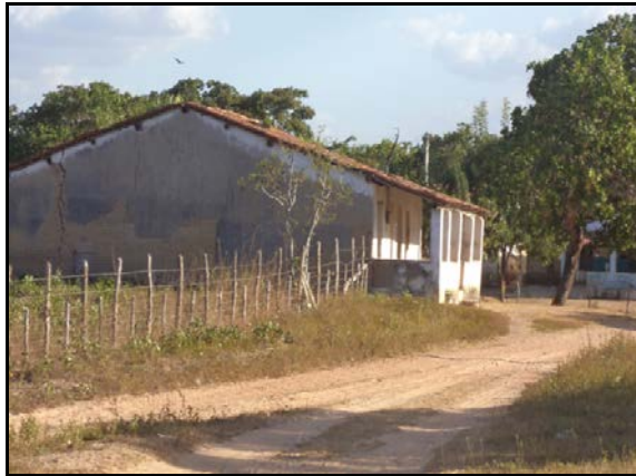
Figura 2.2.4.4.8-611 - Residência no Povoado Solidão
