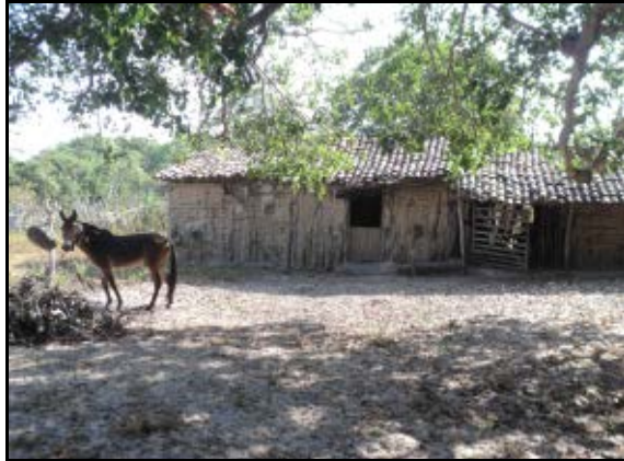
Figura 2.2.4.4.8-454 - Residência de taipa
