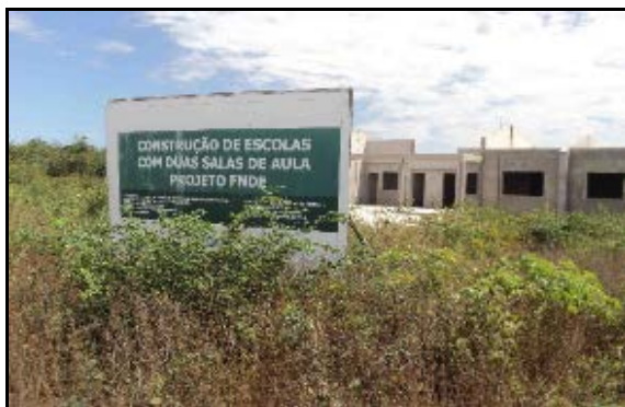
Figura 2.2.4.4.8-230 -Escola em construção
