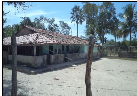
Figura 2.2.4.4.8-762 - Residência no Povoado Alto do Tigre
