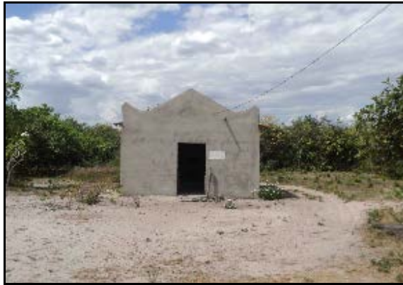
Figura 2.2.4.4.8-228 -Igreja em construção
