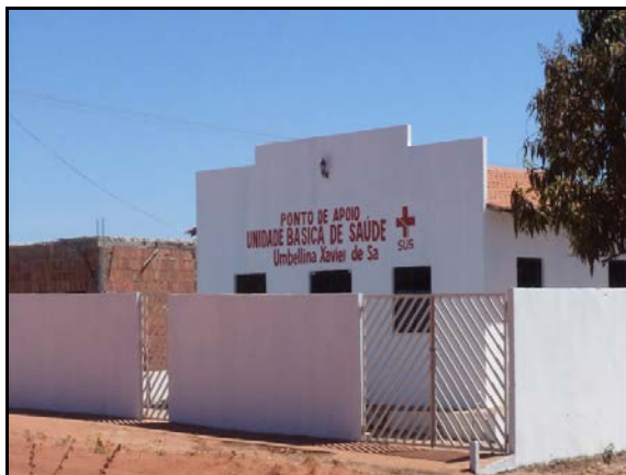
Figura 2.2.4.4.8-534 - Ponto de Apoio - UBS - PA Tucuns
