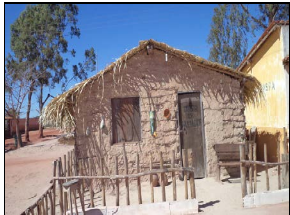
Figura 2.2.4.4.8-529 - Casa da Memória- Projeto de Assentamento Valparaíso
