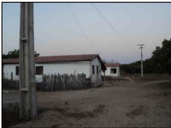
Figura 2.2.4.4.8-474 - Residências no PA
