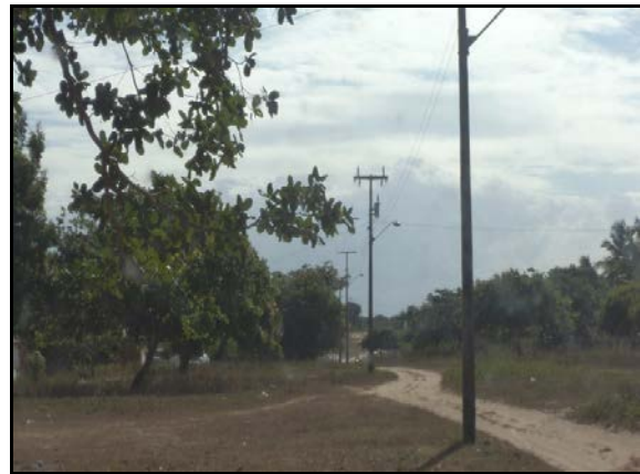
Figura 2.2.4.4.8-669 - Via de acesso ao PA Lagoa dos Veados
