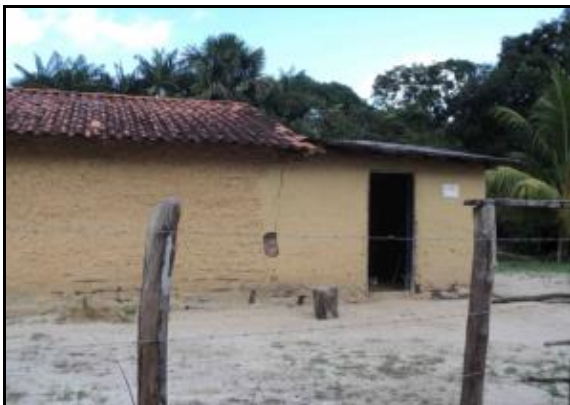
Figura 2.2.4.4.8-84 - Residência de taipa.
