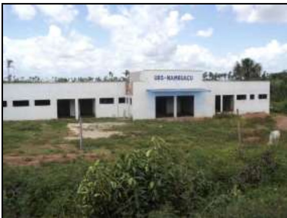
Figura 2.2.4.4.1-3 - Unidade Básica de Saúde em construção. Nambuaçu - Rosário (MA)
