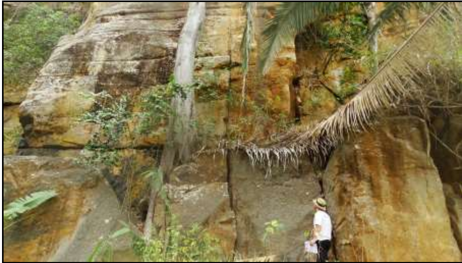
Figura 2.2.2.9-50 - Ocorrência de pequenas fendas que se desenvolvem aproveitando o faturamento das rochas. A altura do paredão no local do ponto é de aproximadamente 30 metros.
