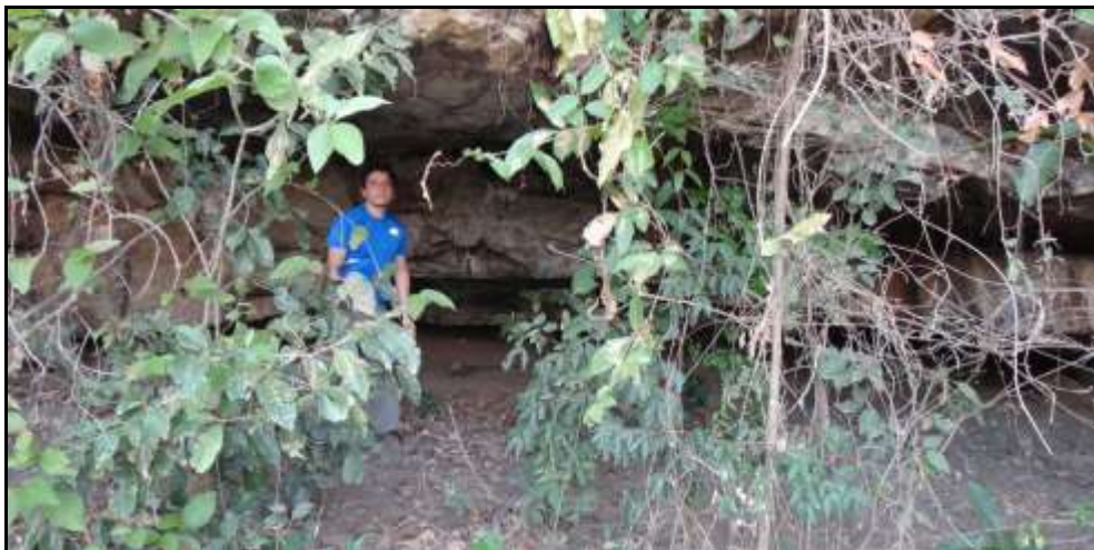
Figura 2.2.2.9-43 - Ponto cav. 31 representado por pequenos abrigos na base do maciço arenítico.
