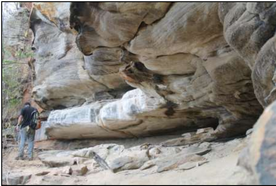
Figura 2.2.2.9-18 - Ponto cav. 10 mostrando um paredão arenítico com abrigos na base.
