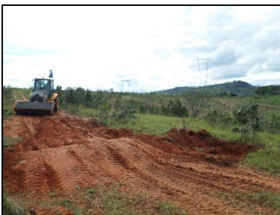
Figura 1.4-10 - Construção de camalhão com caixa de captação e construção de camalhão com saída d'água ("bigodes").
