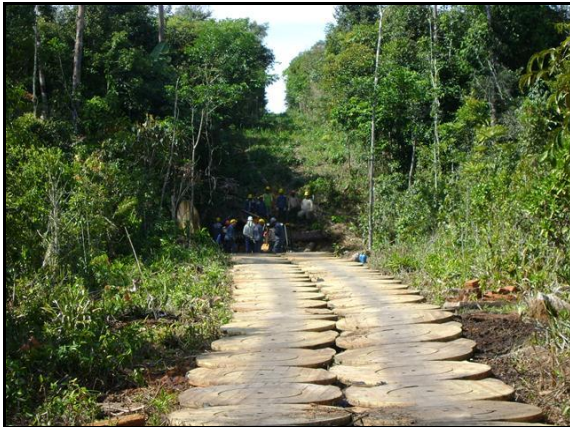
Figura 1.4-16 - Durante e depois da construção de acessos temporários em áreas florestadas utilizando estivas.
