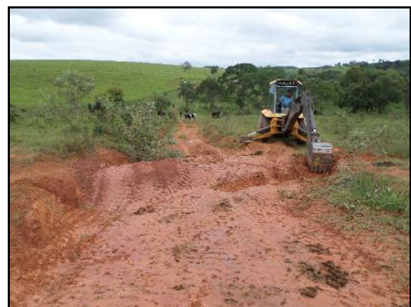
Figura 1.4-10 - Construção de camalhão com caixa de captação e construção de camalhão com saída d'água ("bigodes").
