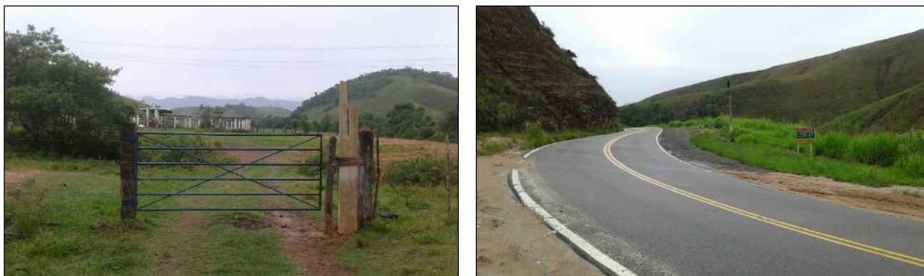
Figura 6.4.177. Rodovia RJ-155 (à esquerda) e propriedade rural fechada (à direita), em área rural do município de Barra Mansa/RJ.
