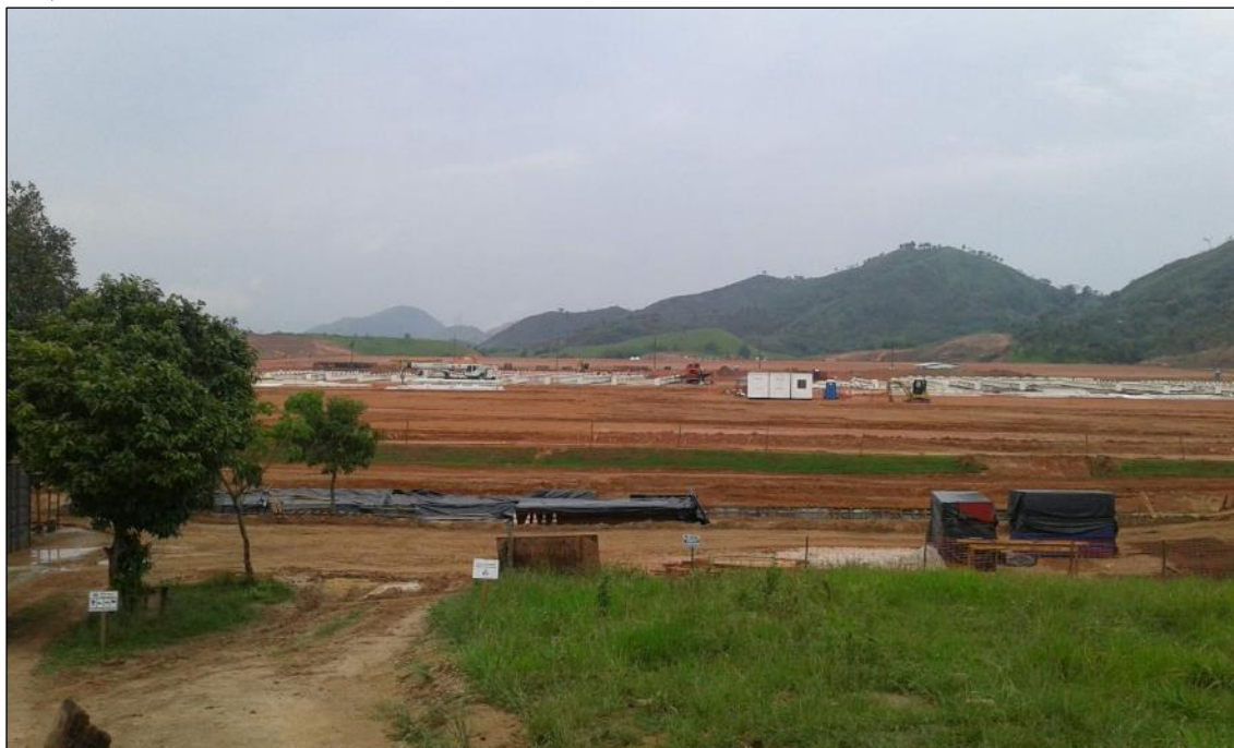
Figura 6.4.192. Situação da construção da SE Terminal Rio em novembro de 2017, em Paracambi/RJ.
