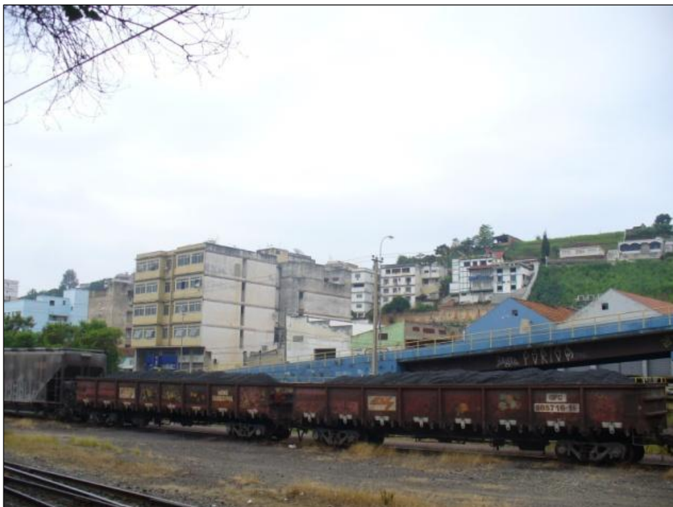
Figura 6.4.10. Edificações no município de Barra Mansa/RJ.
