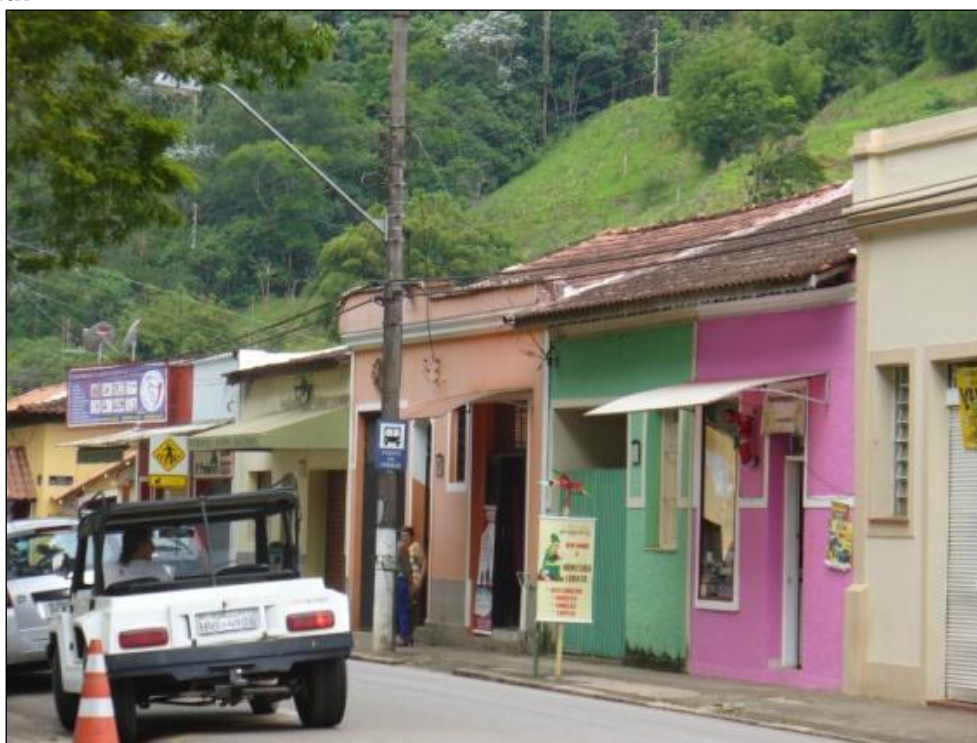
Figura 6.4.11. Edificações no município de Monteiro Lobato/SP.
