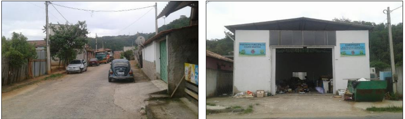
Figura 6.4.187. Vias internas (à esquerda) e unidade de triagem de resíduos sólidos (à direita), na localidade Verde Vale em Pirai/RJ.
