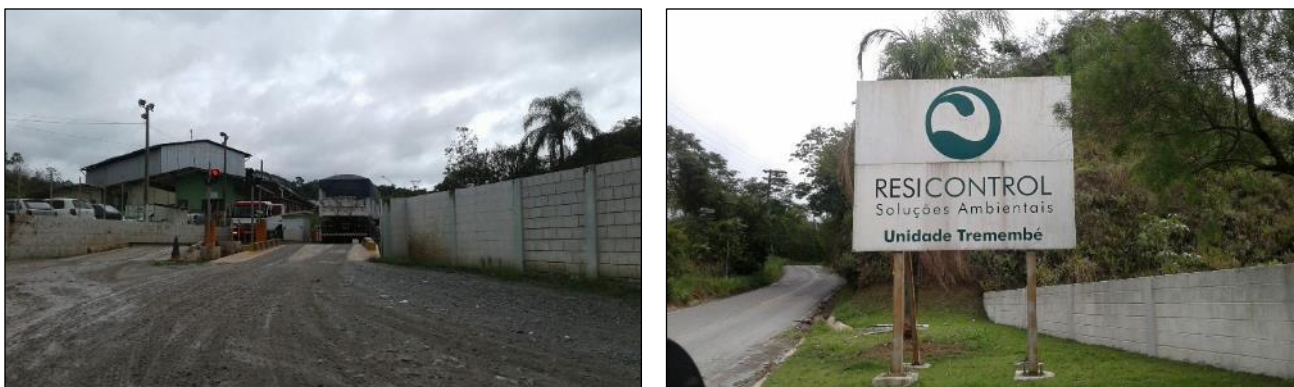
Figura 6.4.118. Aterro Sanitário de Tremembé/SP, localizado a aproximadamente 1,5 km do Corredor de Estudo.
