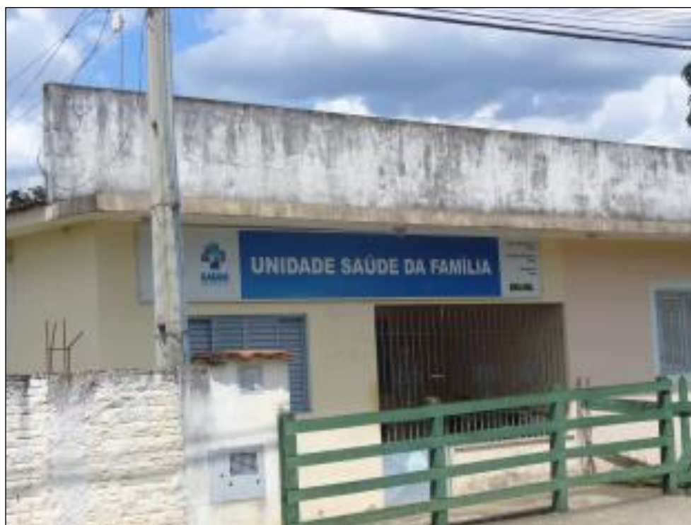
Figura 6.4.33. USF em Arapeí/SP.
