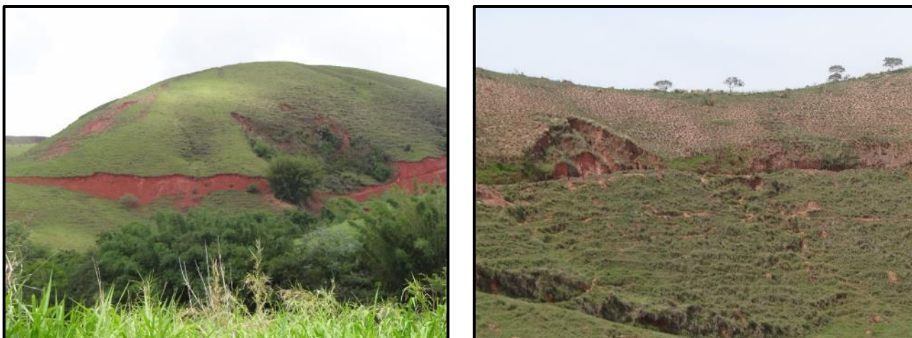
Figura 6.2.63. Exemplos de movimentos de massa encontrados ao longo da AE.
