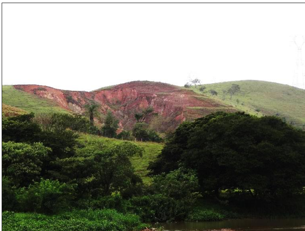
Figura 6.2.52. Avançado nível de erosão (voçoroca) em modelado de disseção da Depressão do Médio Paraíba do Sul, com localização próxima ao eixo da LT, no município de Cachoeira Paulista/SP.
