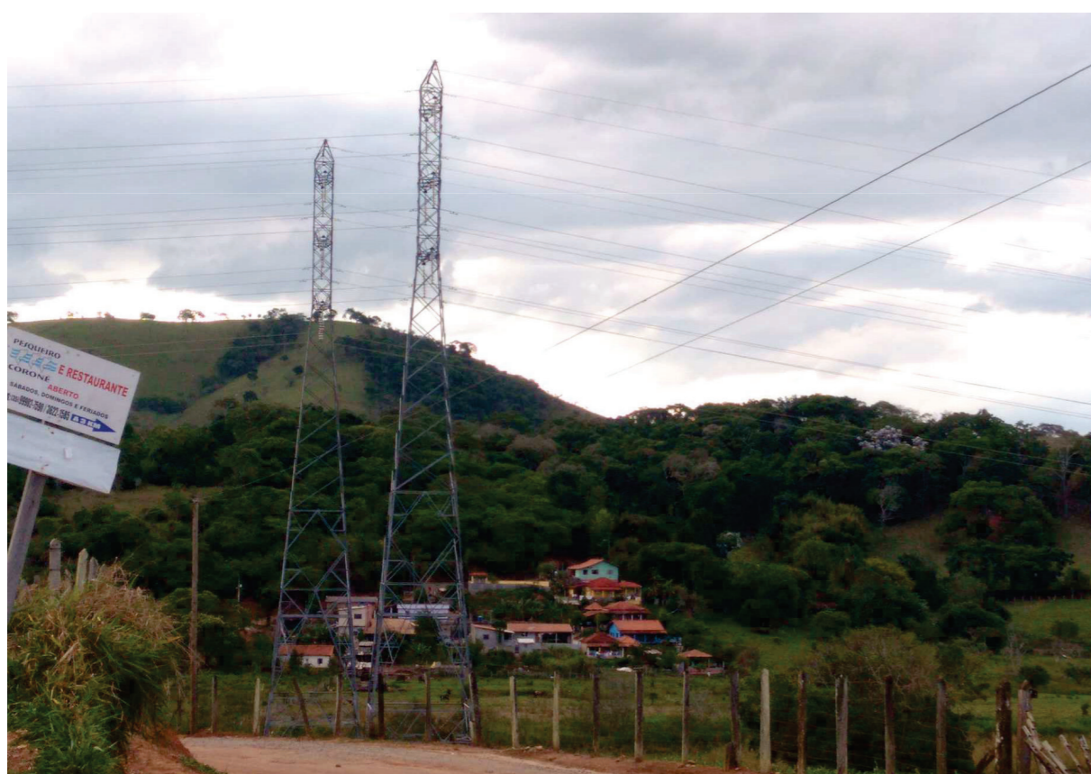
Vista Geral da Zona Rural de Itajubá-MG Acesso a Subestação da CEMIG
