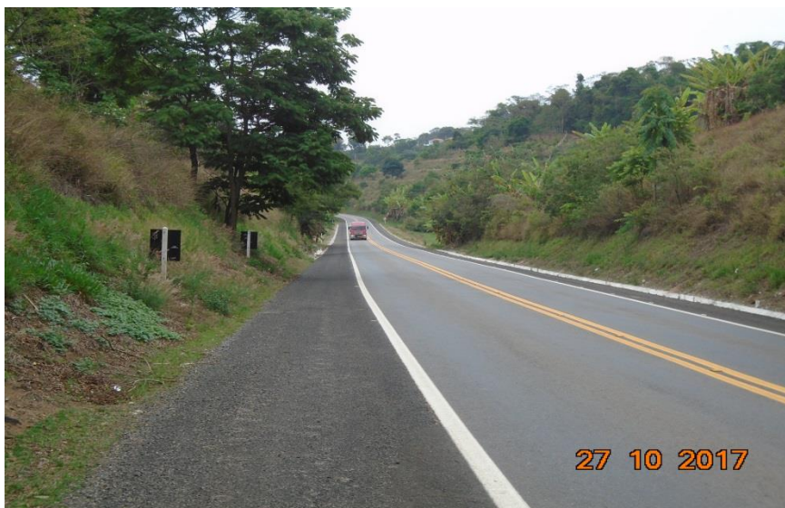
Figura 6.4.8-28 - Rodovia BR-267 – Campestre, Sentido Machado
