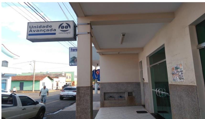
Figura 6.4.8-19 – COOXUPÉ - Escritório em Monte Belo
