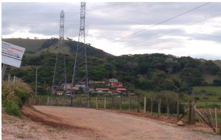
Figura 6.4.3-4 - Vista Geral da Área Rural de Itajubá, Próximo à Subestação da CEMIG.
