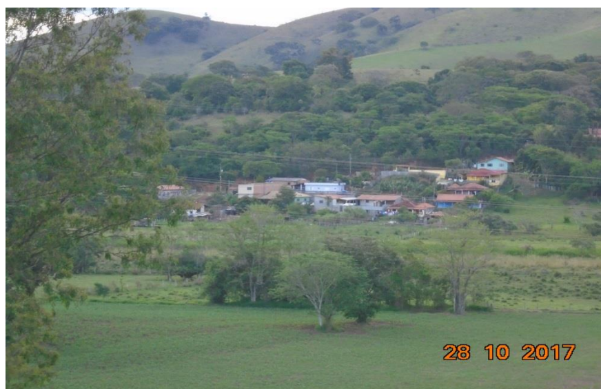
Figura 6.4.3-3 - Vista Geral da Área Rural de Piranguinho.
