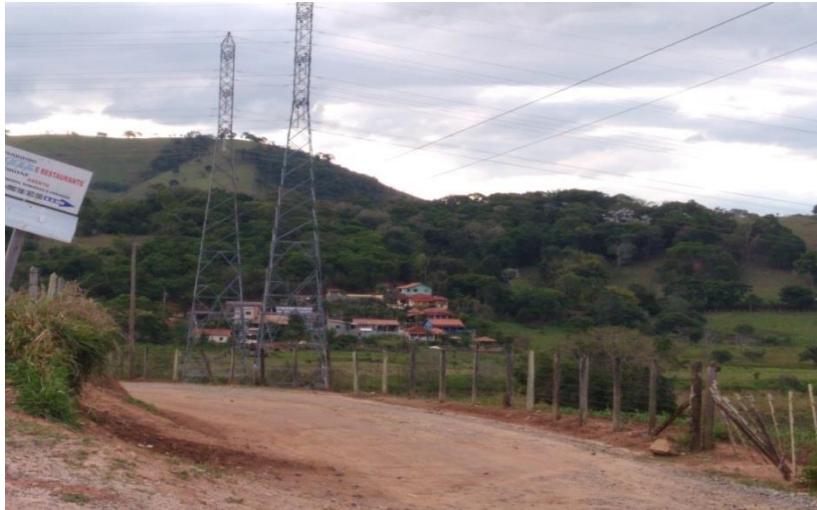
Figura 6.4.8-53 - Vista da Área Rural de Itajubá, Próximo à Subestação da CEMIG.
