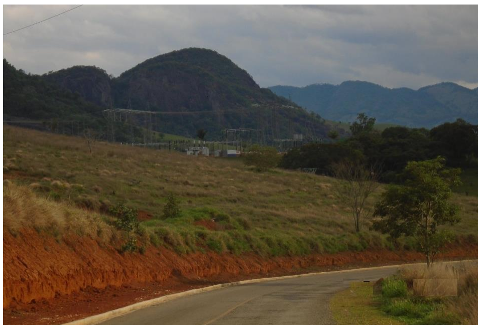
Figura 6.2.3-36 - Perfil de Argissolo Vermelho (PVd1) de talude de corte de estrada
