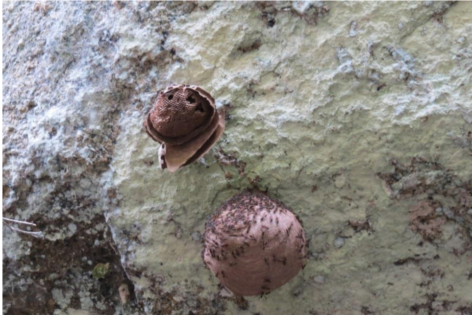
Figura 6.2.5-22 - Detalhe da colmeia de vespas presentes na entrada da Gruta da PCH Poço Fundo
