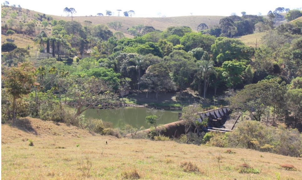
Figura 6.2.2-4 - Margens do rio Machado, junto ao barramento da UHE Poço Fundo
