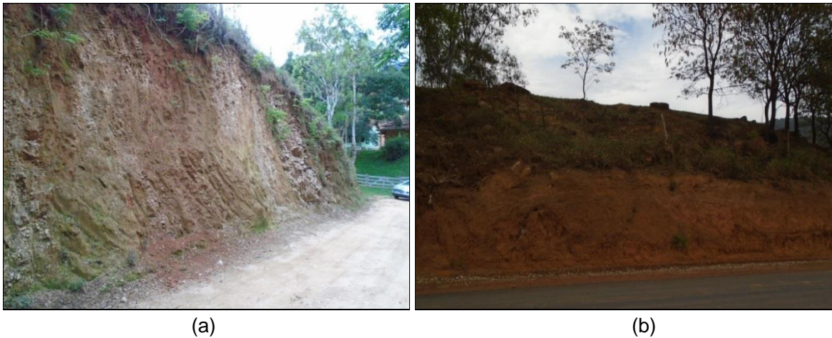
Figura 6.2.3-37 - (a) e (b) Perfis de Argissolo Vermelho Amarelo (PVAd8) de talude de corte de estrada.
