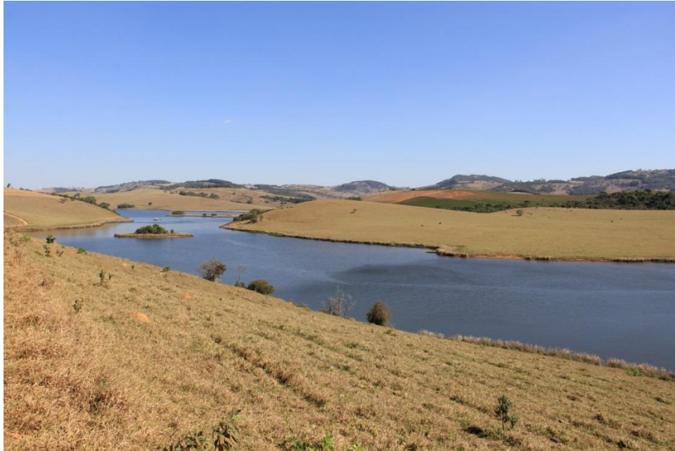
Figura 6.2.2-5 - Vista geral de um trecho do reservatório da UHE Poço Fundo, onde o traçado da LT passará.
