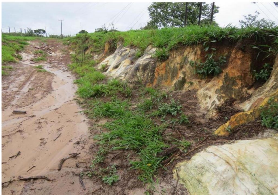
Figura 6.2.3-33 - Perfil de Neossolo Litólico em beira de estrada de terra
