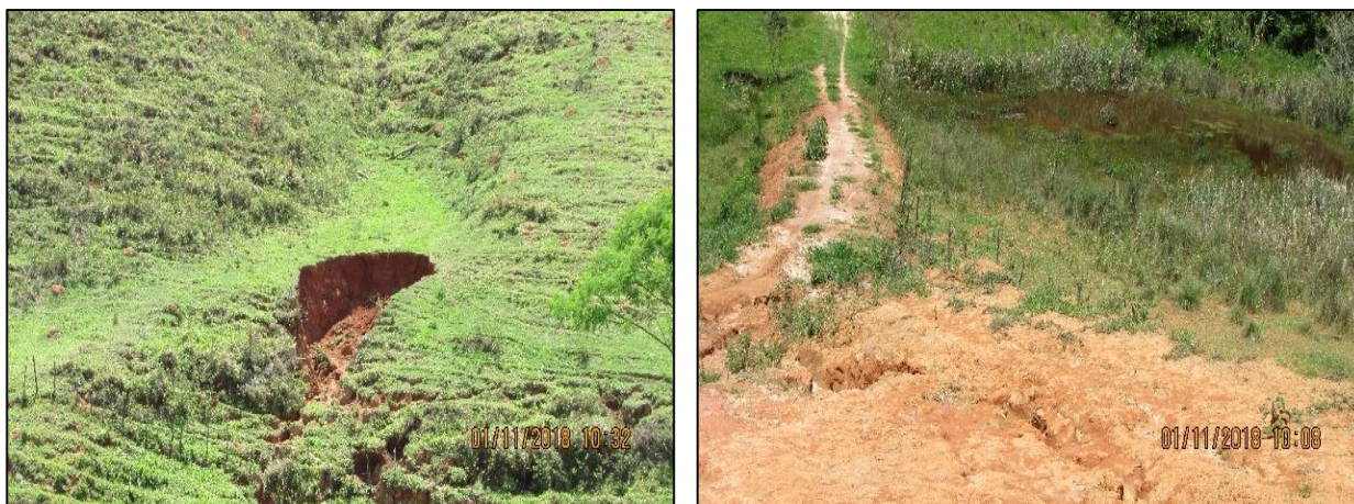
Figura 101 - Processos erosivos na ADA da LT
