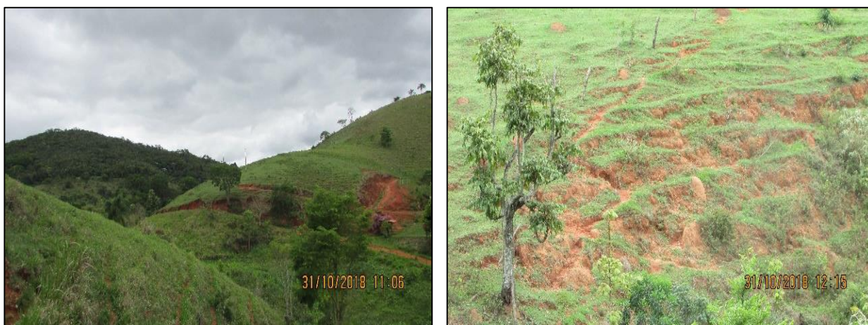
Figura 99 - Processos erosivos na ADA da LT
