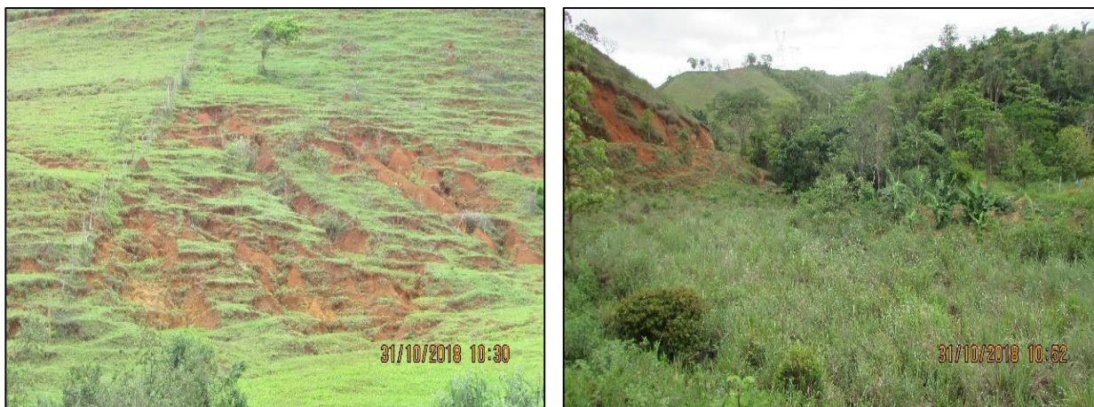
Figura 98 - Processos erosivos na ADA da LT
