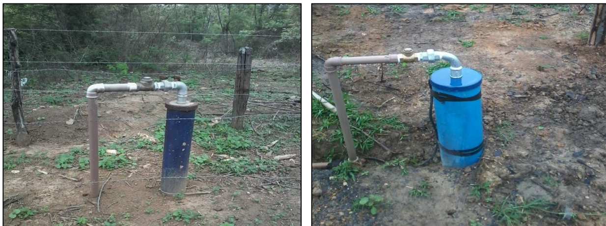
Figura 131 - Poços tubulares na ADA da LT
