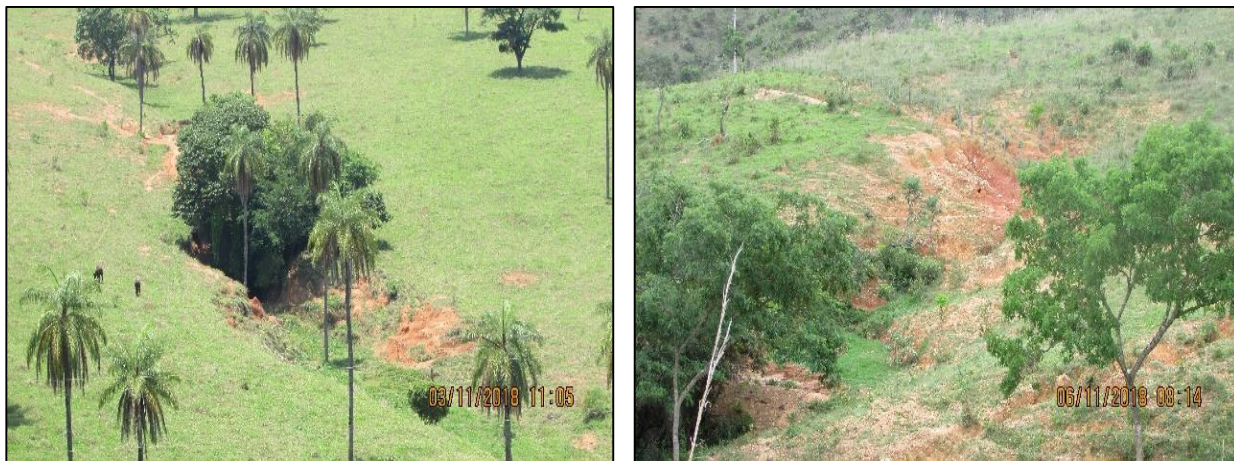
Figura 86 - Processos erosivos na ADA da LT UTM 23K, 638.977E/7.848.088N e 627.359E/7.879.643N
