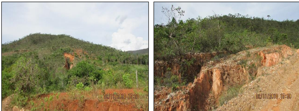
Figura 95 - Processo erosivo na ADA da LT
