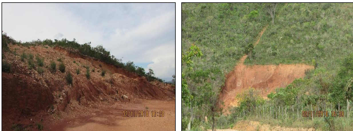
Figura 96 - Processos erosivos na ADA da LT
