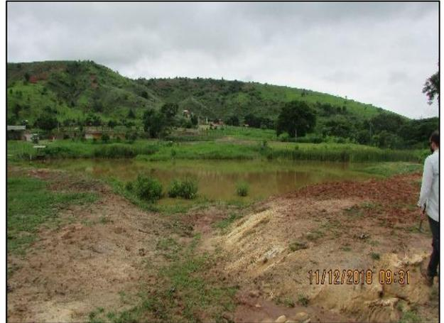
**Figura 100 - Processos erosivos em Argissolo Vermelho Escuro na ADA da LT**
