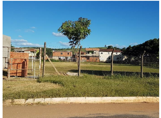
Figura 224 - Campo de Futebol no município de Governador Valadares, Povoado de São Vitor
