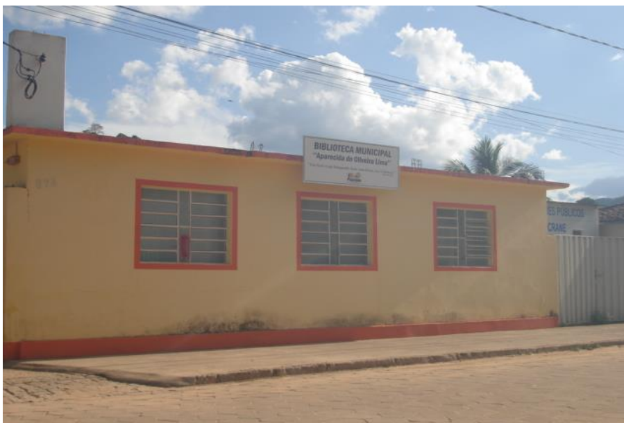
Figura 138 - Biblioteca Municipal em Pocrane
