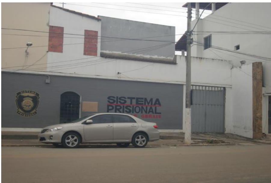
Figura 80 - Fachada do Sistema Prisional de Conselheiro Pena
