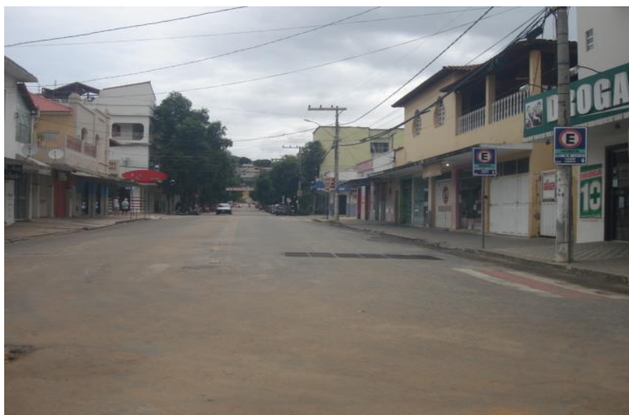
Figura 152 - Sarjeta para escoamento de água pluvial em Conselheiro Pena
