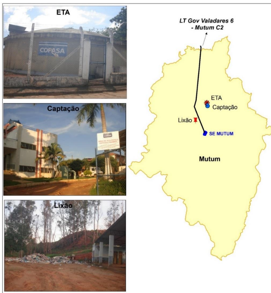
Figura 160 - Infraestrutura de saneamento básico de Mutum
