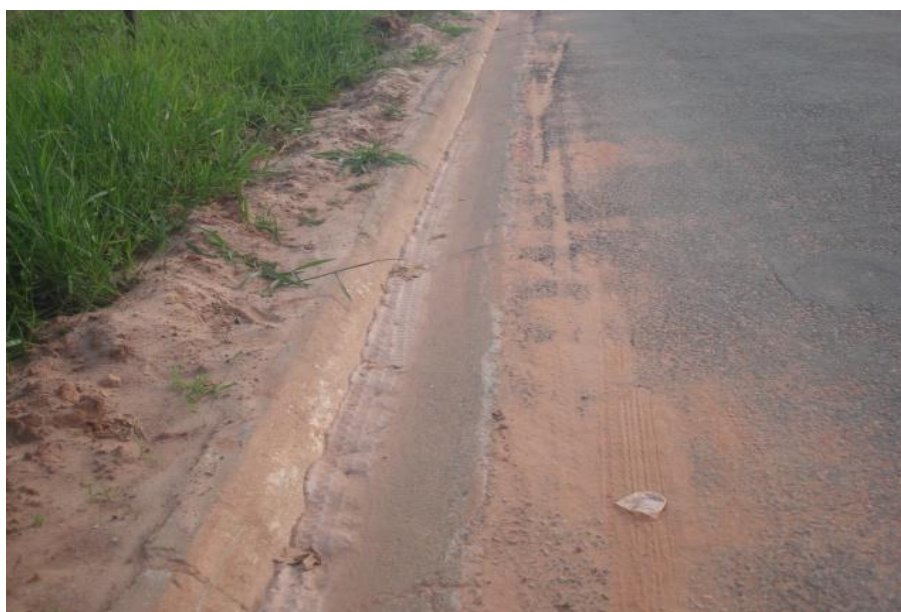
Figura 156 - Sarjeta para escoamento de água pluvial, Pocrane
