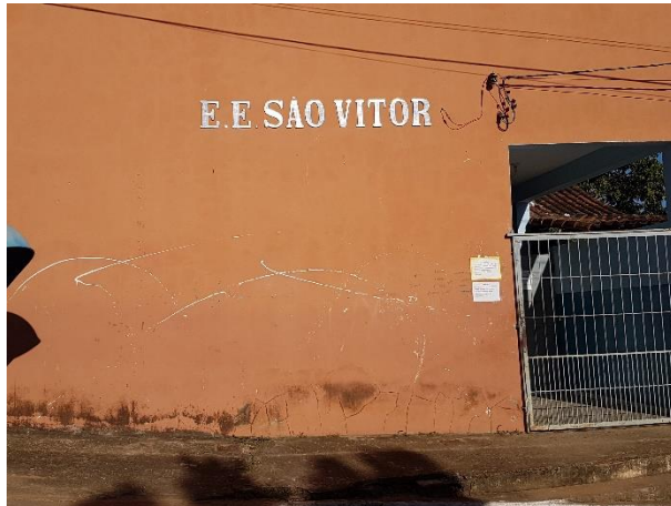
Figura 223 - Escola Estadual São Vitor, no povoado de São Vitor, município de Governador Valadares
