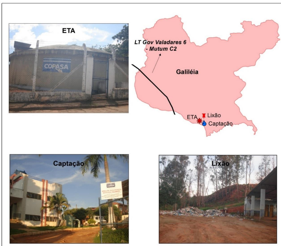
Figura 149 - Infraestrutura de saneamento básico de Galiléia
