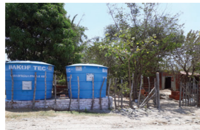
Abastecimento de Água, Bom Retiro II, Pacatuba/CE.
