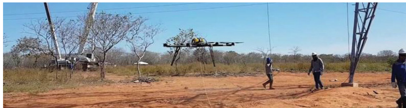
Lançamento de cabos com o auxílio de drone.
