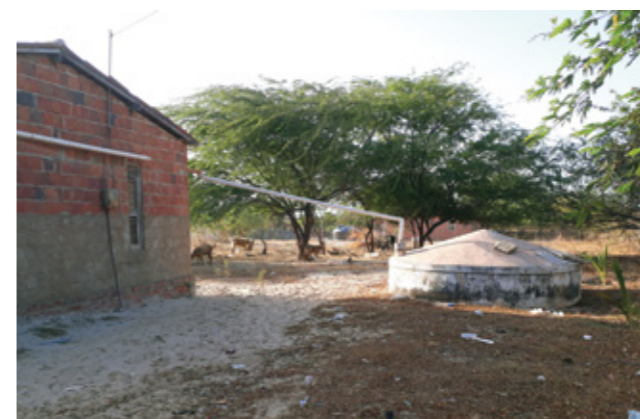
Abastecimento de água por cisterna PA Vila Nova, Icapuí/CE.
