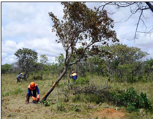
Figura 3. Supressão semimecanizada de vegetação com destaque para o corte direcionado (esquerda) e seccionamento e de galhadas (direita). Fonte: Cymi.
