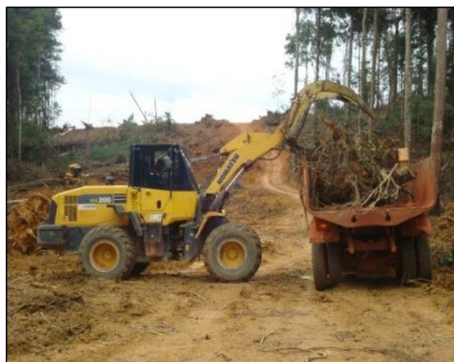
Figura 10. Empilhamento de madeira no limite externo da faixa de serviço (esquerda) e Carregadeira de garfo utilizada para empilhamento de material lenhoso (direita). Fonte: Cymi.
