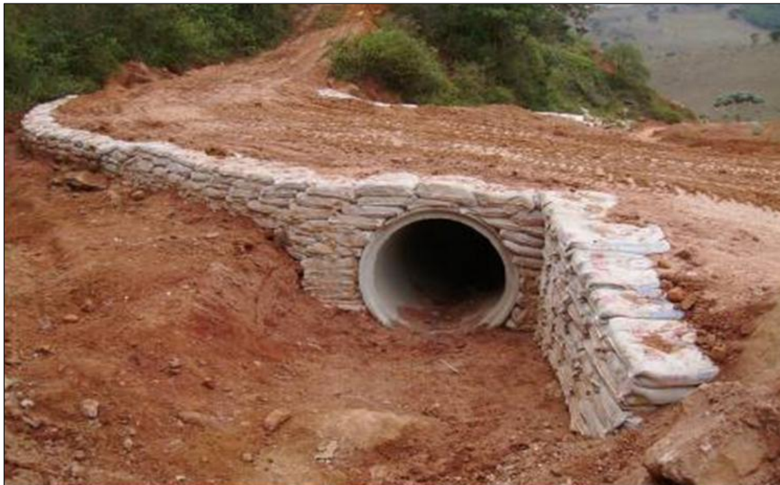
Figura 5. Dispositivo de drenagem (bueiro) ou passagem d'água superficial com acabamento em solo-cimento envelopado, em acesso construído para a implantação de uma LT.
