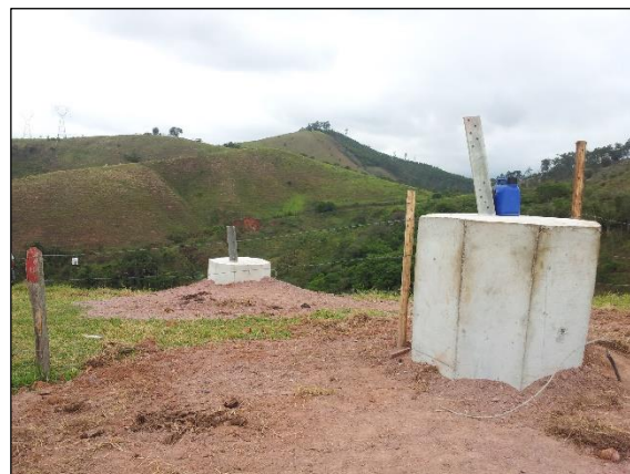
Figura 6. Concretagem de base para torre autoportante finalizada.
