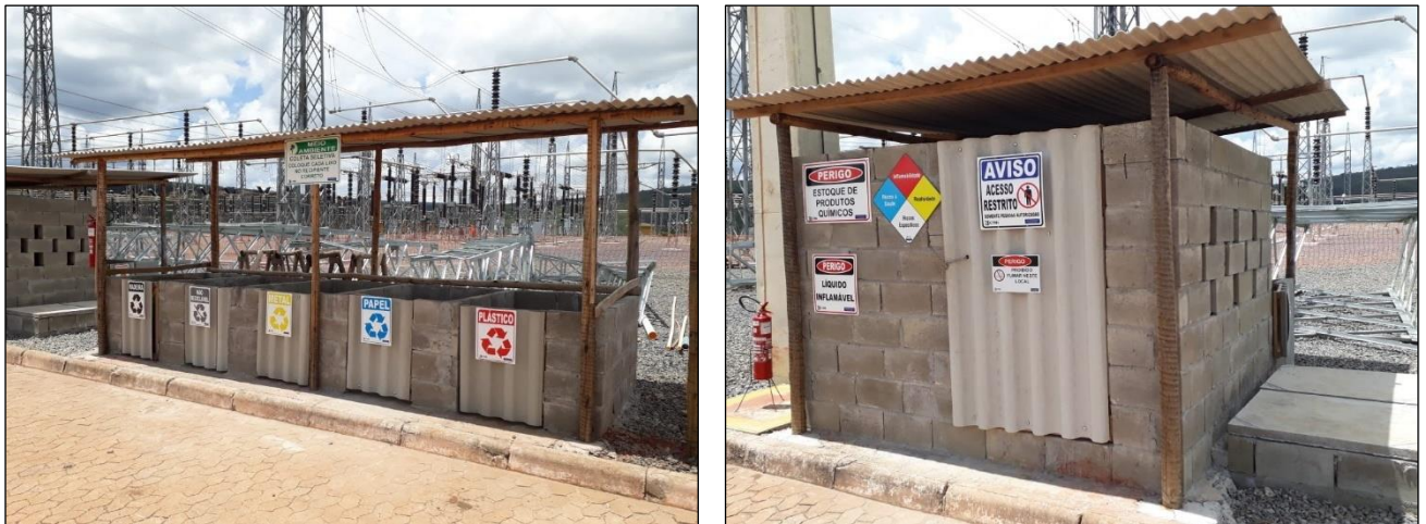
Figura 2. Exemplo de Armazenamento Temporário em Canteiros de Obra.
