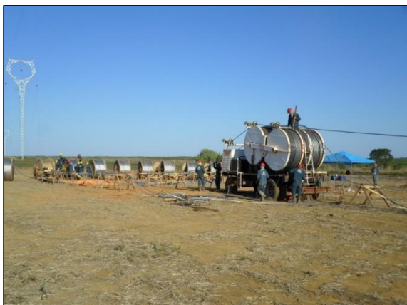
Figura 11. Praça do freio (visão lateral), bobinas e os blocos de ancoragem dos cabos lançados. Figura 12. Instalação dos cabos após lançamento.
