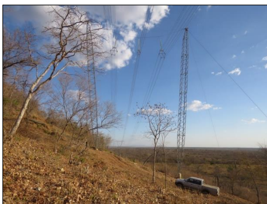
Figura 7. Exemplo de torre estaiada locada em área íngreme com bases diferenciadas para nivelamento.
