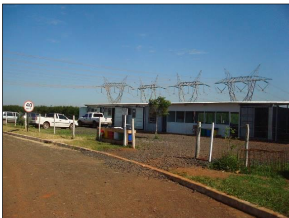
Figura 3. Exemplo de canteiro de obra.
