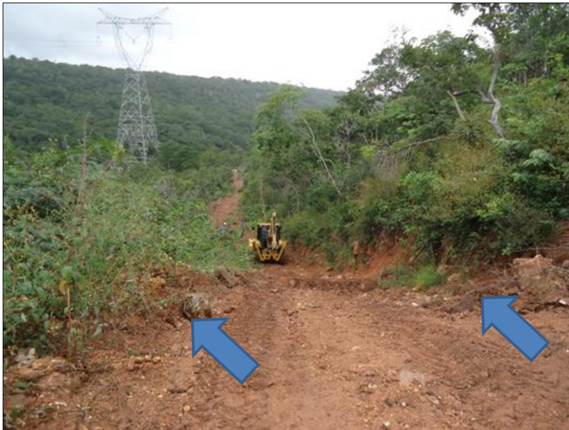
Figura 9. Dispositivos de dissipação de energia das águas do escoamento superficial, com destaque para camalhão para a prevenção de processos erosivos nos acessos.
