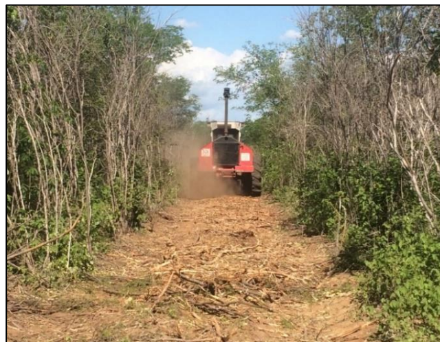
Figura 6. Detalhe do implemento DAF (esquerda) e equipamento acoplado ao implemento DAF realizando a supressão mecanizada de faixa de serviço. Fonte: Cymi.
