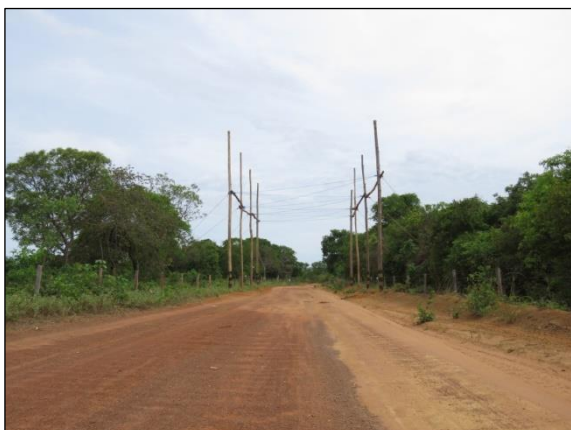
Figura 9. Instalação de cavalete (empolcadura) para lançamento de cabos em uma travessia de estrada.
