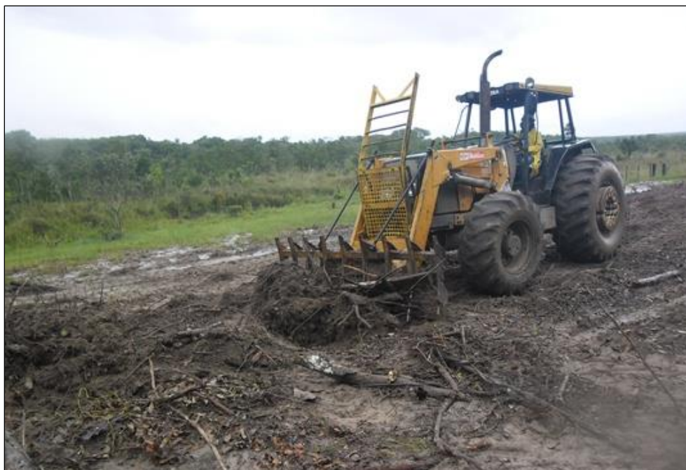
Figura 11. Trator equipado com grade de limpeza fazendo a remoção de resíduos. Fonte: Status, 2011.
