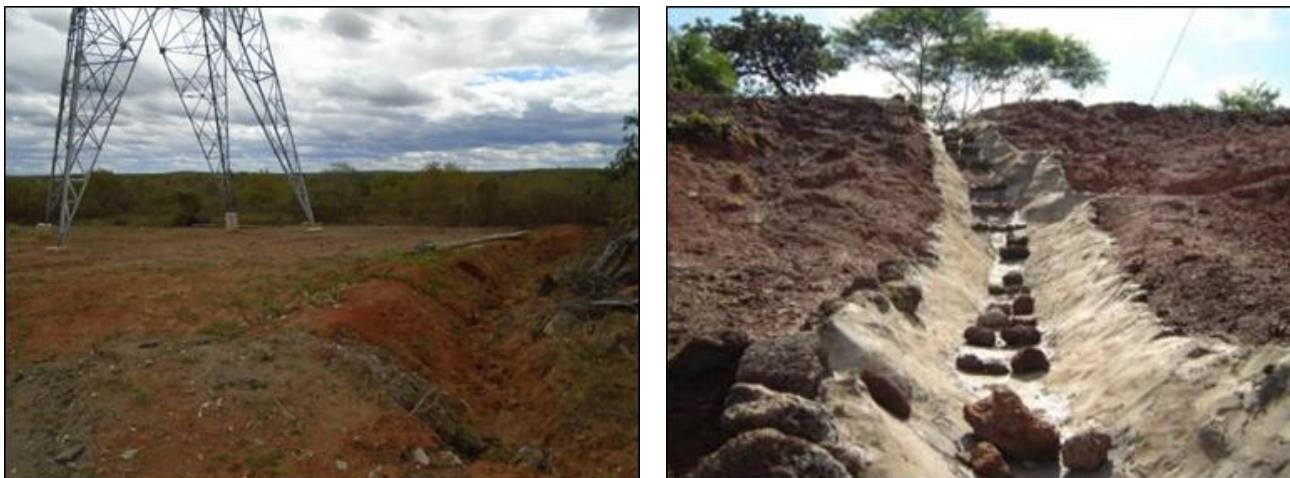
Figura 1. Dispositivo provisório de drenagem, implantado próximo à praça da torre (esquerda), e canaleta de drenagem definitiva em concreto (direita).
