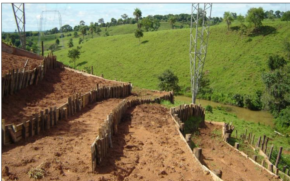
Figura 4. Vista aproximada de dispositivos provisórios de erosão (madeira de supressão de vegetação), conformando banquetas de base estreita para controle das águas de drenagem superficial, para posterior revegetação, no âmbito do PRADA (outra LT).
