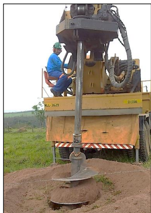
Figura 5. Perfuração de uma fundação tipo helicoidal.
