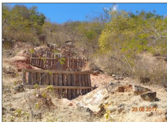
Figura 1. Exemplos de dispositivos provisórios de drenagem.
