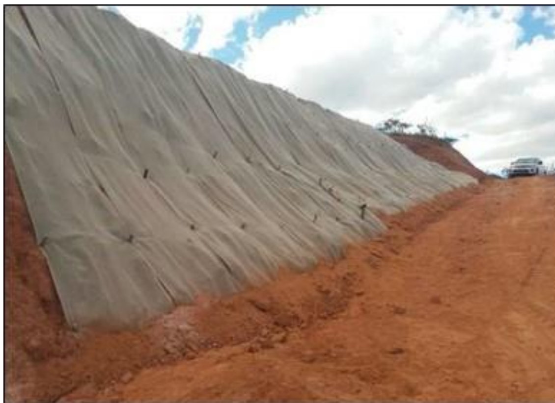
Figura 7. Revegetação do solo utilizando como medida complementar a manta geotêxtil.
