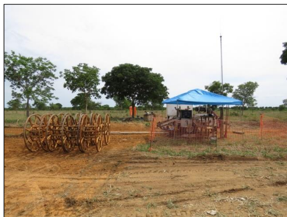
Figura 10. Praça do puller (visão lateral) e bobinas do cabo piloto armazenadas no local.
