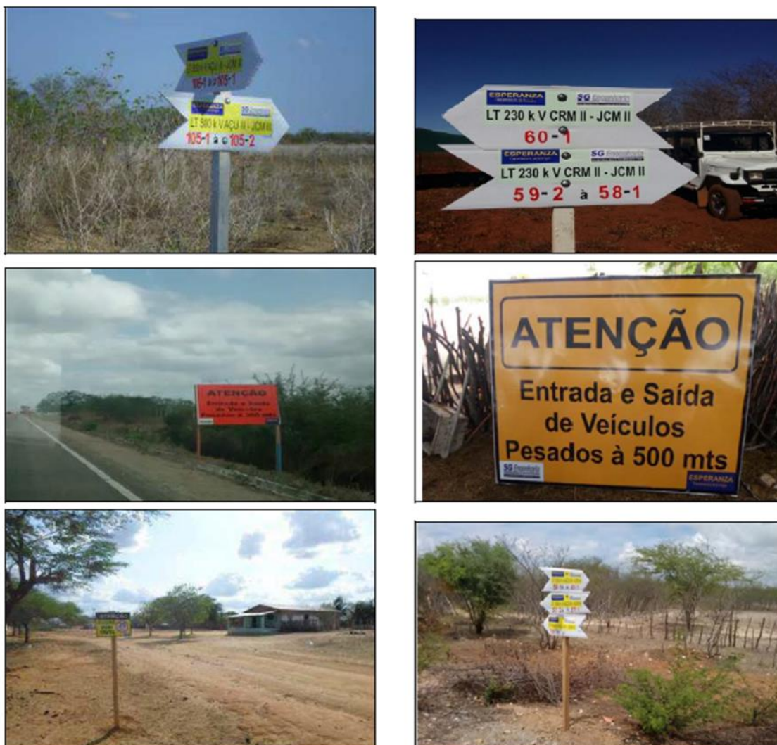
Figura 1. Exemplo de placas de sinalização instaladas nas proximidades da obra.
