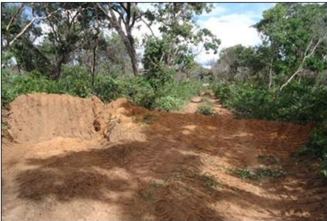
Figura 8. Estrutura de contenção de sedimentos do tipo barreira em nível, construída em acesso.
