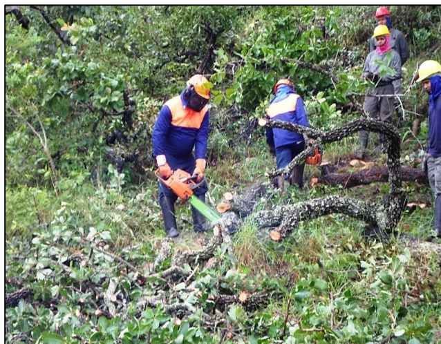
Figura 3. Supressão semimecanizada de vegetação com destaque para o corte direcionado (esquerda) e seccionamento e de galhadas (direita). Fonte: Cymi.
