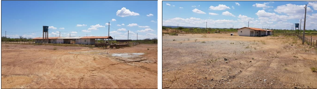
Figura 6. Vista geral da estrutura já existente no Canteiro de Obra de Queimada Nova/PI. Fonte: Sertaneja, 2018.
