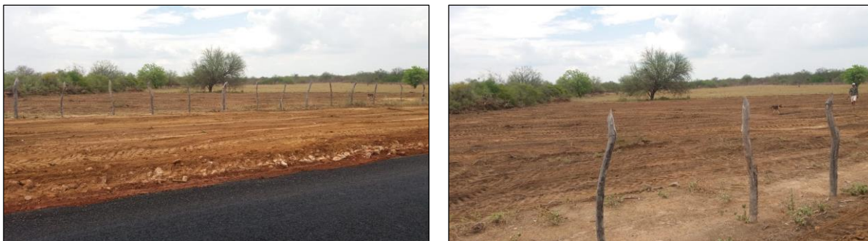
Figura 2. Vista geral do terreno pretendido para o Canteiro de Obra de Dom Inocência/PI. Fonte: Sertaneja, 2018.
