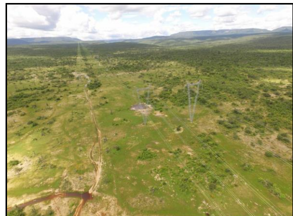
Figura 2.2.2.11-14 - Área aplanada próximo ao contato de litologias do Grupo Serra Grande e Formação Pimenteiras, no município de Ibiapina - CE. Coordenadas UTM 24 m 255137E 9556241N
