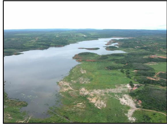
Figura 2.2.2.11-11 - Região de relevo plano próximo a SE Tianguá II, no município de Tianguá - CE. Coordenadas UTM 24 m 266316E 9576426N
