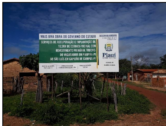
Figura 2.2.4.11-8 - Obras na estrada de acesso à CRQ Vaquejador.
