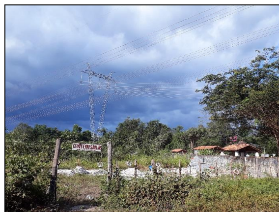
Figura 2.2.4.13-165 - LTs na Comunidade Açude Novo
