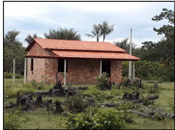
Figura 2.2.4.13-31 - Residência em construção a 500 m da LT
