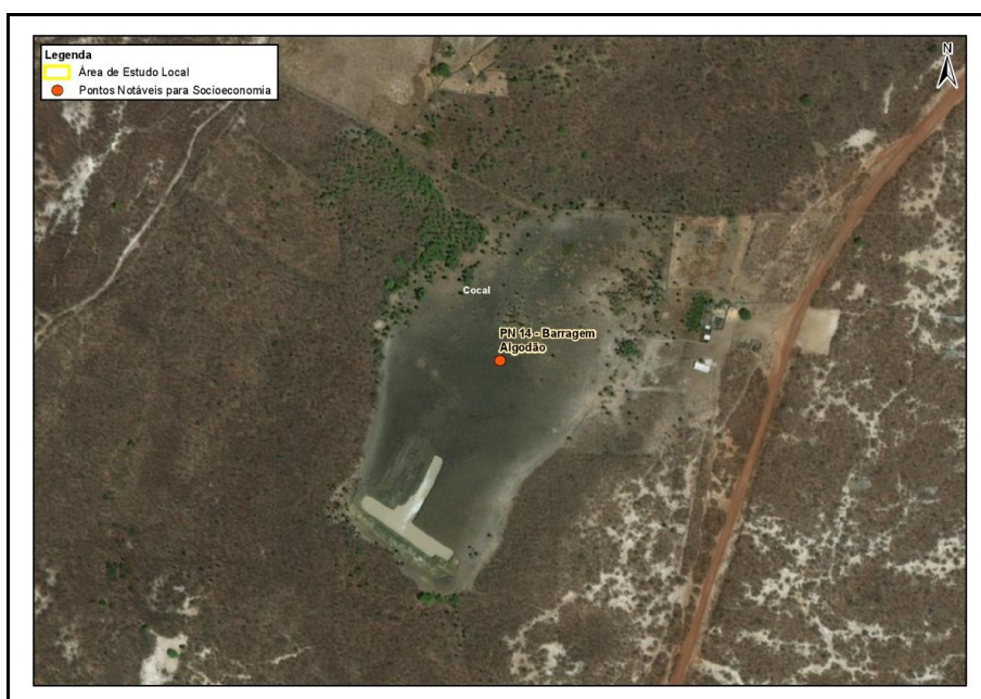
Figura 2.2.4.13-44 - Barragem Algodão. UTM 24 m / 0220492 E / 9630919 S
