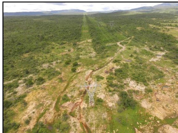
Figura 2.2.2.9-43 - Área de alagamento do Rio Pejuaba no eixo da LT, no município de Ibiapina - CE. Coordenadas UTM 24 m 254296E 9556217S.
