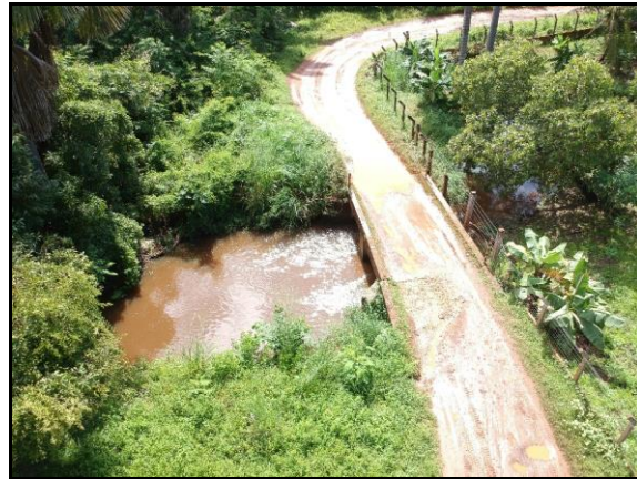
Figura 2.2.2.9-21 - Córrego Recanto, subafluente do Rio Poti no município de Teresina - PI. Coordenadas UTM 23 m 762242E 9434861S.
