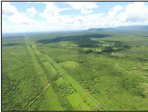
Figura 2.2.2.11-15 - Extensa área aplanada seccionada pela LT, no município de Piripiri - PI. Coordenadas UTM 24 m 209316E 9532753N
