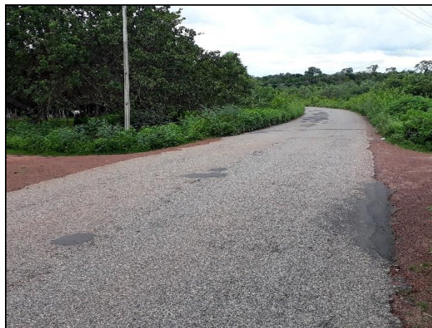
Figura 2.2.4.13-10 - Condições da estrada para Bom Princípio do Piauí.
