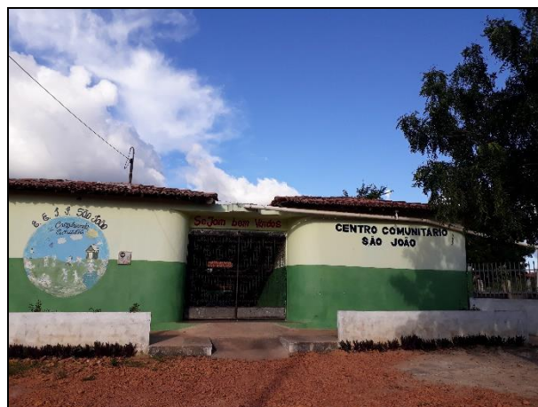
Figura 2.2.4.13-77 - Escola e Centro Comunitário no Assentamento São João
