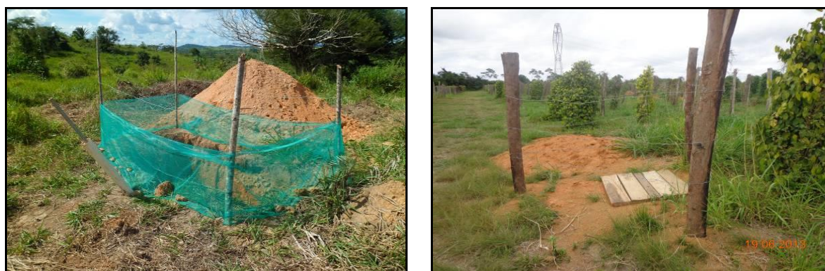
Figura 4.2.3-1 - Cercamento e cobrimento de cavas de fundações.
