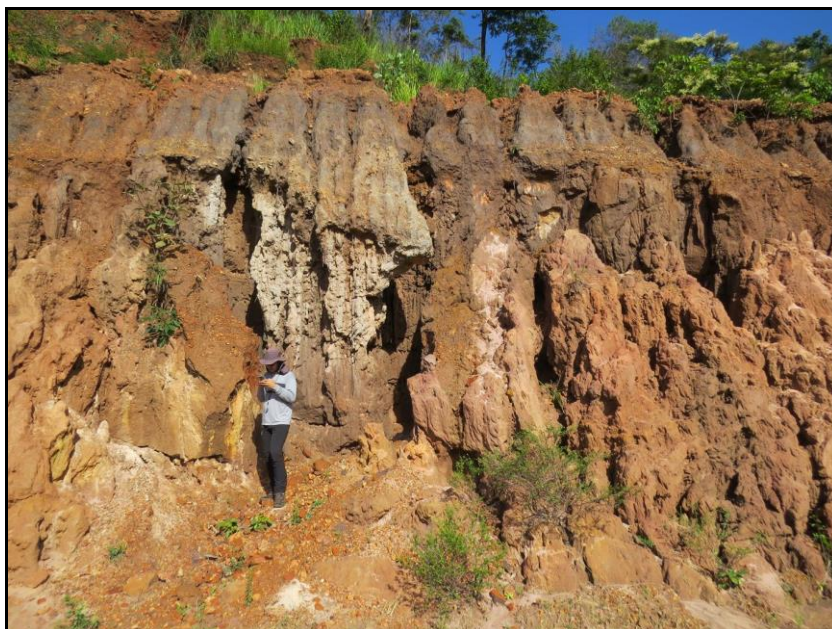
Figura 2.2.2.8-5 - Área de erosão em cortes de estradas. Coordenadas 23 m X 761825 - Y 9434087.
