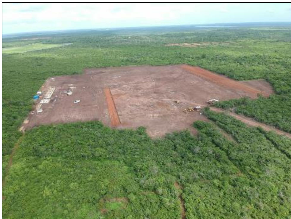
Figura 2.2.4.13-2 - Imagem aérea Subestação Parnaíba III
