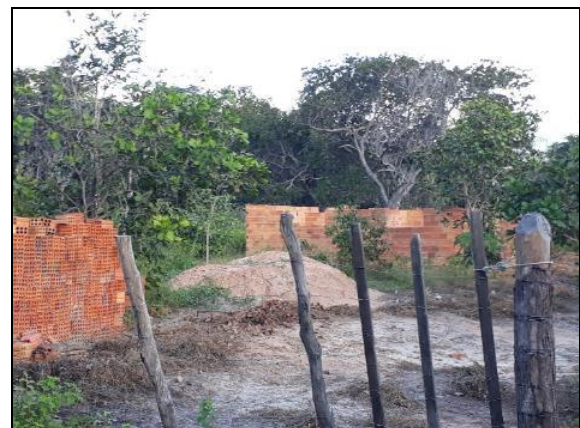
Figura 2.2.4.13-142 - Construção de edificações na Fazenda Riachão
