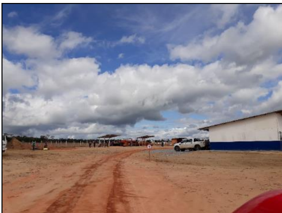
Figura 2.2.4.13-80 - Canteiro de Obras da SE Tianguá II
