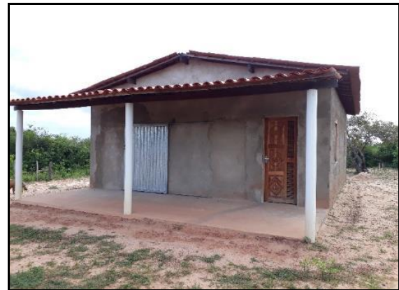
Figura 2.2.4.13-60 - Residência no Assentamento Gameleira
