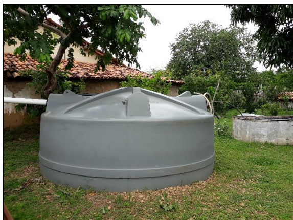
Figura 2.2.4.13-12 - Cisterna na Comunidade Bandeira.
