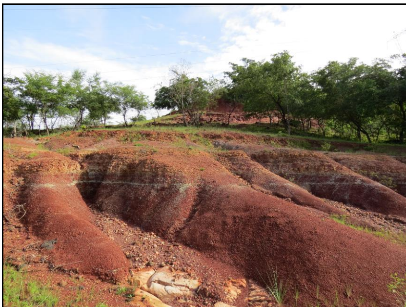
Figura 2.2.2.8-6 - Processos erosivos em encosta de colina no ponto 7. Coordenadas: 23 m X 781474 - Y 9447403.
