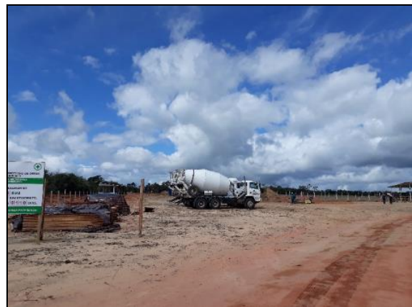
Figura 2.2.4.13-81 - Local da SE Tianguá II
