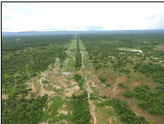
Figura 2.2.2.9-42 - Área de alagamento do Riacho do Ladinho presente no eixo da LT, no município de Piripiri - PI. Coordenadas UTM 24 m 215934E 9536366S.
