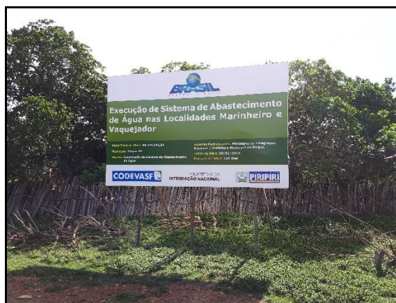
Figura 2.2.4.11-22 - Obras de melhorias na CRQ Vaquejador.
