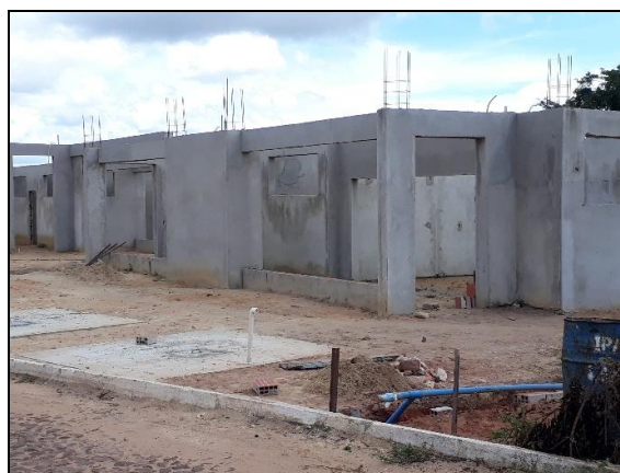
Figura 2.2.4.13-91 - Creche em construção na Comunidade Nova Veneza, a 100 m do seccionamento.
