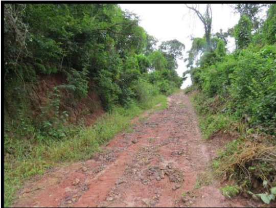
Ponto 010 UTM 23M X: 767917 Y: 9439594 Vista geral do ponto
