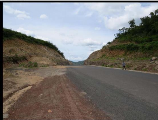
Ponto 096 UTM 24M X: 221120 Y: 9632491 Vista geral do ponto
