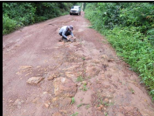
Ponto 009 UTM 23M X: 765859 Y: 9438237 Vista geral do ponto
