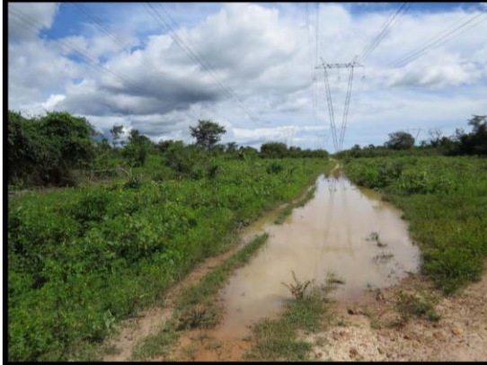
Ponto 031 UTM 23M X: 832182 Y: 9491181 Vista geral do ponto
