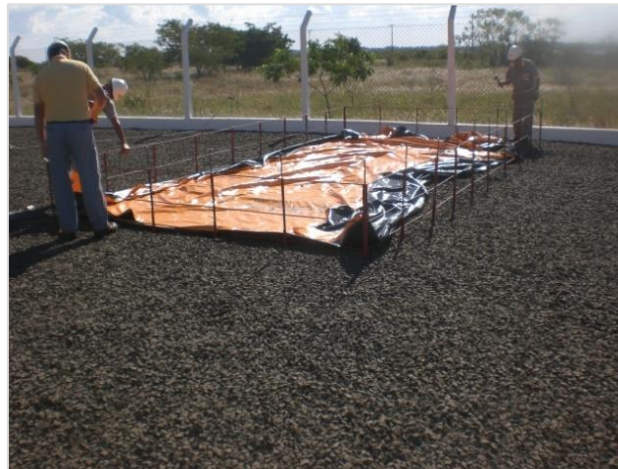
Montagem inicial da bacia de contenção.
