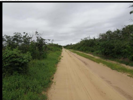
Ponto 061 UTM 24M X: 268526 Y: 9580801 Vista geral do ponto
