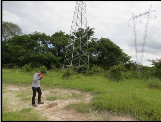
Ponto 018 UTM 23M X: 795801 Y: 9453763 Vista geral do ponto
