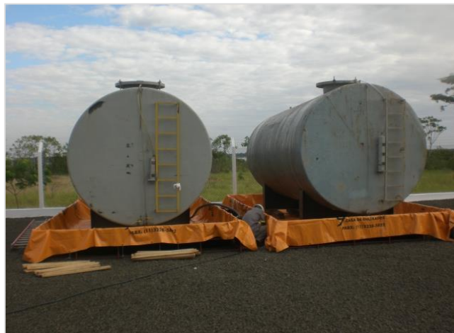
Bacia de contenção finalizada.
