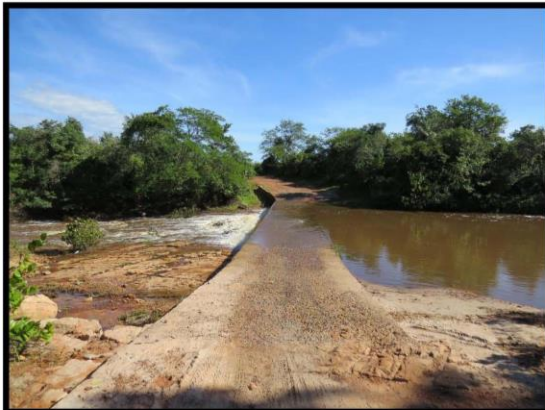
Ponto 085 UTM 24M X: 242104 Y: 9606085 Vista geral do ponto
