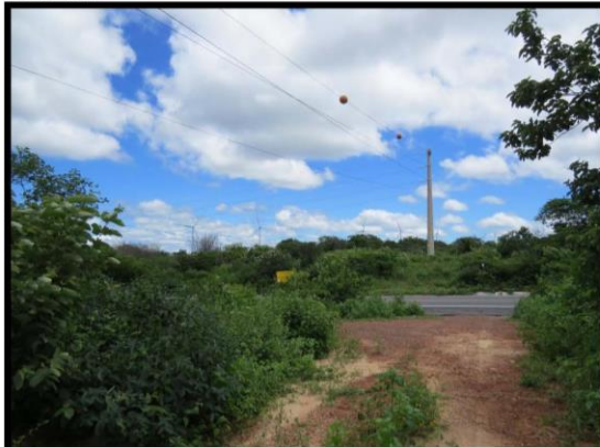
Ponto 070 UTM 24M X: 257073 Y: 9568864 Vista geral do ponto
