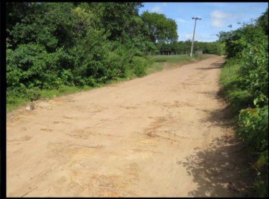
Ponto 035 UTM 24M X: 170023 Y: 9498325 Vista geral do ponto
