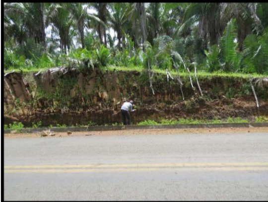
Ponto 030 UTM 23M X: 824996 Y: 9494187 Vista geral do ponto
