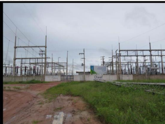
Ponto 066 UTM 24M X: 376060 Y: 9676229 Vista geral do ponto
