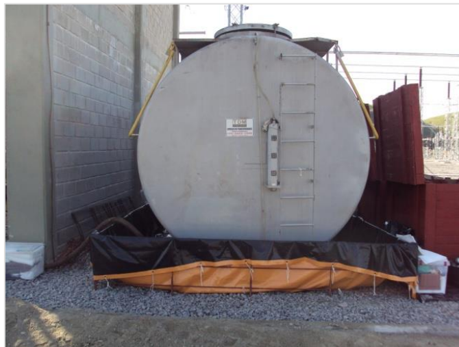
Montagem de bacias de contenção junto às cisternas.
