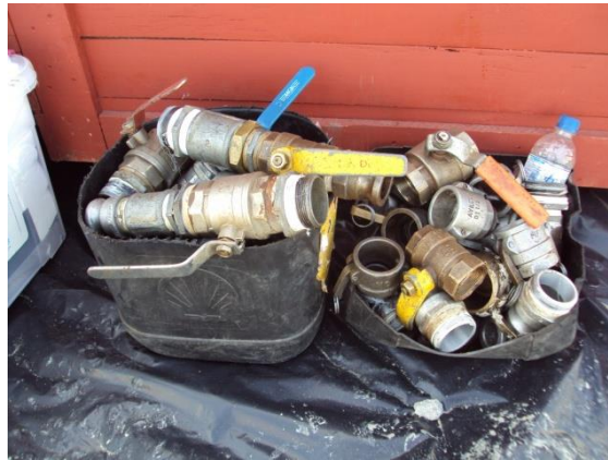
Conexões e mangotes em recipientes adequados e sobre lona impermeável.
