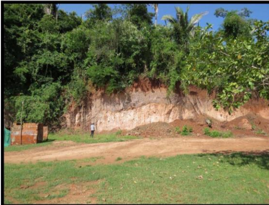
Ponto 006 UTM 23M X: 761282 Y: 9433192 Vista geral do ponto
