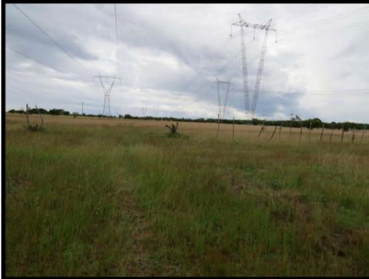
Ponto 024 UTM 23M X: 817546 Y: 9474949 Vista geral do ponto
