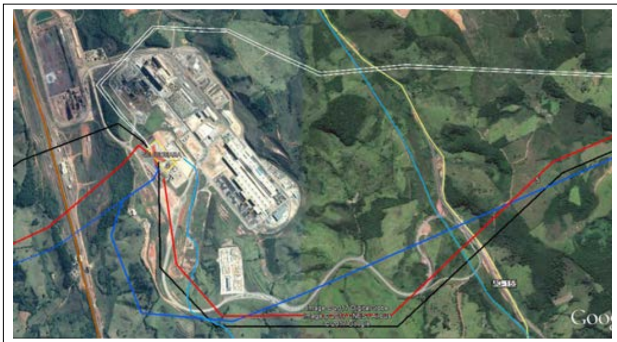
Figura 4-13 – Nessa imagem, destaca-se o desvio, em preto, da estrada de acesso à VLS. As linhas brancas simbolizam as 2 LTs em 345kV: uma oriunda de Conselheiro Lafaiete e outra que sai da SE Jeceaba em direção à SE Itabirito 2 (C1).
