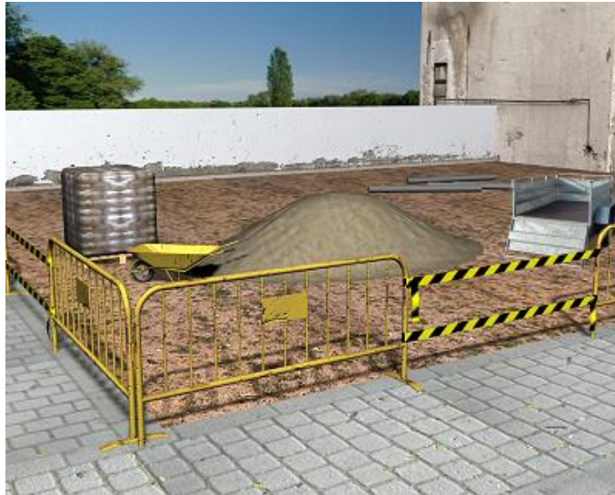
Figura 1.4-31 – Fita zebraada chamando a atenção para evitar risco de acidente.
