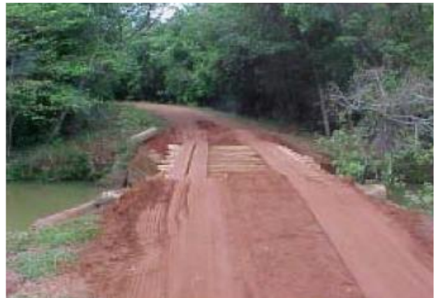
Foto I-10 – Pontes provisórias para evitar danos aos cursos d'água.
