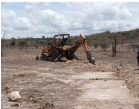
Foto I-26 – Uso de retroescavadeira para instalação de aterramento.
