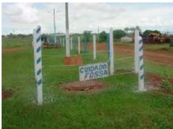
Foto I-5 – Tratamento e disposição apropriada de esgoto gerado no canteiro.
