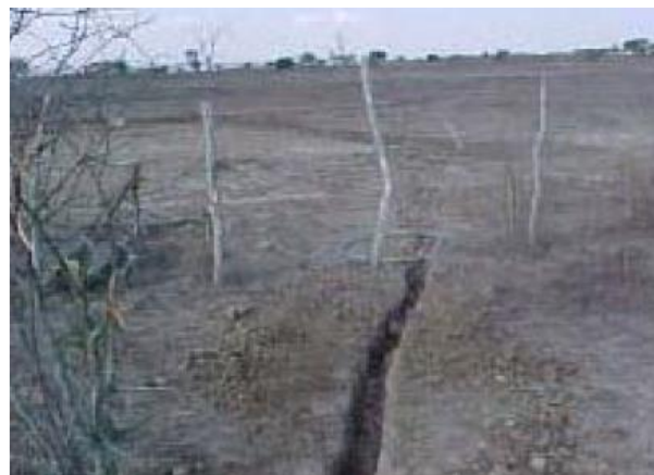
Foto I-27 – Vala para instalação de aterramento.
