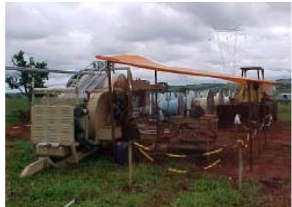
Fotos I-13 e I-14 – Praça de lançamento de cabos feita corretamente.
