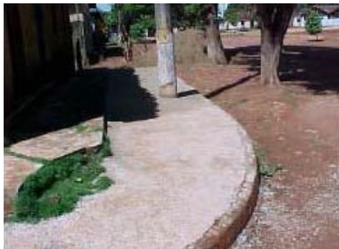
Foto I-15 – Disposição apropriada de restos de concreto.
