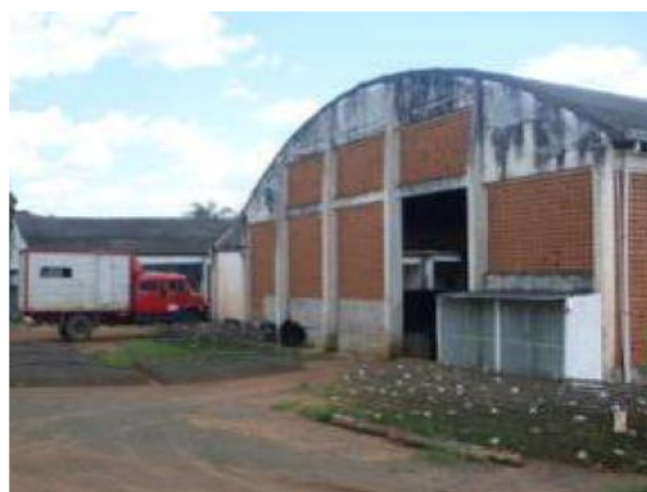
Foto I-4 – Exemplo de canteiro em vista externa. Galpão em bom estado de manutenção. Armazenamento de bobinas.
