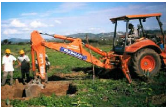
Foto I-18 – Escavação de fundação de uma torre.
