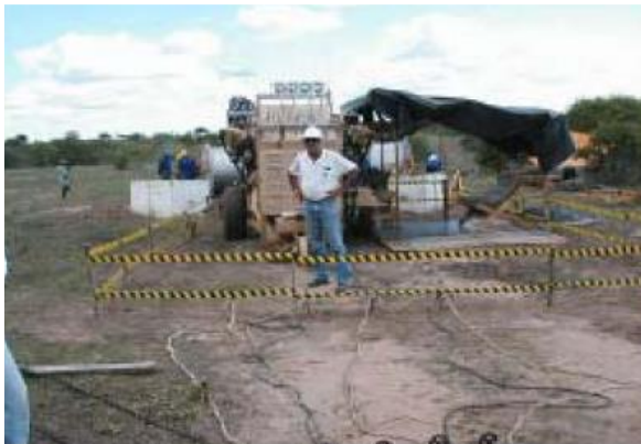
Fotos I-13 e I-14 – Praça de lançamento de cabos feita corretamente.
