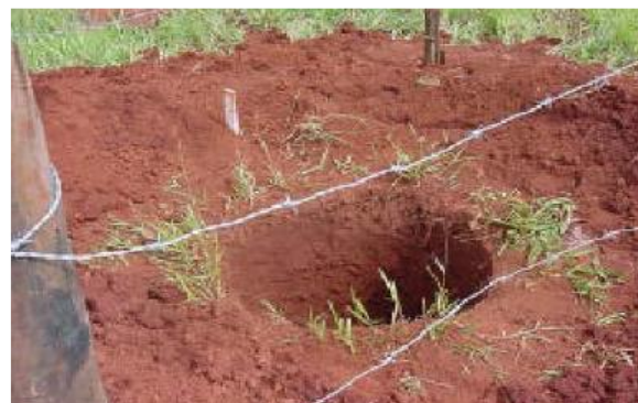
Foto I-19 – Detalhe da escavação com broca no mastro central.
