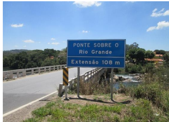
Foto 5.4.2-8: Ponte sobre o rio Grande, na BR-265, divisa intermunicipal de Itutinga e Nazareno.
