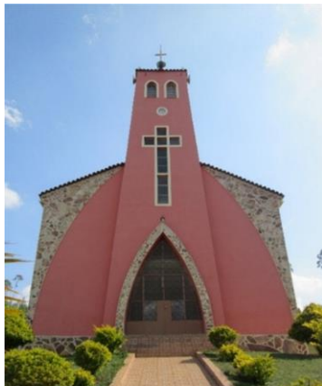
Foto 5.4.2-33: Igreja de Nossa Senhora da Conceição, no Povoado de Curralinho dos Paulas, em Resende Costa-MG.
