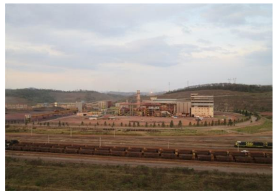
Foto 5.4.2-48: Vista da Vallourec & Sumitomo Tubos do Brasil e do Pátio da MRS Logística, no distrito industrial de Jeceaba-MG.
