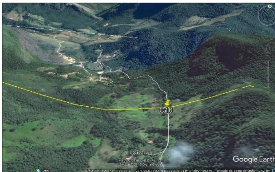
Figura 5.3.4.1-18 – Imagem de satélite demonstrando o aspecto geral da paisagem do Ponto C16, com localização de ponto amostral para avaliação de instalação de sinalizadores anti-colisão para avifauna.
