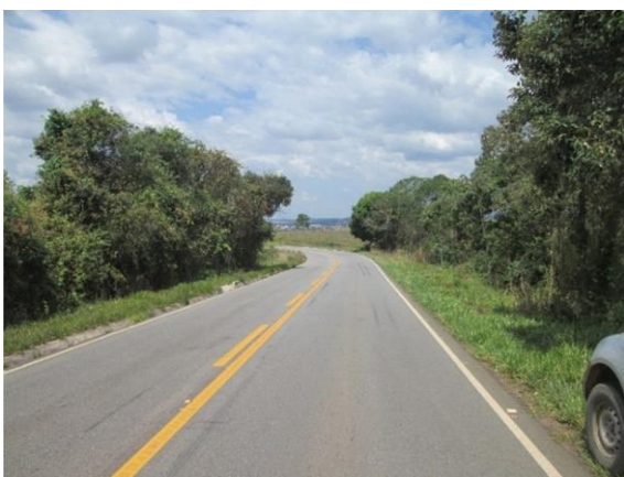
Foto 5.4.2-41: Ponto de cruzamento da Rodovia MG-270, na área rural de Entre Rios de Minas-MG.
