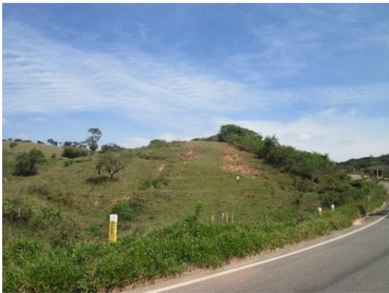
Foto 5.4.2-51: Localização da faixa de dutos da Transpetro, no distrito industrial de Jeceaba-MG.
