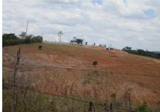
Foto 5.4.2-40: Sítio Ramos, com área em construção na faixa de servidão da LT, na área rural de Entre Rios de Minas-MG.
