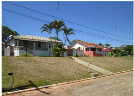
Foto 5.4.2-3: Vila da CEMIG, antiga vila de operários, hoje bairro de Itutinga, em Itutinga-MG.
