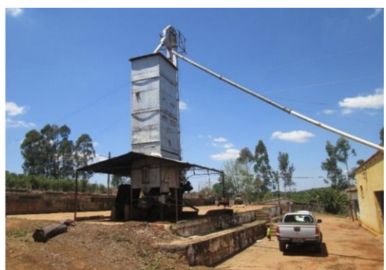
Foto 5.4.2-17: Fazenda Cruzeiro da Barra, produtora de café, na área rural de Conceição da Barra de Minas-MG.
