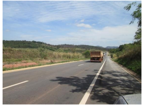
Foto 5.4.2-52: Ponto de cruzamento com a Rodovia MG-155, em Jeceaba-MG.
