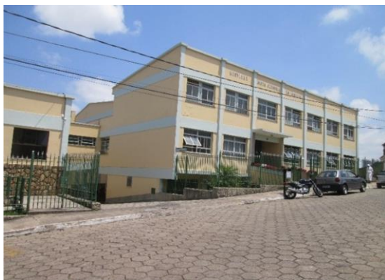
Foto 5.4.2-29: Hospital Nossa Senhora do Rosário, na cidade de Resende Costa-MG.
