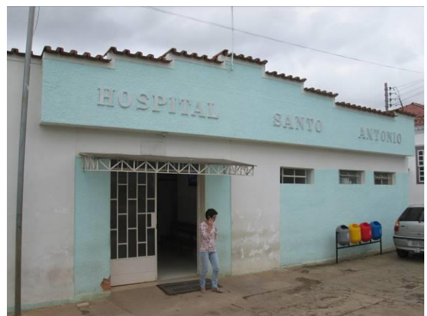
Foto 5.4.1-10 – Hospital Municipal Santo Antônio, em Nazareno
