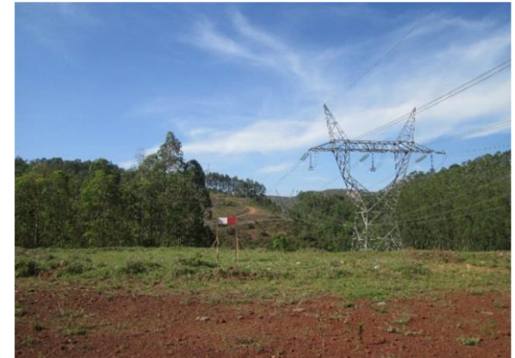
Foto 5.4.2-82: Bandeira de topografia sinalizando um vértice da futura LT, em paralelo à LT existente, na área rural de Mariana-MG.
