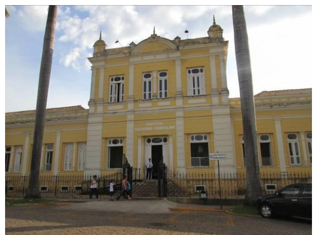
Foto 5.4.1-8 – Hospital Cassiano Campolina, em Entre Rios de Minas
