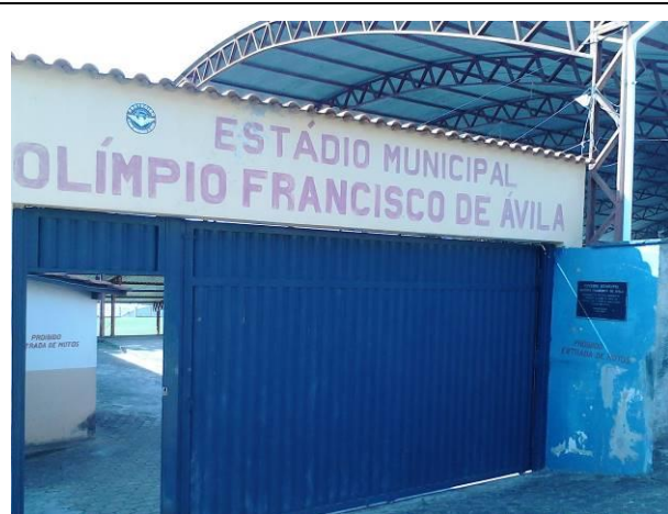
Foto 5.4.1-17 – Estádio Municipal Olímpio Francisco de Ávila, Conceição da Barra de Minas
