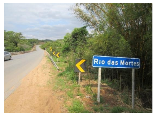
Foto 5.4.2-23: Ponte na BR-494, sobre o rio das Mortes, na divisa de São João Del Rei e Ritópolis-MG.
