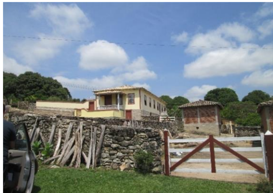
Foto 5.4.2-27: Fazenda Vau, na área rural de Ritápolis-MG.
