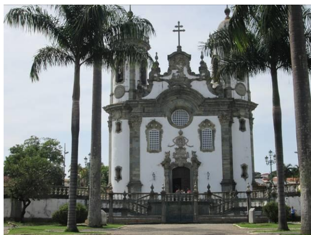
Foto 5.4.4-5 – Igreja de São Francisco de Assis, São João del Rei.
