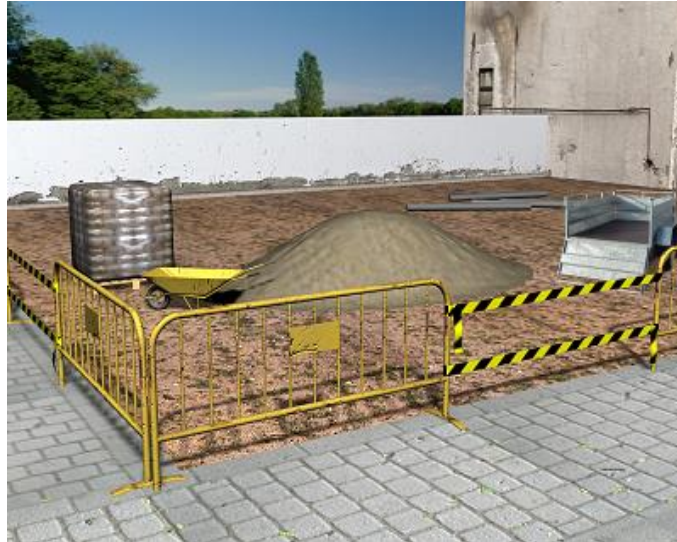
Figura 1.4-22 – Fita zebra chamando a atenção para evitar risco de acidente.
