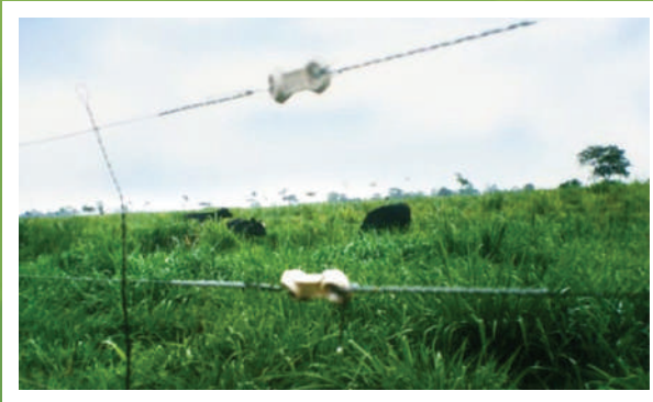
Cercas de arame seccionadas e aterradas
