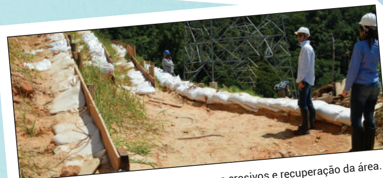
Recuperação de área degradada em talude.
