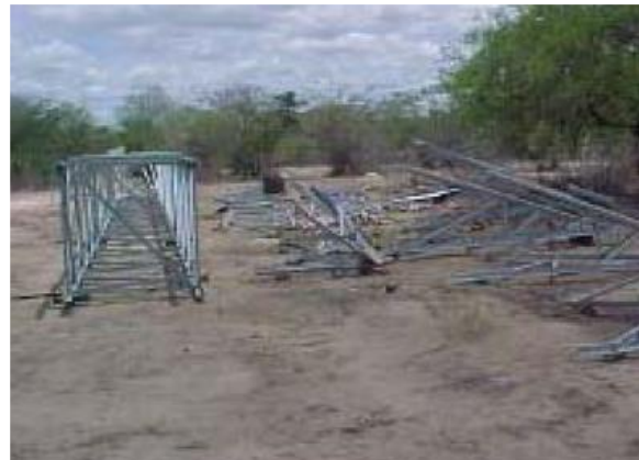
Figuras 8.5.1-21 e 8.5.1-22 – Processo de montagem das torres em solo para posterior içamento (outra obra).
