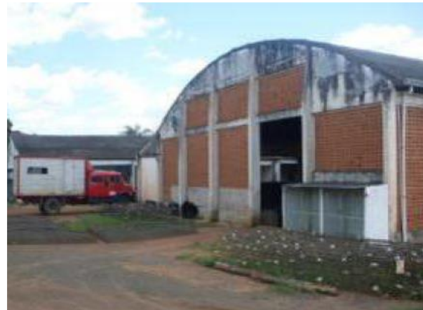
Figura 8.5.1-2 – Exemplo de galpão para armazenamento de bobinas em canteiro. Vista externa (outra obra).
