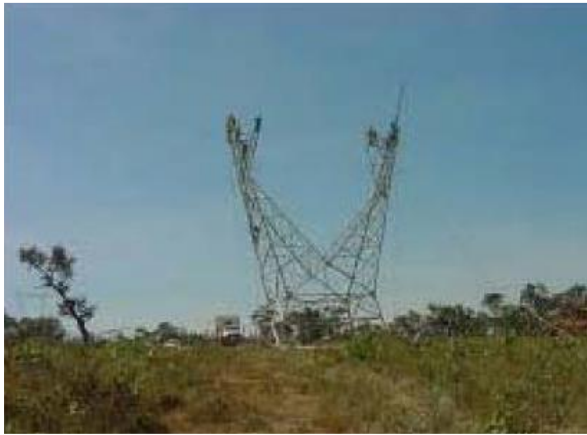
Figuras 8.5.1-25 e 8.5.1-26 – Processo de montagem das torres em local definitivo (outra obra).
