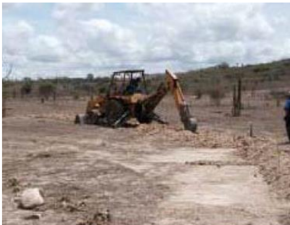
Figura 8.5.1-27 – Uso de retroescavadeira para instalação de aterramento (outra obra).
