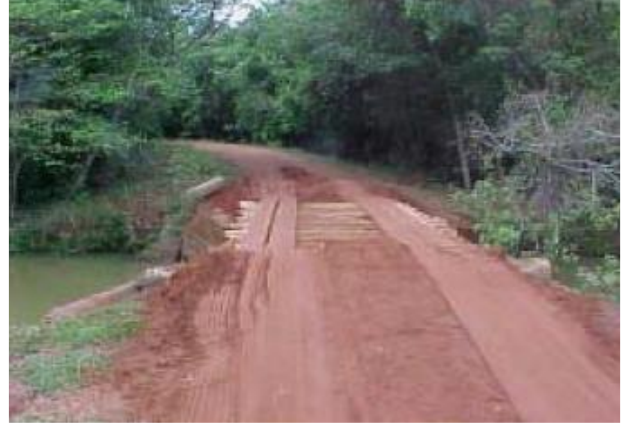
Figura 8.5.1-8 – Ponte/travessia provisória sobre curso d'água (outra obra).
