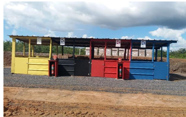
Figura 8.5.1-6 – Modelo de baias de armazenamento temporário de resíduos no canteiro de obras (outra obra).
