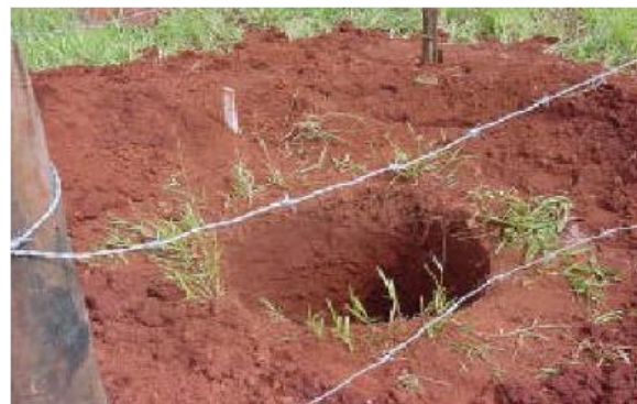
Figura 8.5.1-20 – Detalhe da escavação realizada com broca, no local do mastro central (outra obra).
