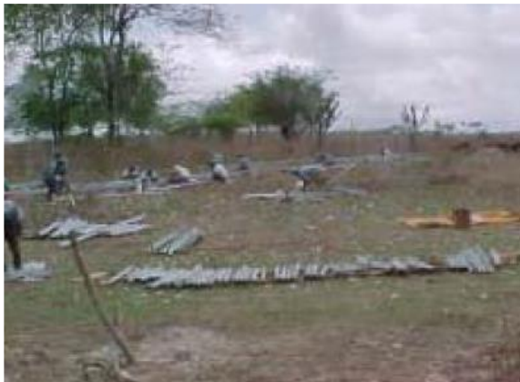
Figuras 8.5.1-21 e 8.5.1-22 – Processo de montagem das torres em solo para posterior içamento (outra obra).
