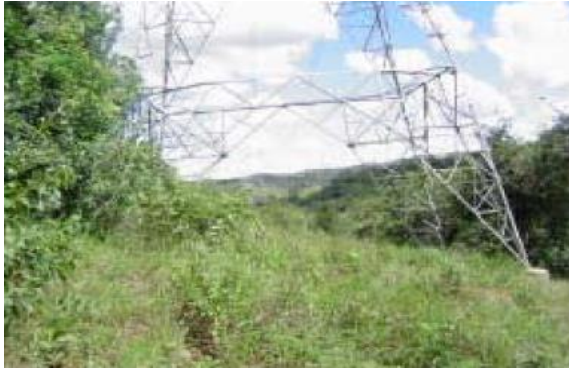
Figura 8.5.1-29 – Revegetação com capim nativo logo após o nivelamento final do terreno (outra obra).
