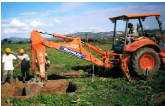
Figura 8.5.1-19 – Escavação de fundação de uma torre (outra obra).
