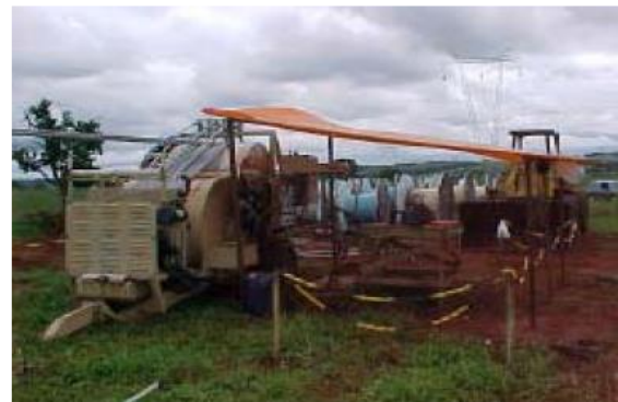
Figuras 8.5.1-11 e 8.5.1-12 – Praça de lançamento de cabos (outra obra).
