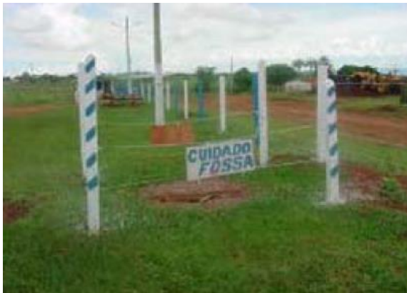
Figura 8.5.1-3 – Tratamento e disposição de esgoto gerado no canteiro (outra obra).
