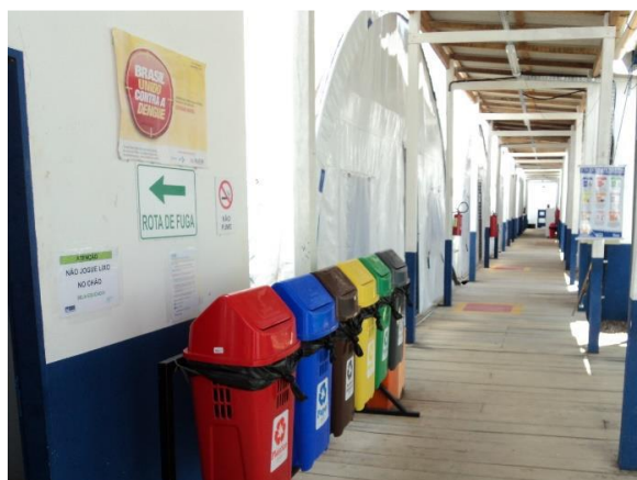
Figura 8.5.1-31 – Exemplos de recipientes de coleta seletiva, devidamente identificados (outra obra).
