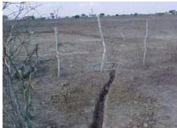
Figura 8.5.1-28 – Vala para instalação de aterramento (outra obra).
