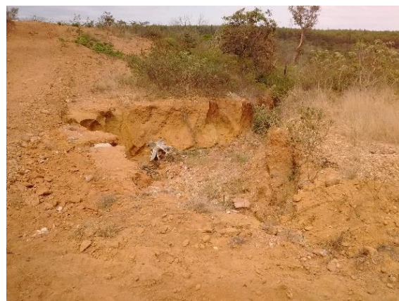
Foto 5.2.4-26: Erosão linear profunda. Coord.: 23 738365.00 m E 8200734.00 m S.
