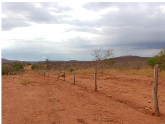
Foto 5.2.8-50: Aspecto geral da paisagem na área onde será instalada a SE Janaúba 3 (à direita da cerca) e entorno. Notar a ausência de afloramentos e feições típicas do carste. Coord.: 23 L 678547.56 m E 8239487.83 m S.
