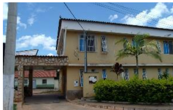
Foto 5.4.2-138: Hospital Municipal de Grão Mogol.
