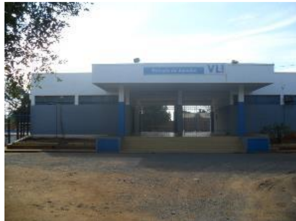
Foto 5.4.2-194: Estação ferroviária de Janaúba.
