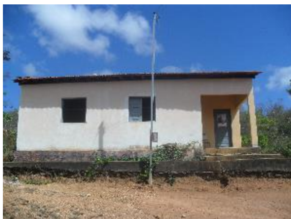
Foto 5.4.2-155: Sede da Associação na Comunidade Rural dos Córregos em Riacho dos Machados.
