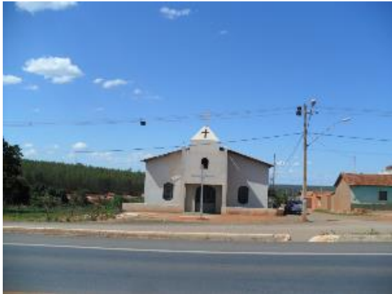
Foto 5.4.2-131: Igreja Católica na Comunidade Vale das Cancelas – Grão Mogol.
