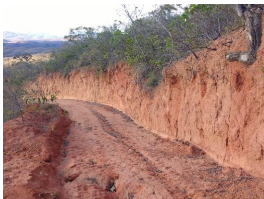
Foto 5.2.8-15: Corte de estrada na porção oeste do Chapadão da Virgem, trecho Irapé - Araçuaí 2. Coord.: 23K 775833.58 m E 8145708.10 m S.
