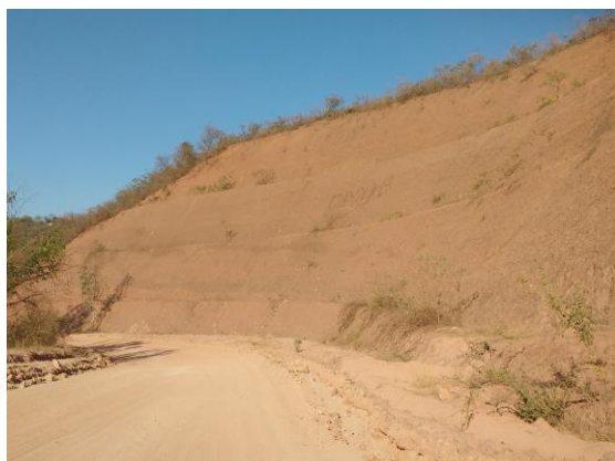
Foto 5.2.8-18: Talude na estrada para Virg. da Lapa, demonstrando a profundidade da camada de sedimentos. Coord.: 23K 779696.01mE 8143475.66m S.
