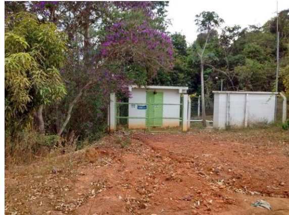
Foto 5.2.2-6: Cobertura detrítica superficial. Coord.: 23 K 741902.00 m E - 8197796.00 m S.
