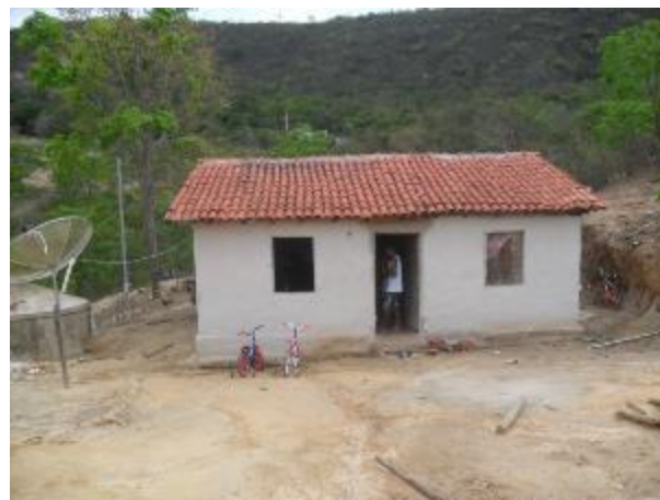
Foto 5.4.2-102: Residência com a cisterna de 16m 3 para coletar e armazenar água das chuvas na Comunidade Vereda em Berilo.
