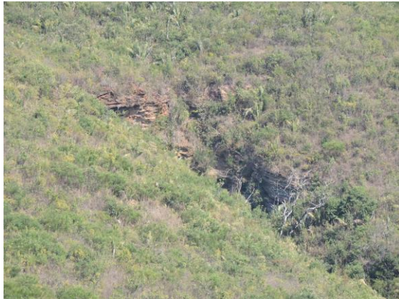
Foto 5.2.8-56: Linha de drenagem na encosta. Coord.: 23 K 757937.86 m E 8150420.75 m S.
