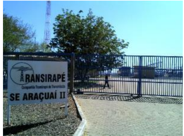
Foto 5.4.2-59: Subestação de energia em Araçuaí.
