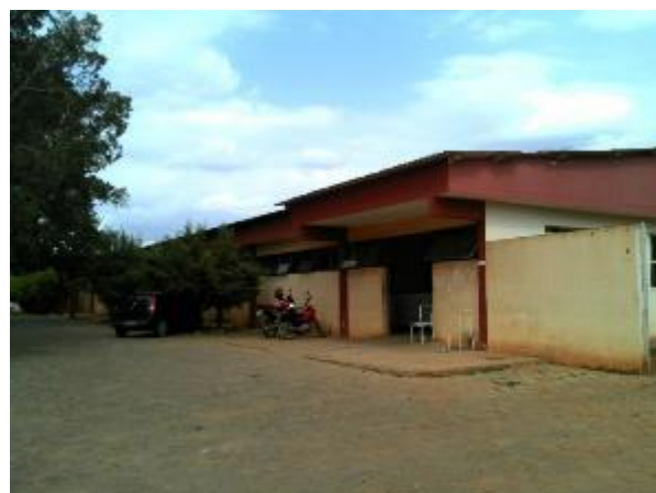
Foto 5.4.1-20: Hospital Municipal de Berilo-MG
