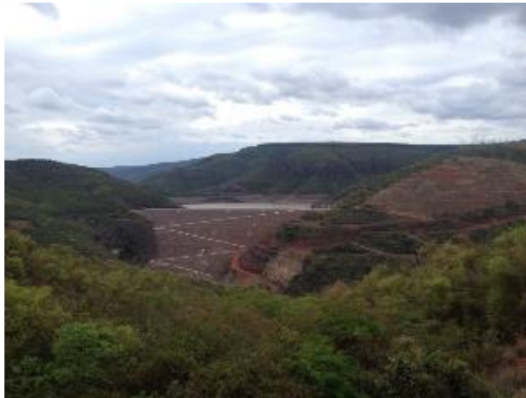
Foto 5.4.2-143: Vista da Usina Hidrelétrica de Irapé.
