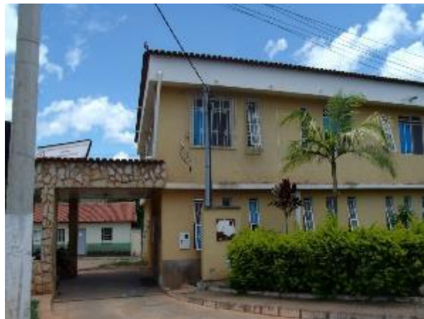
Foto 5.4.1-422: Hospital Municipal de Grão Mogol-MG
