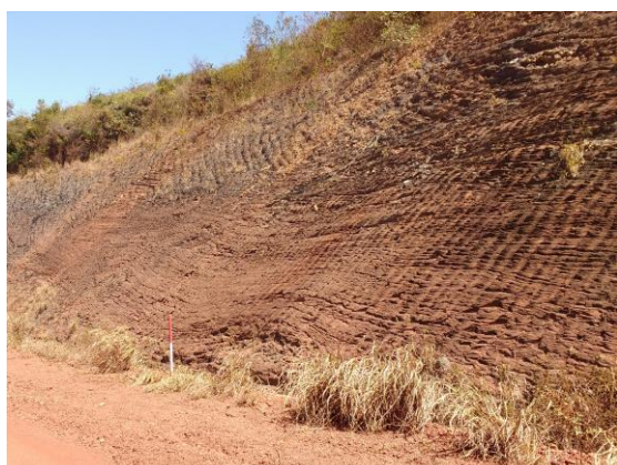
Foto 5.2.8-20: Talude em estrada de acesso à SE Irapé. Coord.: 23 K 759240.95 m E 8147967.68 m S.
