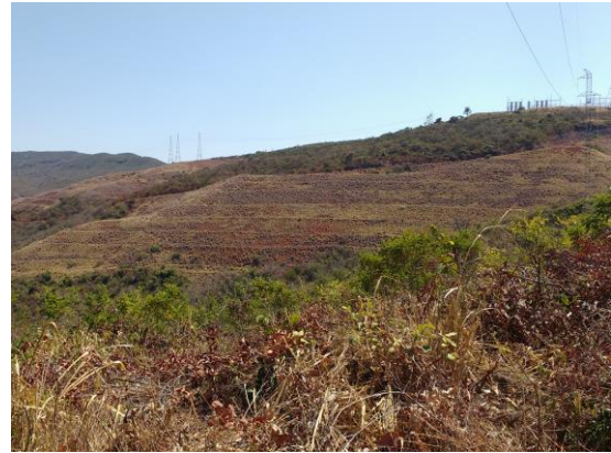
Foto 5.2.8-23: Vista da encosta próxima à SE Irapé. Coord. (visada): 23 K 759825.16 m E 8148709.21 m S.
