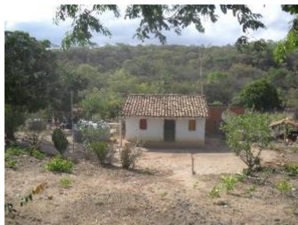
Foto 5.4.2-156: Residência na Comunidade dos Córregos em Riacho dos Machados.
