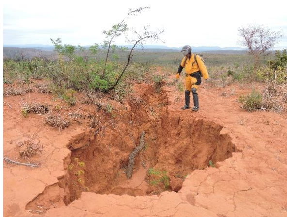
Foto 3: Erosão linear profunda já existente na área de influência do empreendimento. Coord.: 23 K 817493.27 m E 8136254.62 m S.
