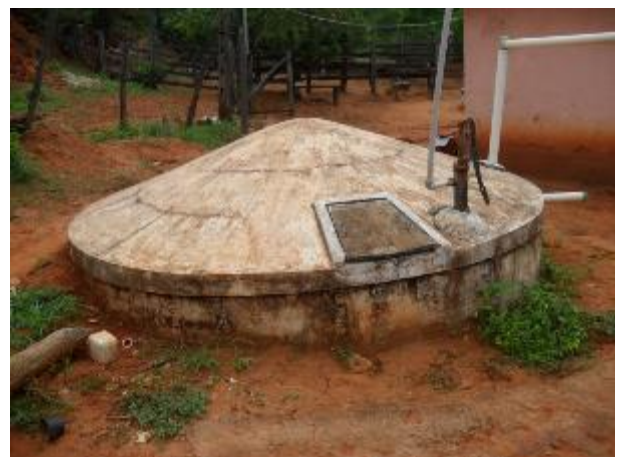
Foto 5.4.2-6: Cisterna de coleta e armazenamento de água na comunidade Bananal - Araçuaí.
