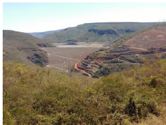
Foto 5.2.8-19: Vista geral do Complexo Irapé. Coord. (visada): 23 K 759458.58 m E 8146993.21 m S.
