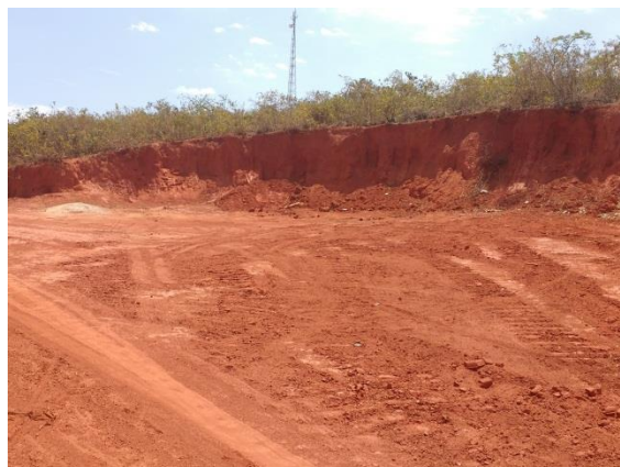
Foto 5.2.2-54: Sedimentos detríticos inconsolidados (recuperação de vias). Coord.: 23 K 744783.00 m 8195834.00 m S.
