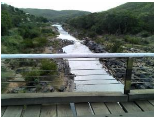
Foto 5.4.2-121: Ponte sobre o Rio Araçuaí em Berilo.
