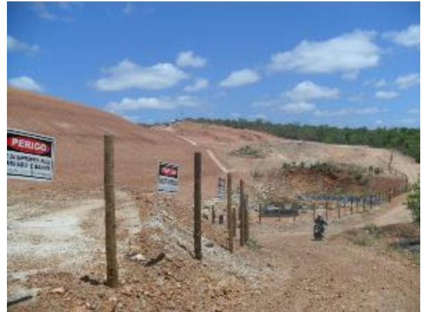
Foto 5.4.2-160: Vias de acesso à comunidade no talude da barragem de rejeito da mineradora na Comunidade de Ouro Fino em Riacho dos Machados.
