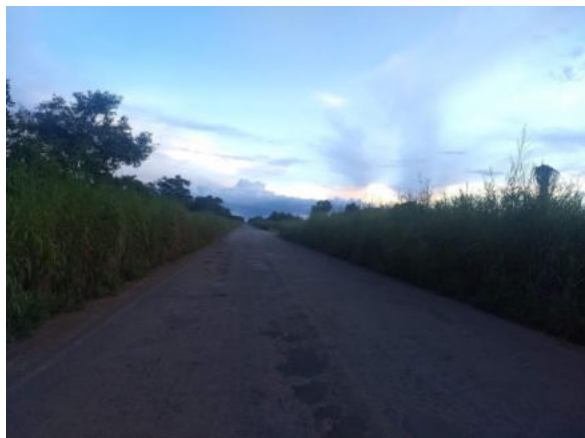
Foto 6-3: Ponto de travessia da LT com rodovia. Localização: -11649212, -46.757960
