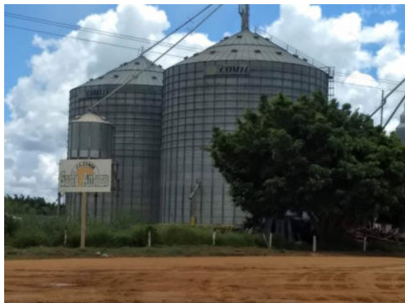
Foto 6-19: Trecho Estrada do Café. Silo na Estrada do Café, aproximadamente 3,2 km do traçado da LT. Localização: -11.717037, -45.976621
