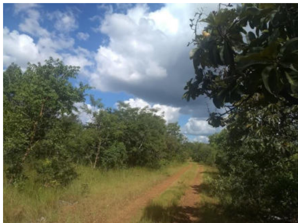
Foto 6-5: Ponto de travessia da LT em estrada não pavimentada. Estrada que dá acesso à PVH Água Limpa. Localização: -11.673251, 46.699356.
