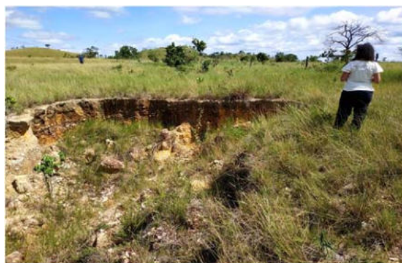
Foto 6.1-10: vista de jusante de Voçoroca em fazenda no município de Barreiras/BA.
