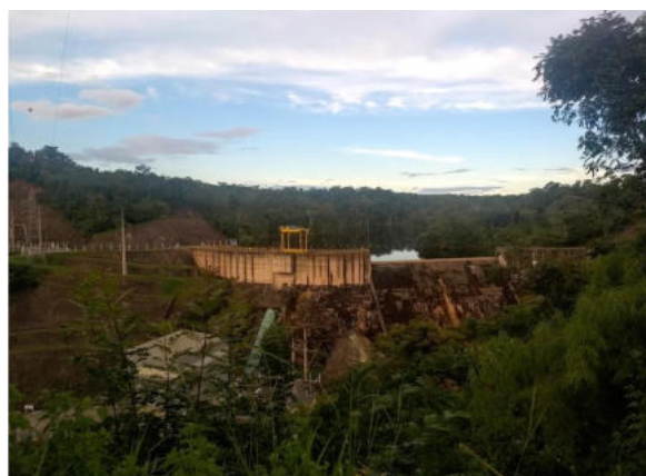
Foto 6-10: PCH Água Limpa, à menos de 2km do traçado da LT. Localização: -11.69217, -46.705659.
