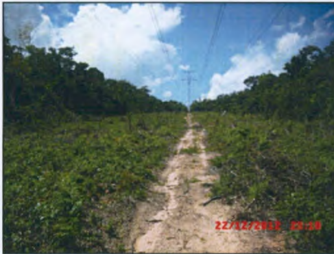
Imagens: Supressão de vegetação ao longo do vão entre torres, para evitar possíveis descargas e consequentemente incêndios.
