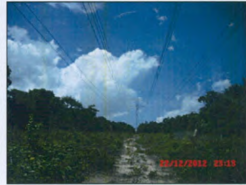
Imagens: Supressão de vegetação ao longo do vão entre torres, para evitar possíveis descargas e consequentemente incêndios.
