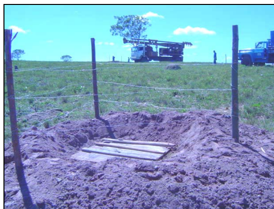
Figura 3.1-15 - Cercamento e cobrimento de cavas de fundações
