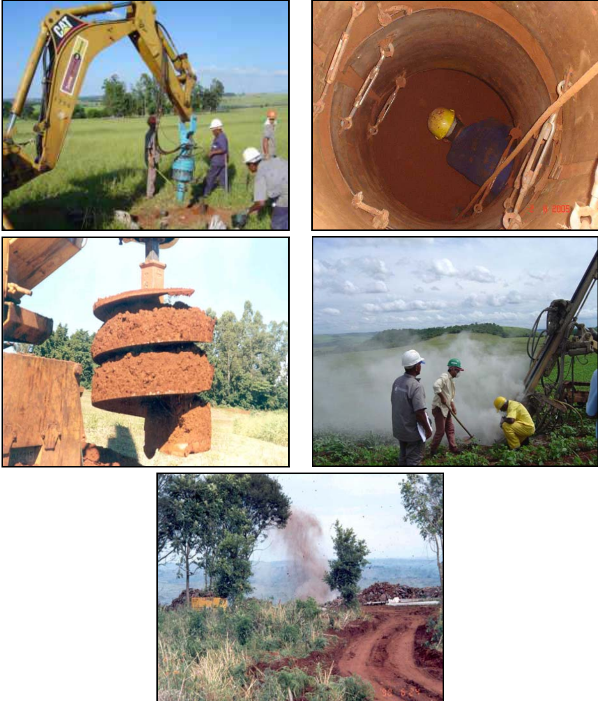
Figura 3.1-14 - Escavação para fundações das torres
