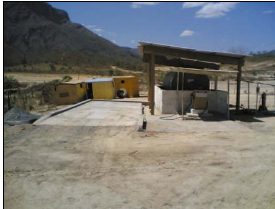
Figura 3.1-13 - Construção de pátio cimentado para abastecimento de veículos
