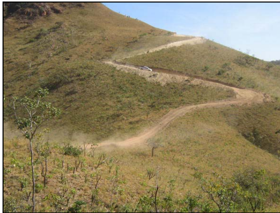
Figura 3.1-10 - Implantação de acessos de acordo com as curvas de nível
