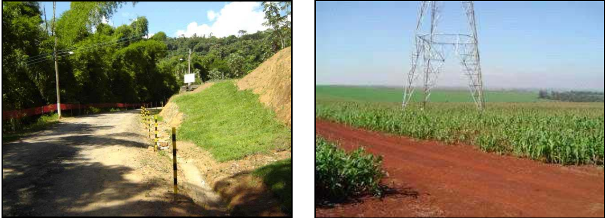
Figura 3.1-2 - Estradas de acesso
