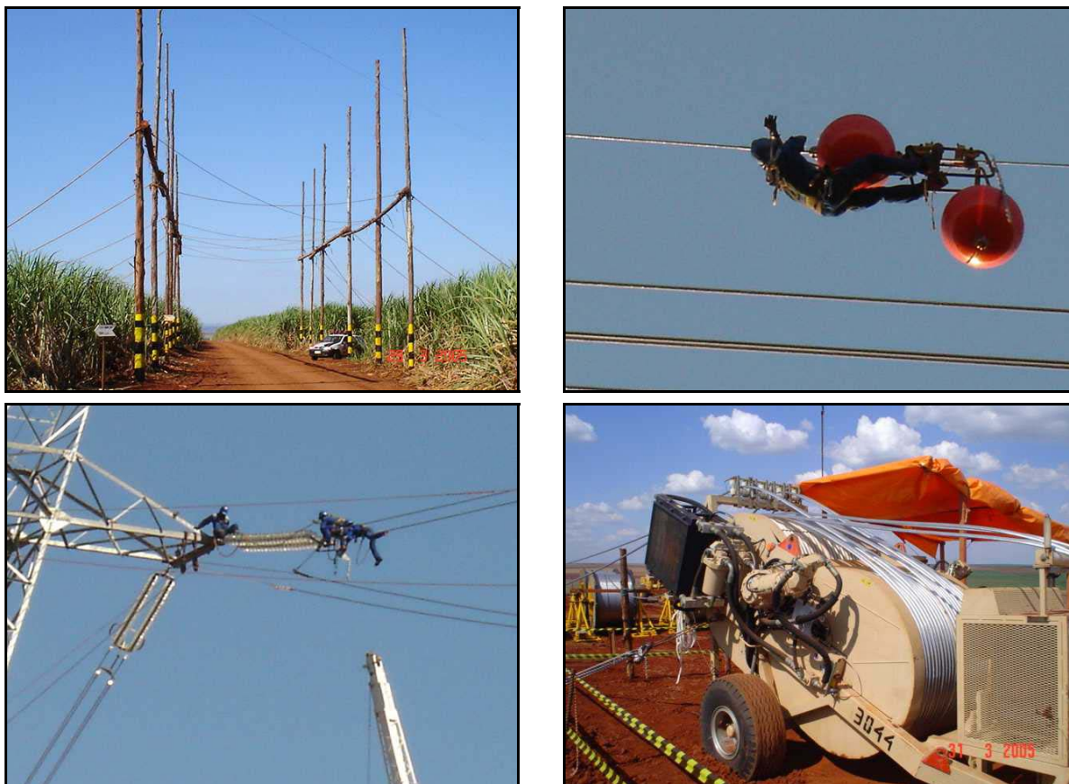
Figura 3.1-19 - Praça de lançamento dos cabos condutores, pára-raios, isolantes e acessórios
