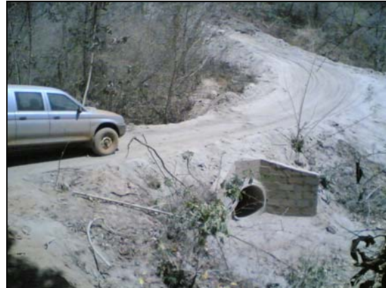
Figura 3.1-7 - Construção de bueiro em acesso para passagem de água
