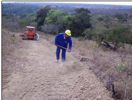
Figura 3.1-8 - Colaborador realizando saída de água manualmente no acesso
