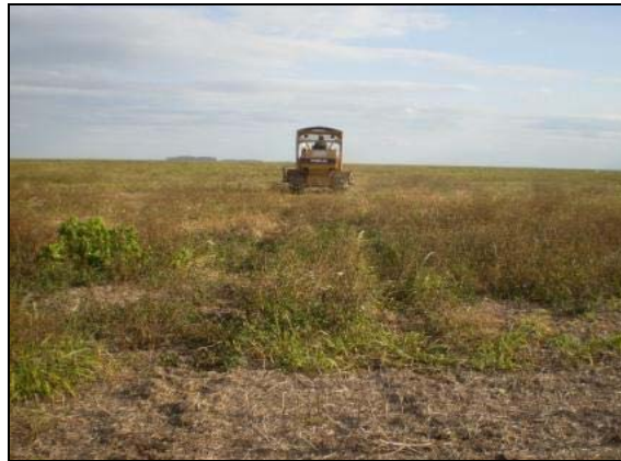
Figura 3.1-5 - Construção de acessos em áreas de lavoura e pastagens somente com o rodado do trator, sem raspagem de solo
