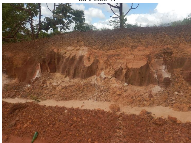
Detalhe do arenito com erosão no Ponto 8.
