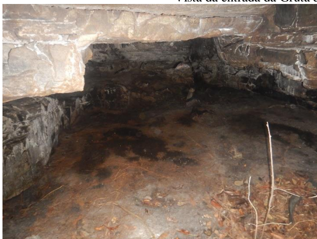
Vista do interior da Gruta do Piquiá e o fraturamento do arenito.
