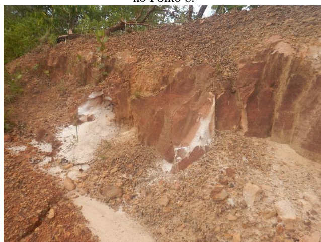
Detalhe do arenito com erosão no Ponto 8.
