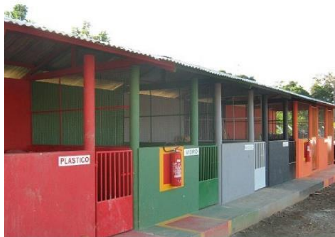
Figura 8.9 – Modelo de Baias de armazenamento temporário de resíduos identificadas de acordo com a Resolução CONAMA nº 275/01.
