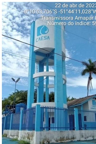
Figura 4.124 - Estação de tratamento da CAESA localizada na região.
