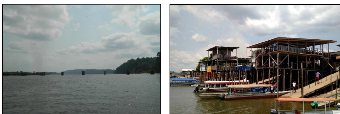
Figura 5.3-1 - Ponte inacabada que ligaria Laranjal do Jari (AP) a Monte Dourado (PA) - à esquerda, e os barcos que fazem a travessia de pessoas no rio Jari
