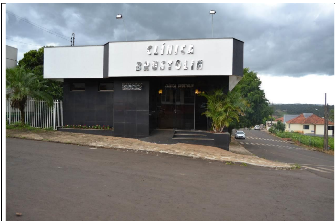
Foto 5.3-62 Consultório médico particular, localizado em São Carlos.
