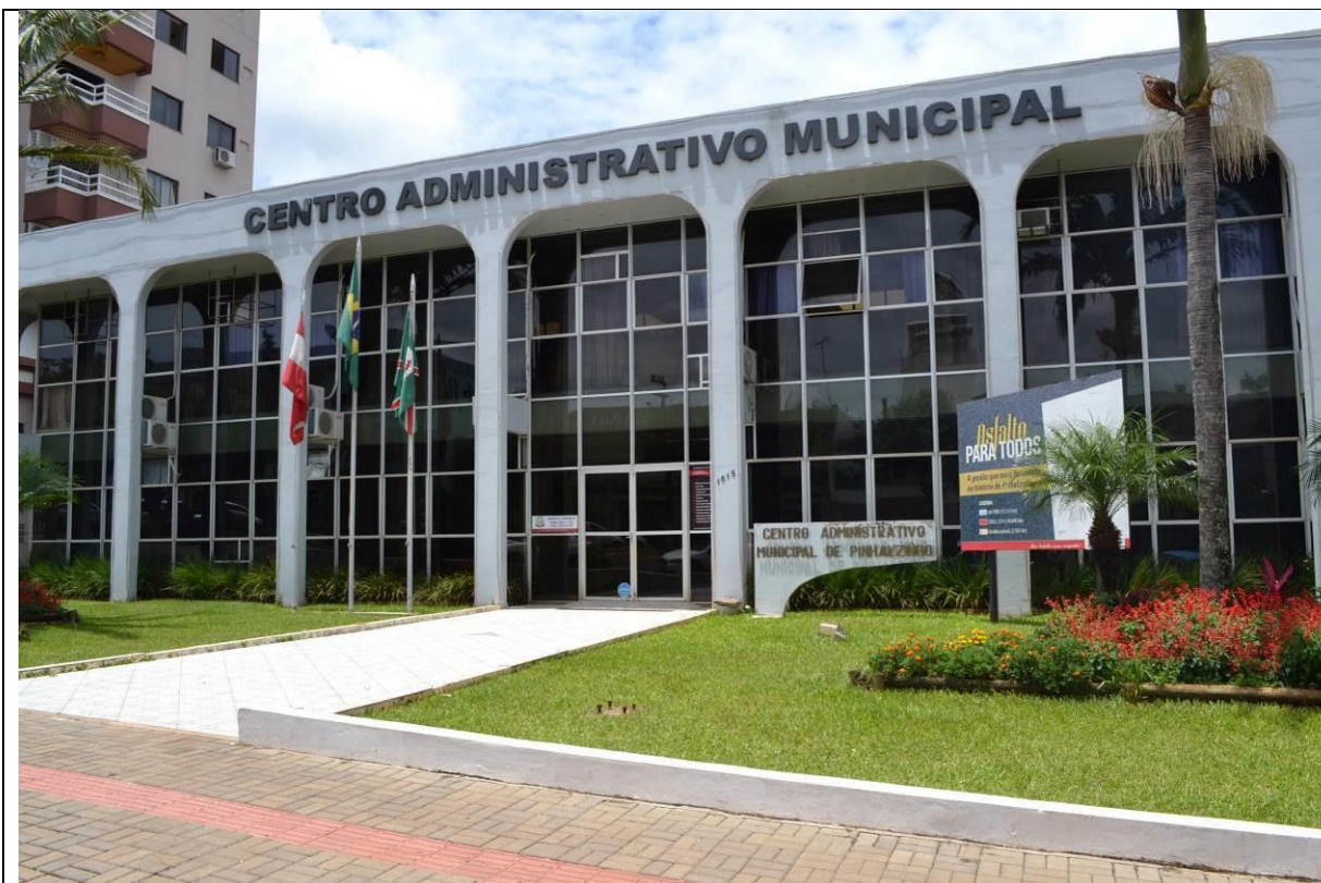
Foto 5.3-24 Centro Administrativo Municipal, em Pinhalzinho.
