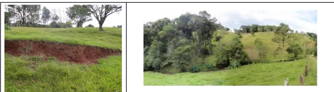
Foto 5.1-12 Colapsos de solo (LT016).
