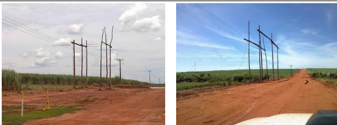
Figura 2.2-3 Empacaduras utilizadas nos lançamentos de cabos, para evitar o contato dos condutores com linha de distribuição de média tensão.
