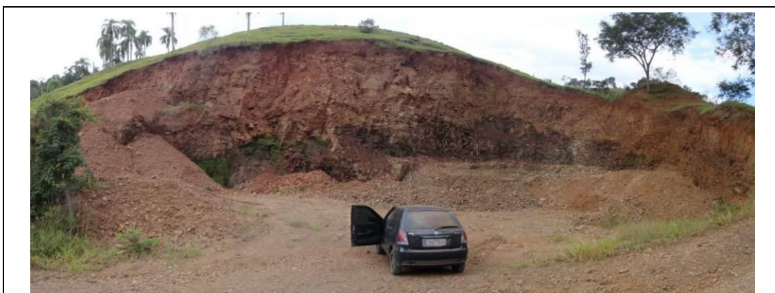
Foto 5.1-17 Depósitos resultantes de movimentos de massa em talude contíguo a área de extração.
