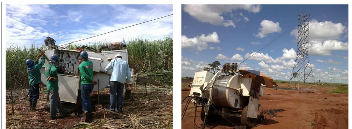
Figura 2.2-1 Lançamento de cabo condutor utilizando o sistema Puller/Freio. Com este tipo de equipamento o cabo condutor é lançado tensionado.
