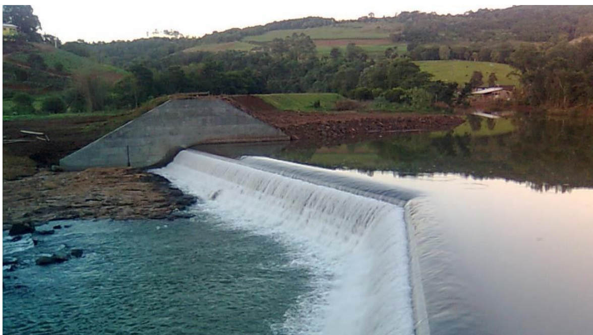
Foto 5.1-39 Barramento da PCH Barra Escondida. Fonte: Google Earth, foto de Tairo.sk.
