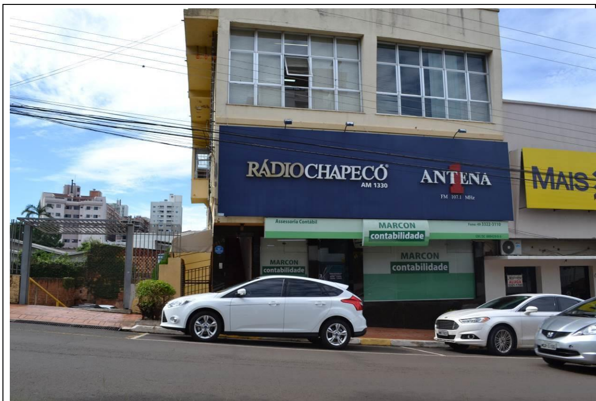
Foto 5.3-60 Sede da empresa Radio Chapecó e Antena 1, de rádio AM/FM.
