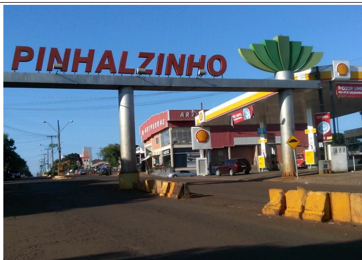
Foto 5.3-23 Pórtico do município de Pinhalzinho.
