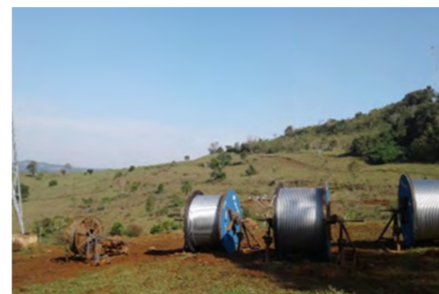
Atividades de montagem e lançamento de cabos em linha de transmissão.
