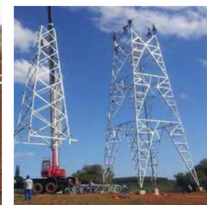
Atividades de concretagem de fundação, pré-montagem e montagem de torre em linha de transmissão.
