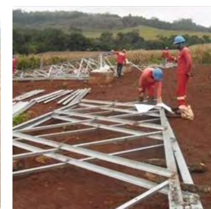
Atividades de concretagem de fundação, pré-montagem e montagem de torre em linha de transmissão.
