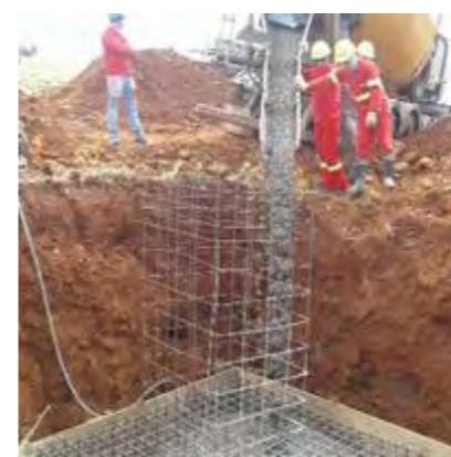
Atividades de concretagem de fundação, pré-montagem e montagem de torre em linha de transmissão.
