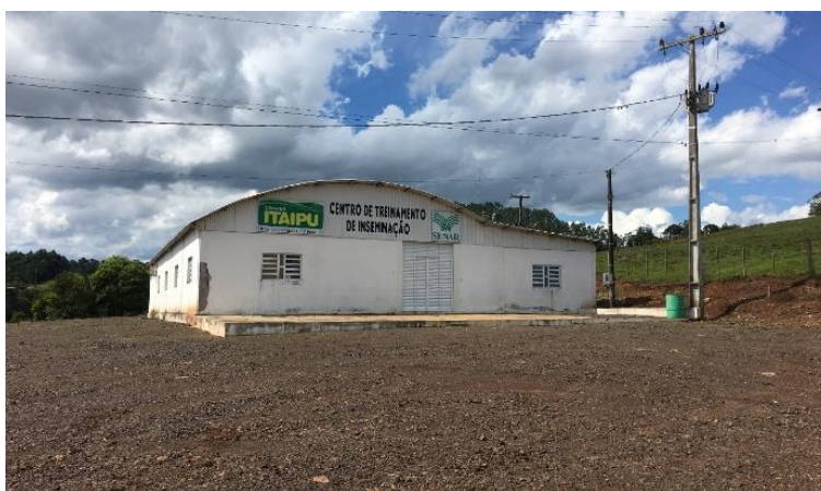
Figura 120: Distrito Machado, junto a SC 160 , nas proximidades da futura SE, unidade da Cooperativa Itaipu.
