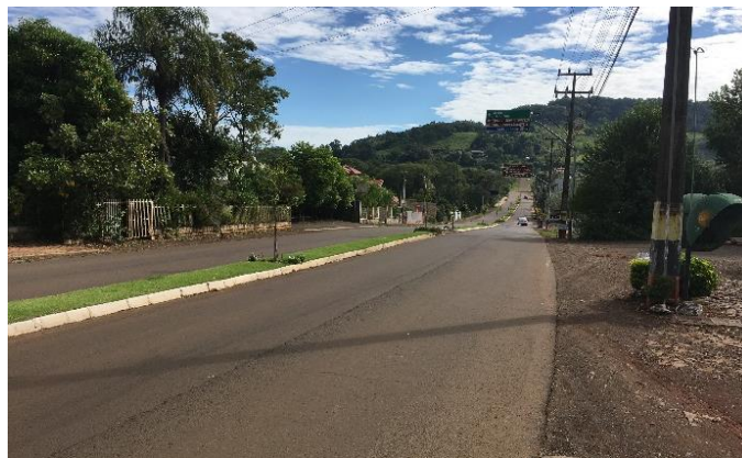
Figura 106: Rodovia SC 283, área urbana de Balneário Águas de Prata.
