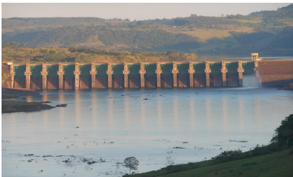
Figura 57: Barramento da UHE Foz do Chapecó no rio Uruguai.
