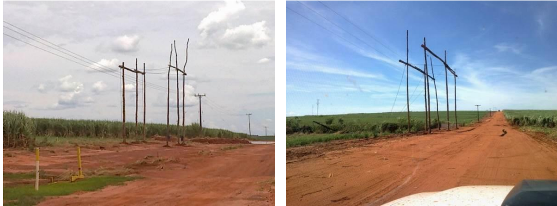
Figura 10: Empacaduras utilizadas nos lançamentos de cabos, para evitar o contato dos condutores com linha de distribuição de média tensão.
