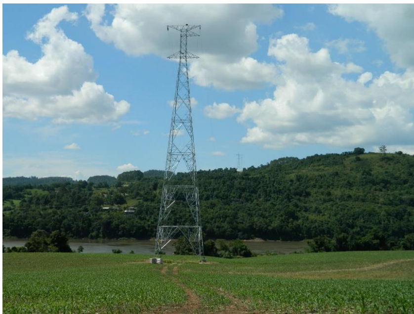
Figura 4: Localização da travessia do rio Uruguai ao lado direito da “Torre 13” da LT 230 kV Foz do Chapecó – Pinhalzinho 2 (C1).
