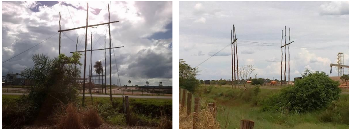
Figura 11: Empacadura utilizada nos lançamentos de cabos, para evitar o contato dos condutores com solo, protegendo os carregadores e permitindo a passagem de veículos.
