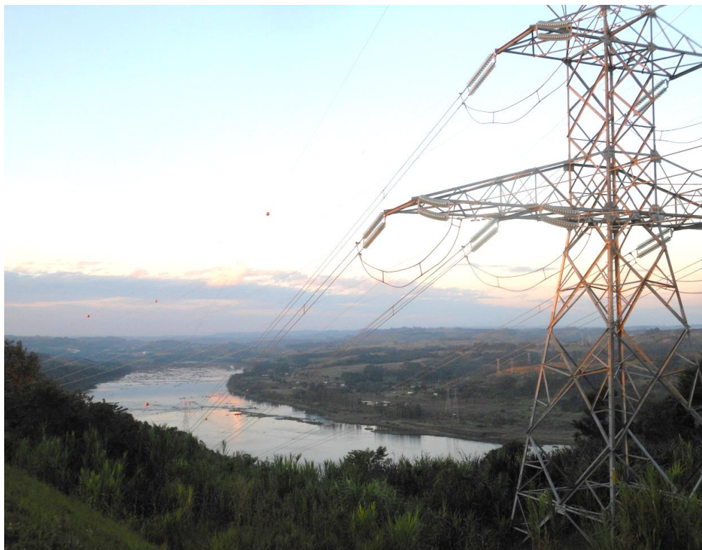
Figura 55: Residências e campos de criação de animais instalados próximo às margens do Rio Uruguai, trecho susceptível a inundação, na divisa dos municípios de São Carlos/Águas de Chapecó e Alpestre/RS.
