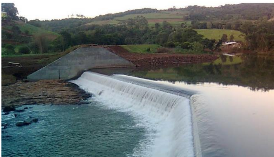
Figura 58: Barramento da PCH Barra Escondida. Fonte: Google Earth, foto de Tairo.sk apud ABG (2015).
