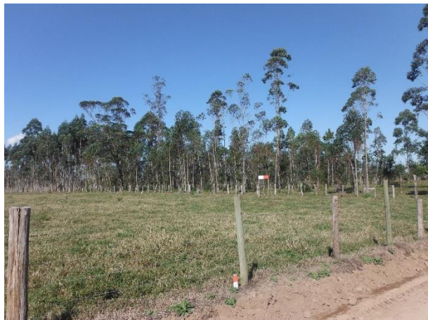
Foto VII.2.7.2-1 - Locação da faixa de servidão em campo por meio de marcos (estacas) e bandeiras, município de São João do Sul - SC
