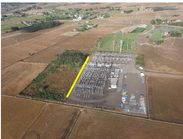
Foto VII.2.7.2-1 – Vista aérea da SE 230/69 kV Forquilha. Traçado amarelo indica o local de ampliação da SE
