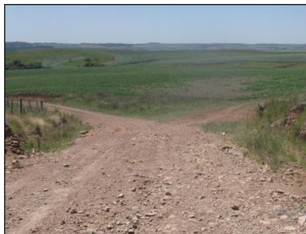
Figura 516 – Aspecto geral das vias vicinais, sem pavimentação asfáltica.
