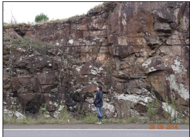
Figura 73 - Corte junto à BR116, observando-se basalto com típica zona de diaclasamento horizontal (Estação 7).
