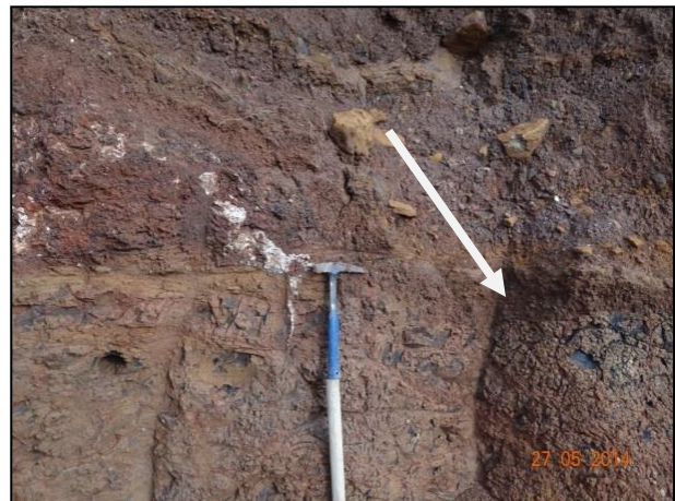
Figura 60 - Detalhe do intemperismo casca de cebola. No detalhe da foto, nota-se a zona de contato entre a rocha e o depósito coluvial.
