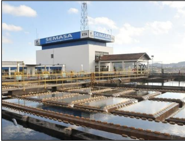
Figura 528 – Estação de Tratamento de Água de Lages.
