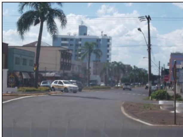
Figura 546 – Vista geral da intersecção entre a BR 116 e Av. Moreira Paz.
