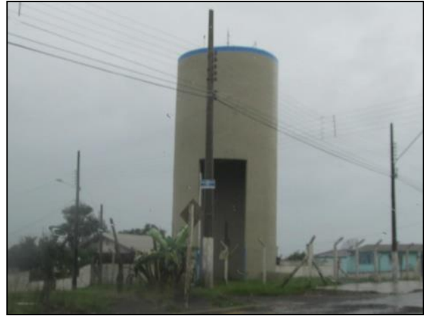
Figura 529 – Reservatório de água potável da SEMASA.
