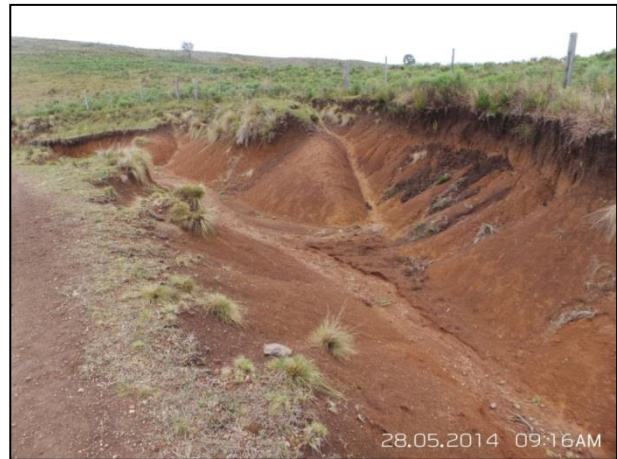
Figura 49 - Processo erosivo deflagrado as margens de estrada vicinal. Os cortes íngremes associados a ausência de dispositivos de drenagem colaboram para que se verifiquem expressões agudas como a da fotografia.
