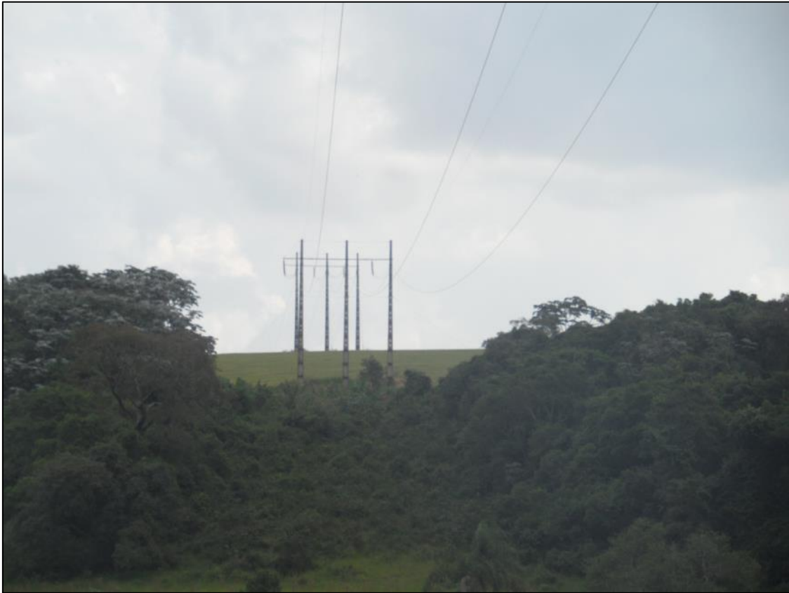
Foto 31 – Trecho entre os Vértices 16 e 17.
