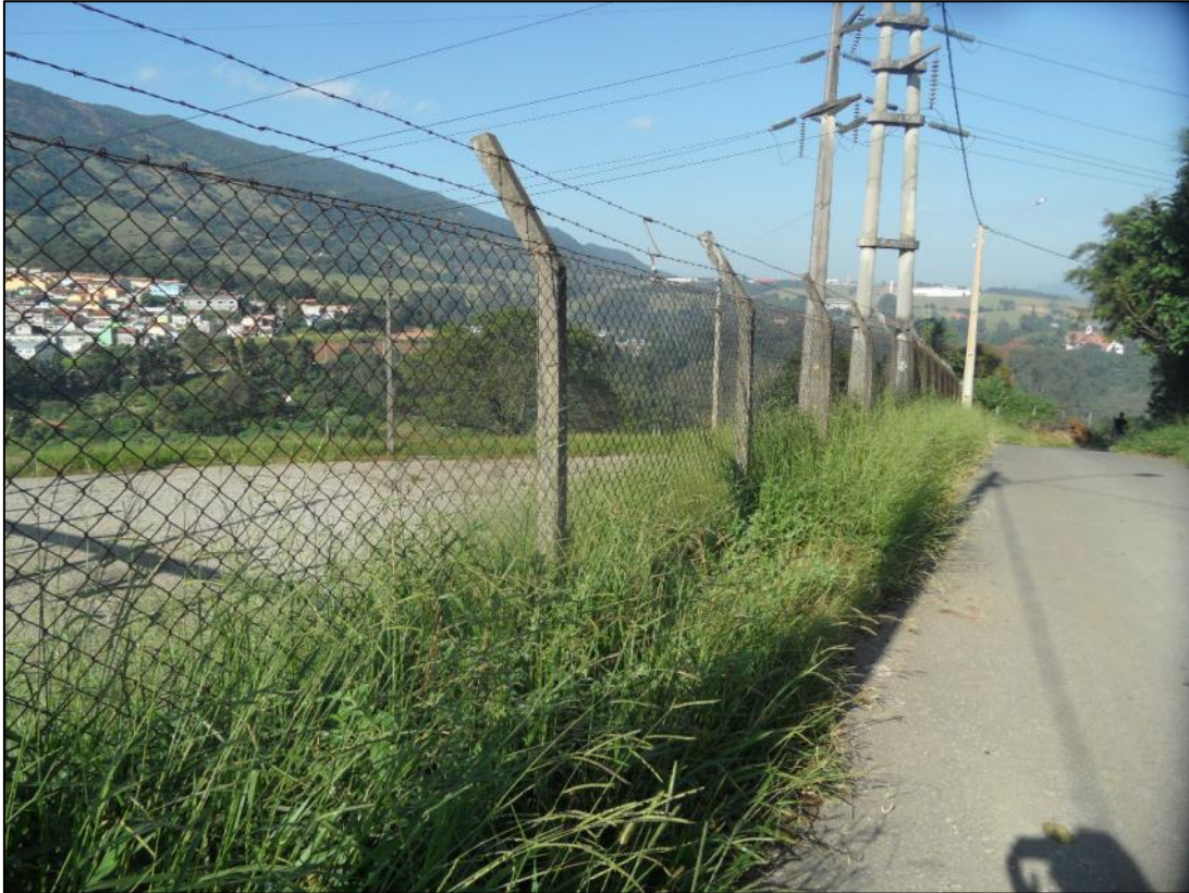
Foto 124 – Saída da SE Extrema.
