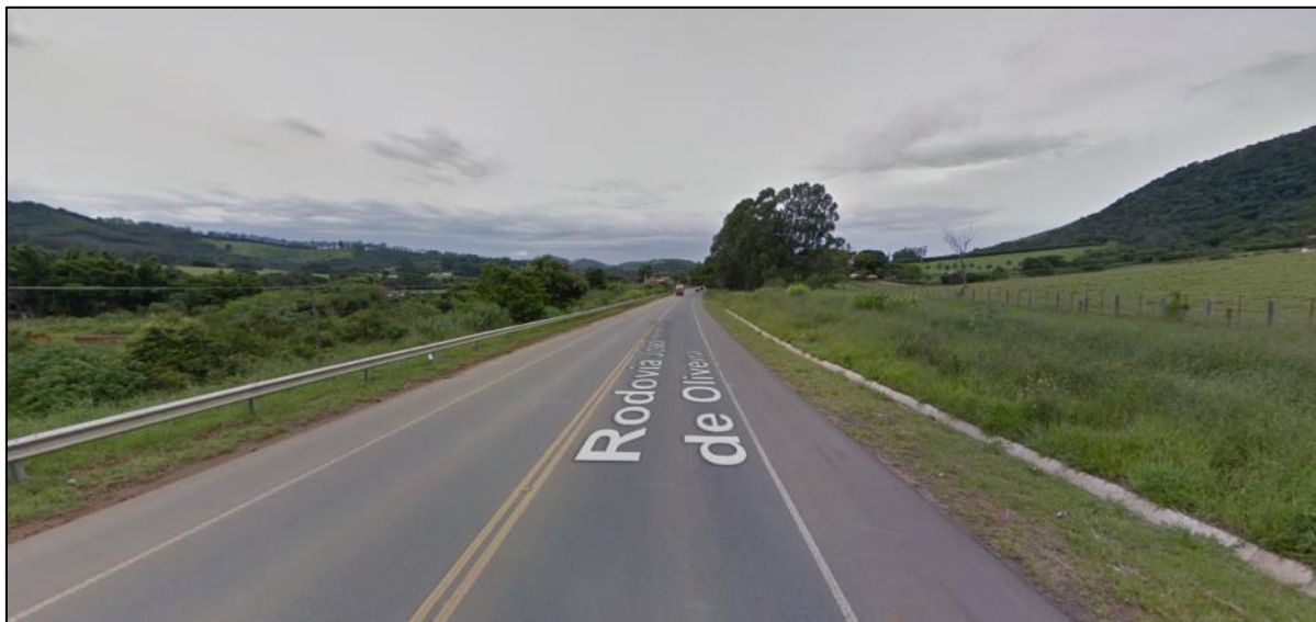
Foto 117 – Travessias entre os vértices 45 e 46.
