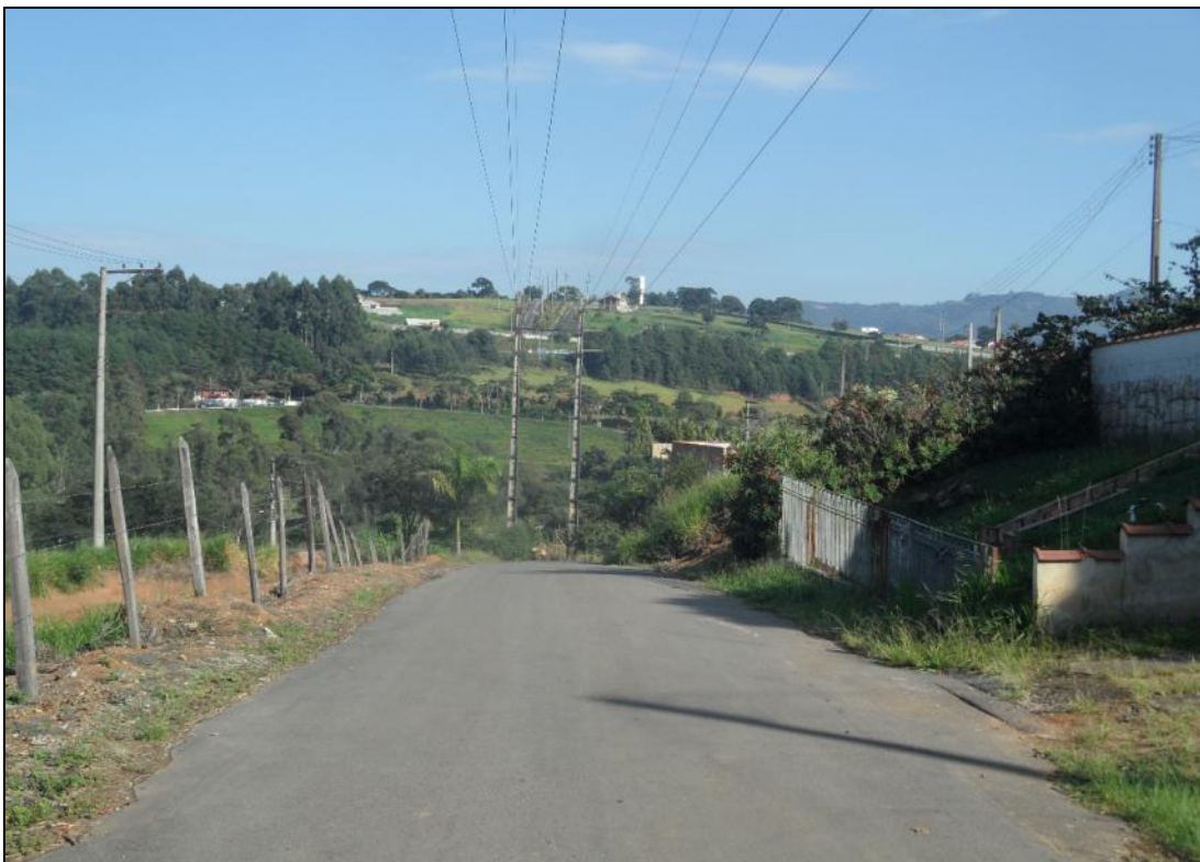
Foto 125 – Saída da SE Extrema.
