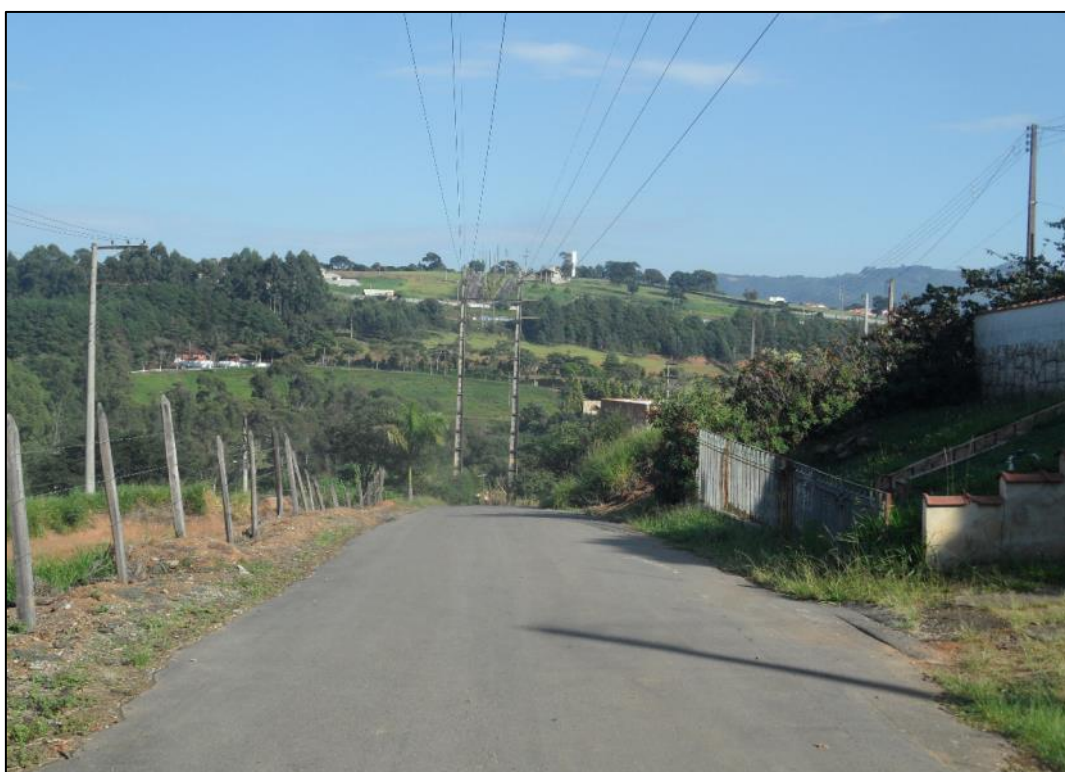
Foto 2 – Saída da SE Extrema.
