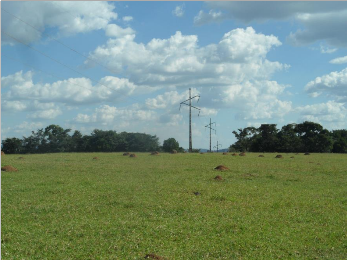
Foto 51 – Trecho entre os Vértices 27 e 28.
