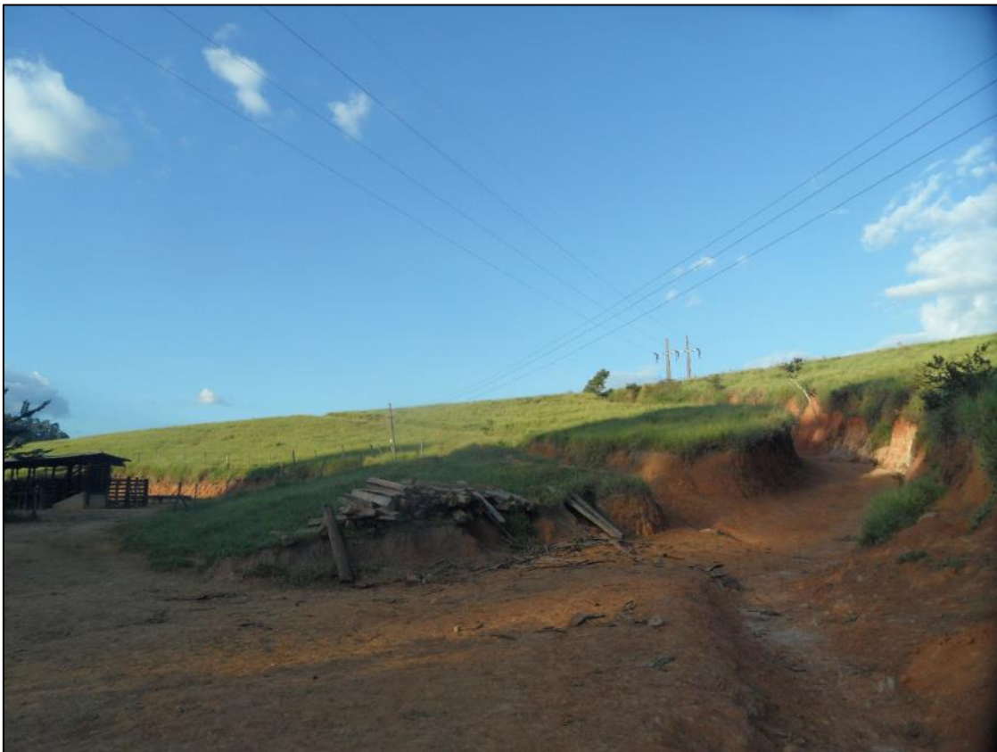
Foto 38 – Trecho entre os Vértices 20 e 21.
