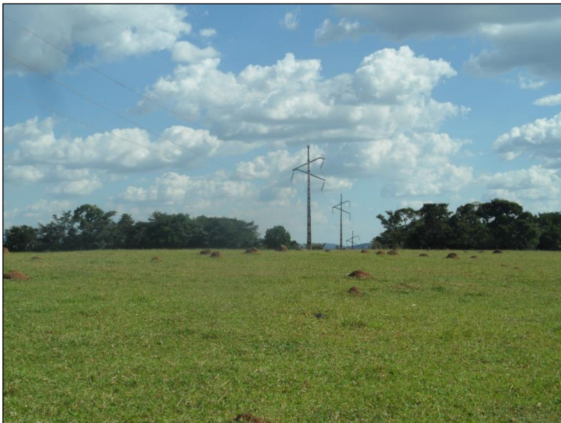
Foto 113 – Trecho entre os Vértices 27 e 28.
