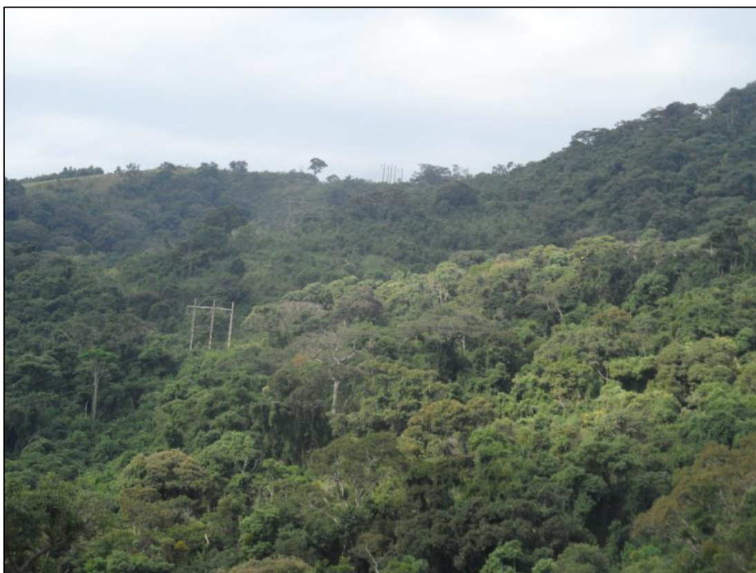
Foto 22 – Trecho entre os Vértices 11 e 12.
