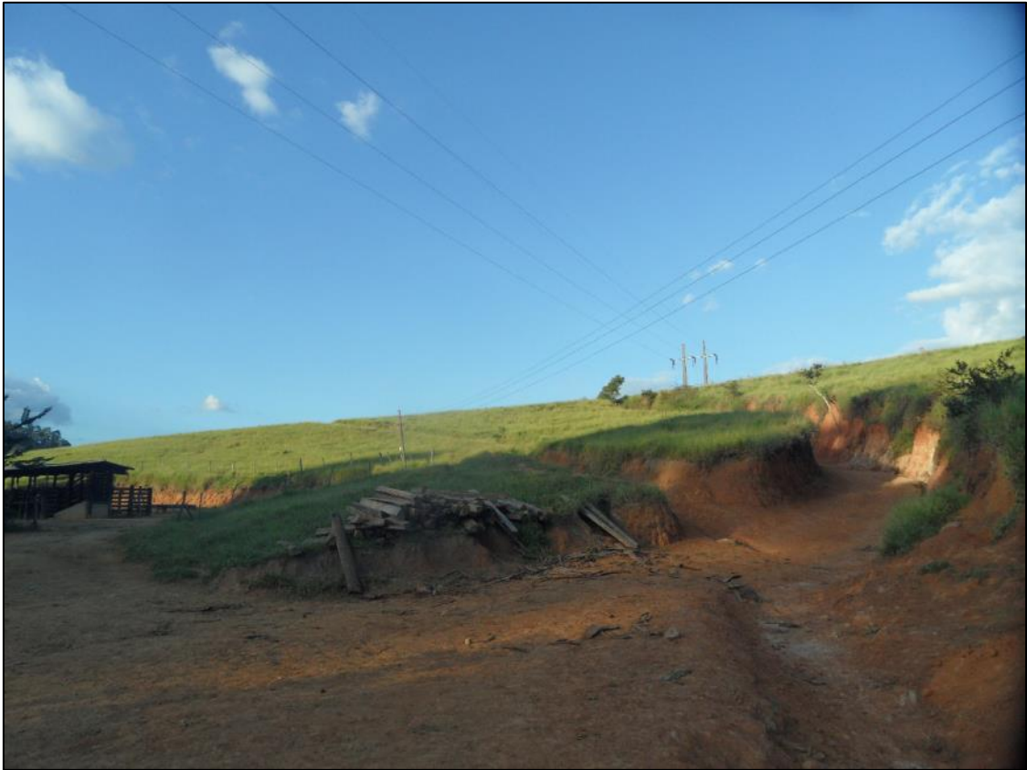
Foto 100 – Trecho entre os Vértices 20 e 21.
