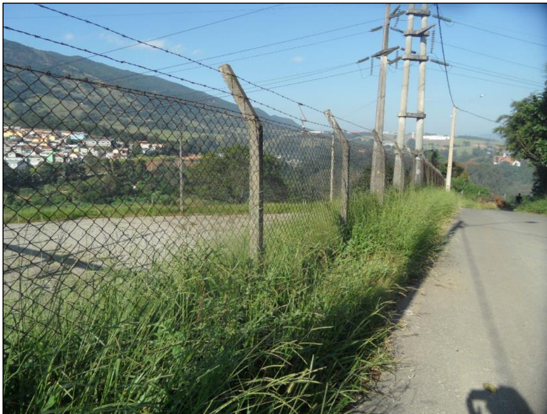
Foto 1 – Saída da SE Extrema.
