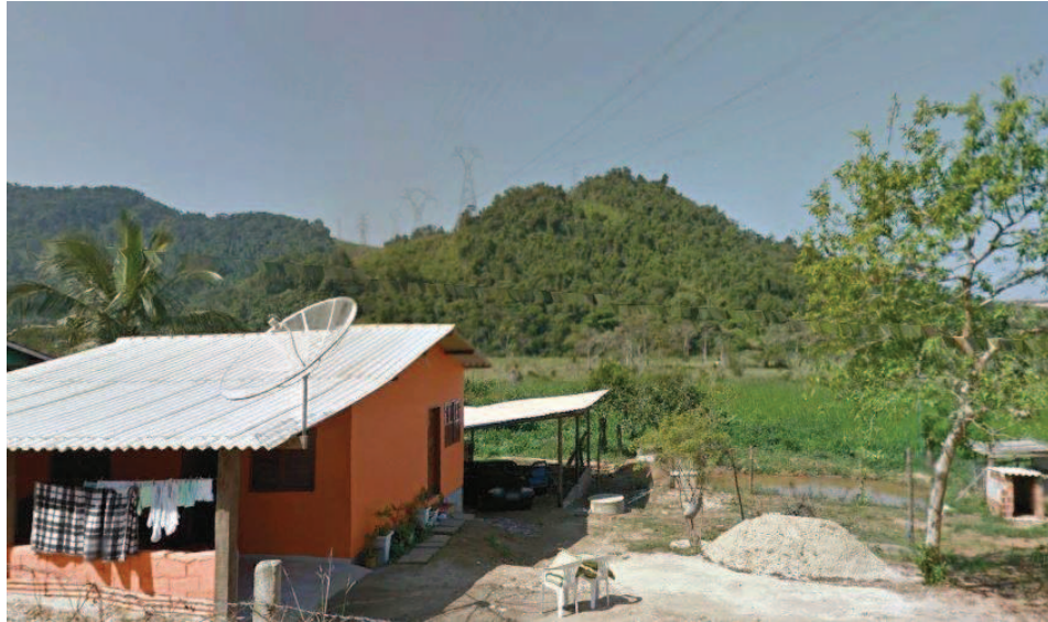
Figura 411 - Edificação Próxima na Faixa de Servidão
