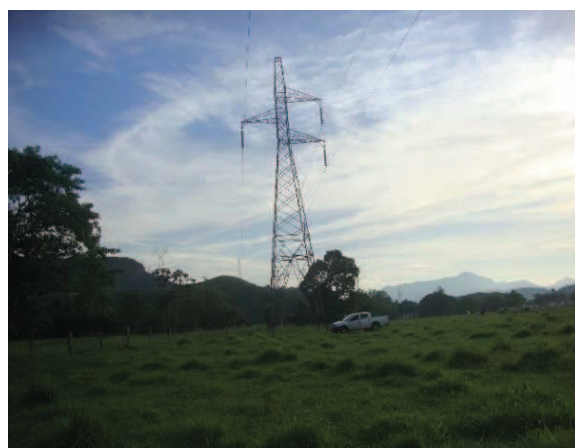
Figura 133 - Vista parcial do traçado da LT, próximo da torre 117.
