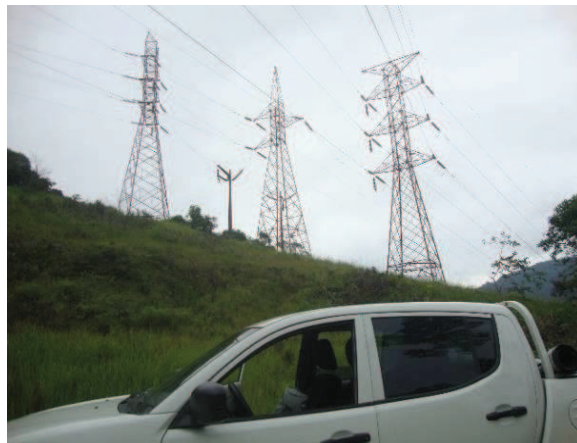
Figura 129 - Vista parcial do traçado da LT, próximo das torres 80 e 81.
