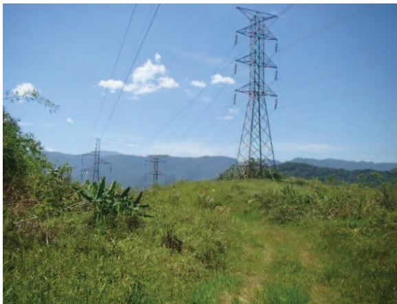
Figura 128 - Vista parcial do traçado da LT, próximo das torres 82 e 83.
