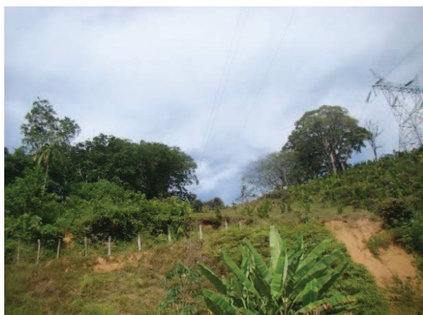
Figura 130 - Vista parcial do traçado da LT, próximo da torre 107.
