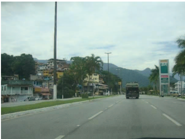
Figura 91 - Vista de um trecho da BR 101 e área urbana no entorno.
