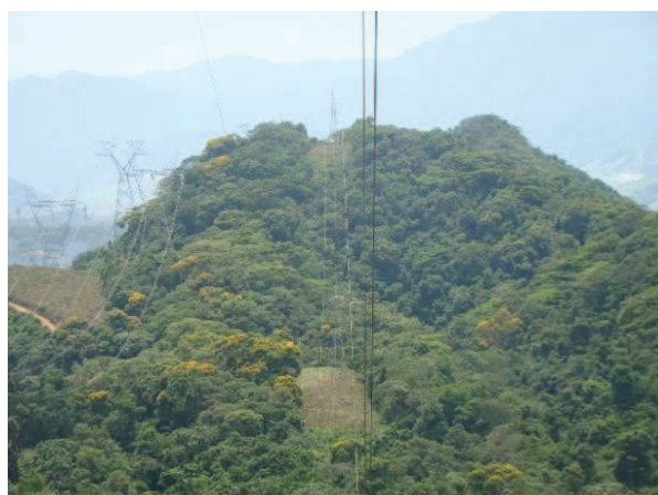
Figura 127 - Vista parcial do traçado da LT, com faixa de domínio implantada.
