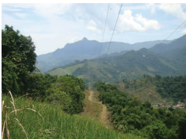
Figura 126 - Vista parcial do traçado da LT, com acessos já existentes até as torres.
