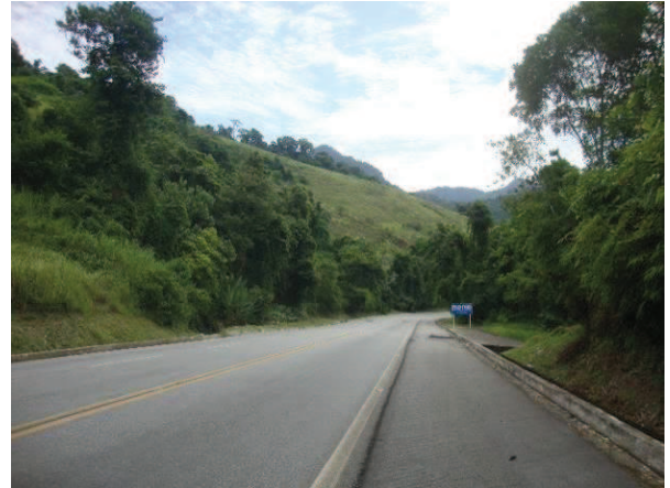
Figura 90 - Vista de um trecho da BR 101.
