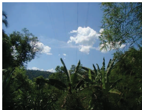
Figura 137 - Vista parcial do traçado da LT, entre a torre 84-85.
