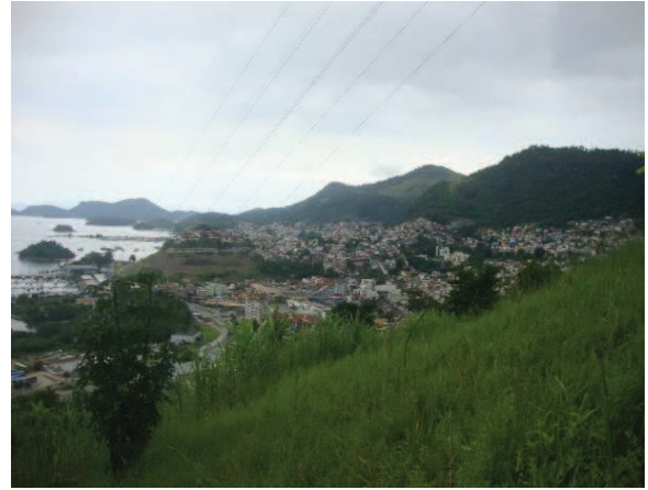
Figura 96 - Vista parcial da LT e do Centro de Angra dos Reis.
