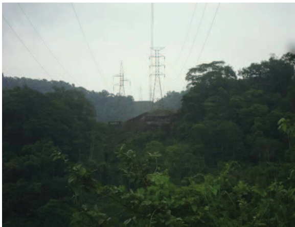
Figura 122 - Vista parcial do traçado da LT, com vista para a torre 80.
