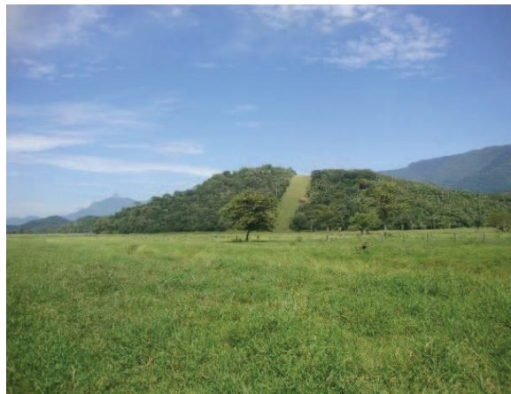
Figura 123 - Vista parcial do traçado da LT, com vista para a torre 92.
