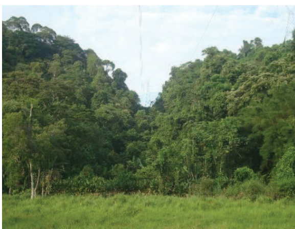
Figura 124 - Vista parcial do traçado da LT, com vista para a torre 118.
