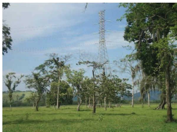
Figura 119 - Vista parcial de um trecho onde originalmente havia FOD de Terras Baixas na AID (perto da torre 91).
