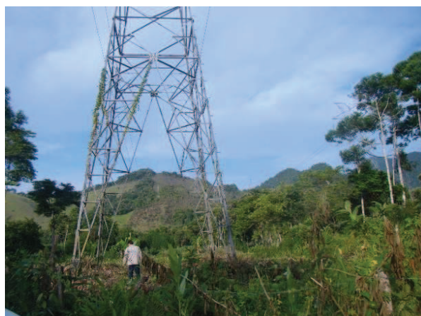
Figura 131 - Vista parcial do traçado da LT, próximo da torre 108.
