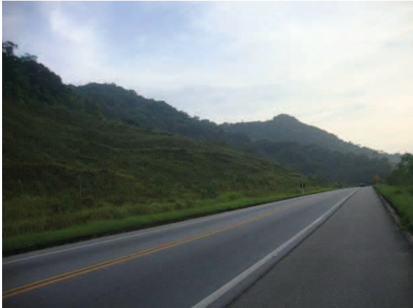
Figura 89 – Vista de um trecho da BR 101.
