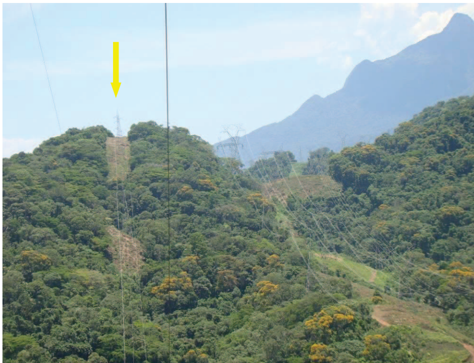
Figura 107 – Vista parcial do traçado da LT Angra-Angra (à esquerda – seta) e das outras LTs (à direita), com faixa de domínio implantada e roçada.
