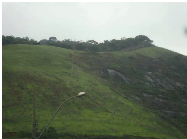
Figura 135 - Vista parcial do traçado da LT, próximo da torre 111.
