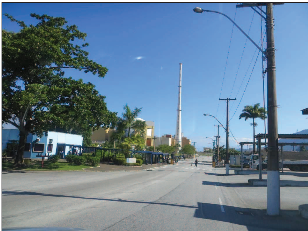
Figura 71 – Área dentro da Usina Nuclear de Angra dos Reis – RJ – Classe de Susceptibilidade a inundação baixa. Fonte: CPRM.
