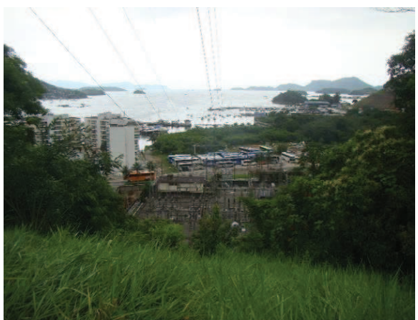
Figura 94 – Vista parcial da LT e da subestação da Enel, localizada no Centro
