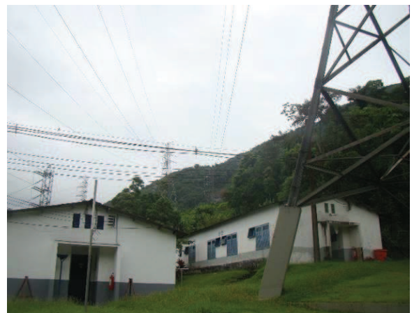
Figura 98 - Vista parcial da LT próximo da subestação Angra.
