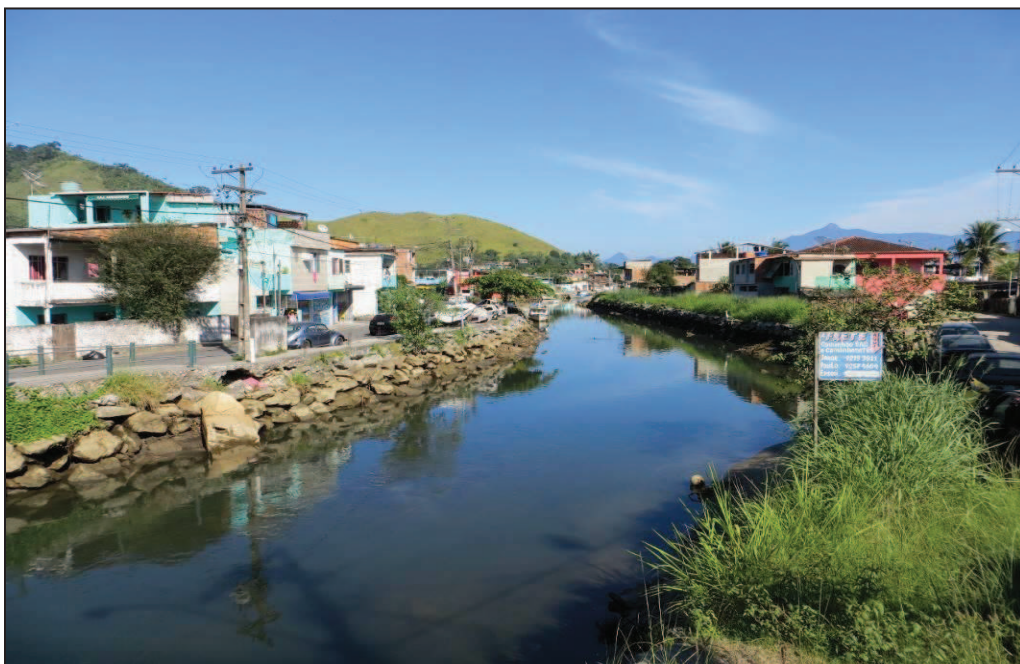
Figura 69 – Rio Japuiba – Angra dos Reis – RJ. Classe Alta de Susceptibilidade a Inundação. Fonte: CPRM.
