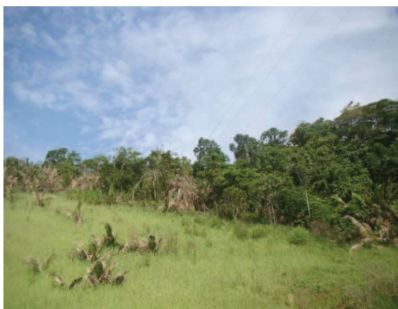
Figura 136 - Vista parcial do traçado da LT, entre a torre 92-93.
