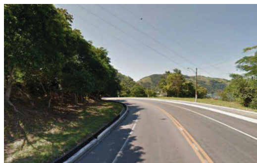
Figura 12 - Travessia BR-101 - próx. Km 520.
