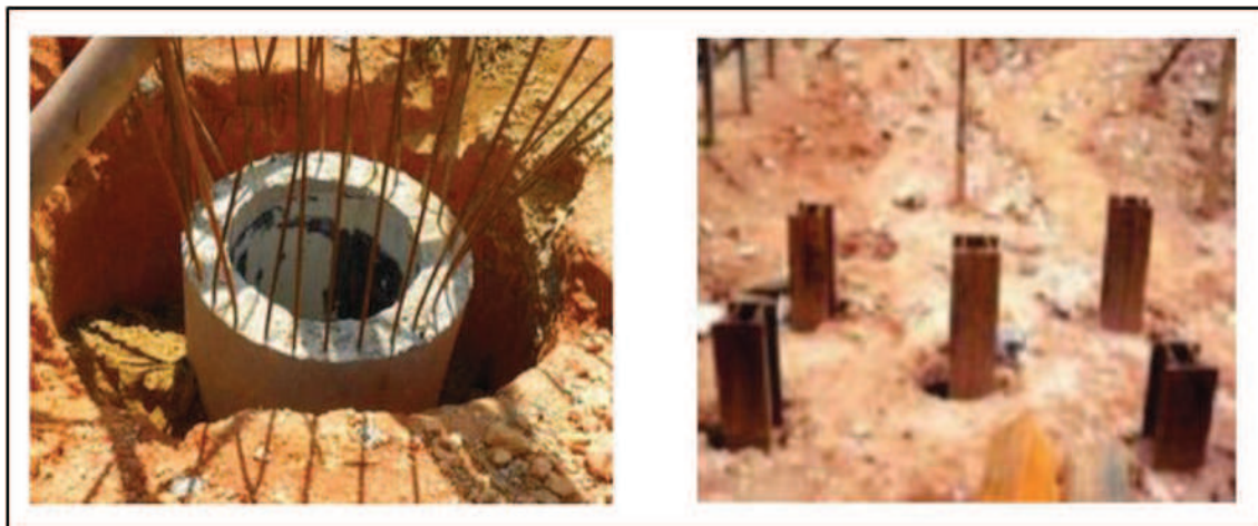
Figura 16 - Tubulão e estacas metálicas. Fonte: Menezes, 2015.
