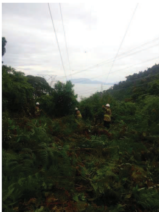
Figura 11 - Travessia LT 500kV - próx. T-130.
