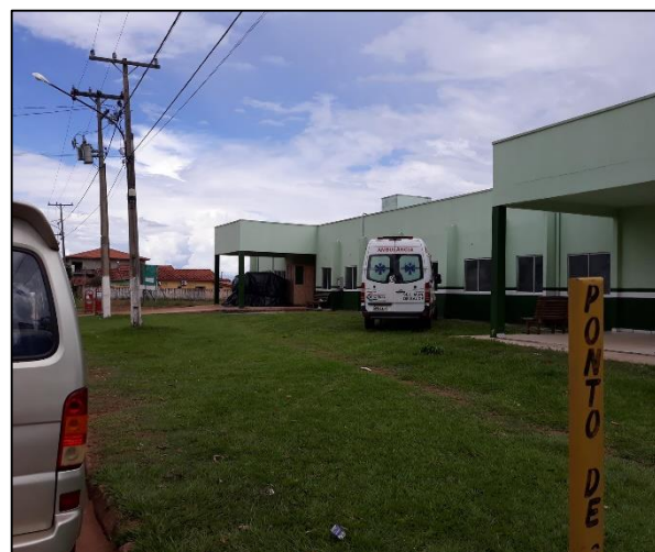
Figura 78: Hospital em Vila Rica/MT
