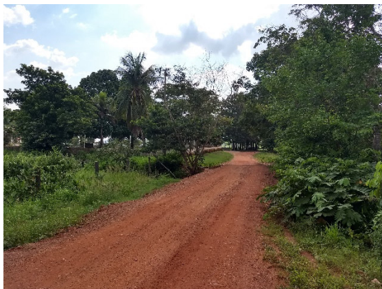
Figura 105: Via de acesso ao setor de chácaras
