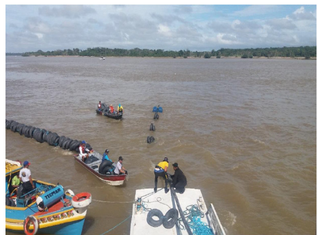
Figura 32 - Lançamento de cabo em grandes rios utilizando boias.
