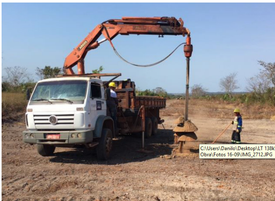
Figura 21. Escavação de fundação com broca.
