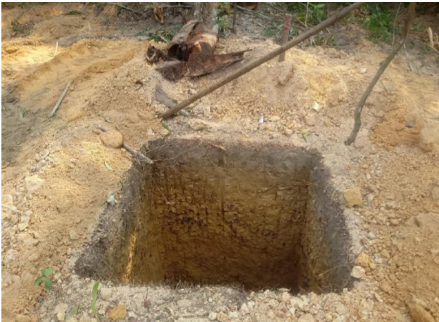
Figura 22 - Escavação de estrutura concluída.
