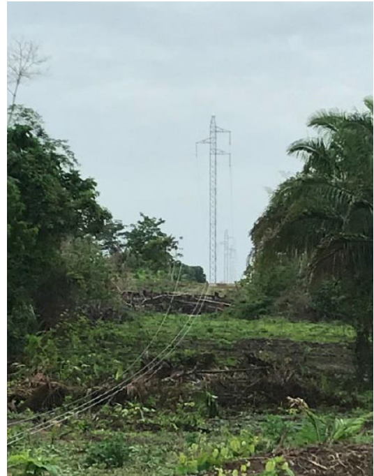
Figura 30 - Lançamento de cabos.
