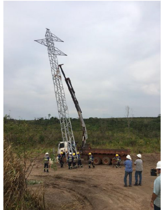
Figura 27 - Içamento de torre metálica pré-montada.
