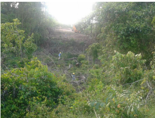
Figura 31 - Operários atravessando corda para lançamento de cabo sobre corpo hídrico estreito.
