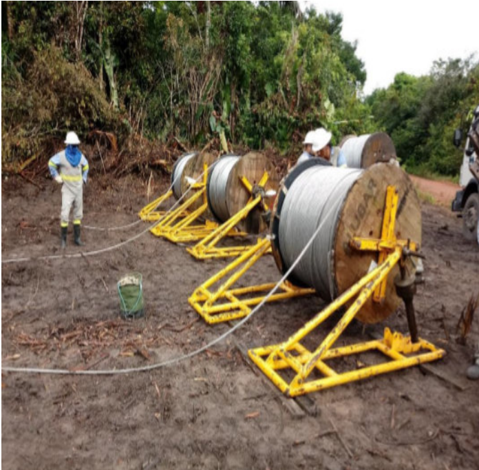
Figura 29 - Praça de lançamento de cabos.
