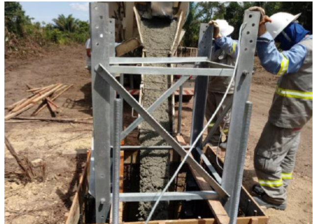
Figura 23 - Concretagem de fundação de torre metálica.
