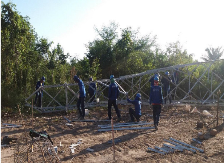
Figura 26 - Torre sendo pré-montada ao solo por operários.
