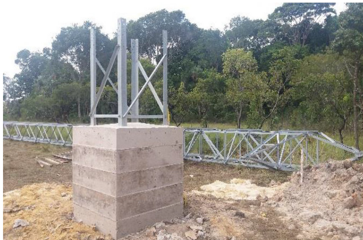
Figura 24 - Torre metálica - fundação aflorada.
