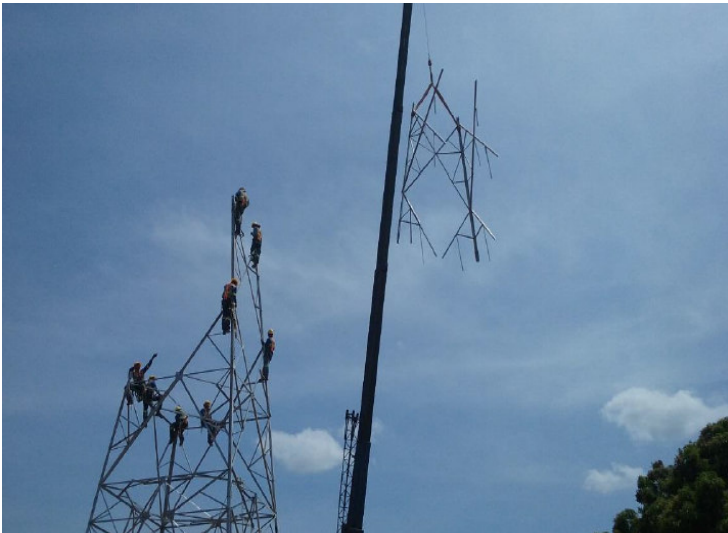
Figura 28 - Montagem de torre metálica por partes.
