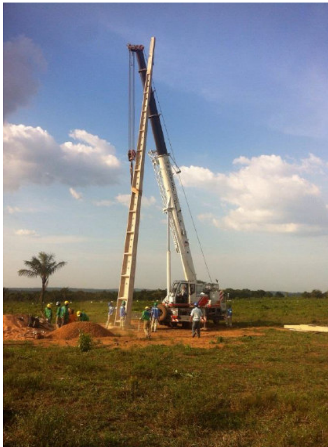
Figura 25. Içamento de poste de concreto.
