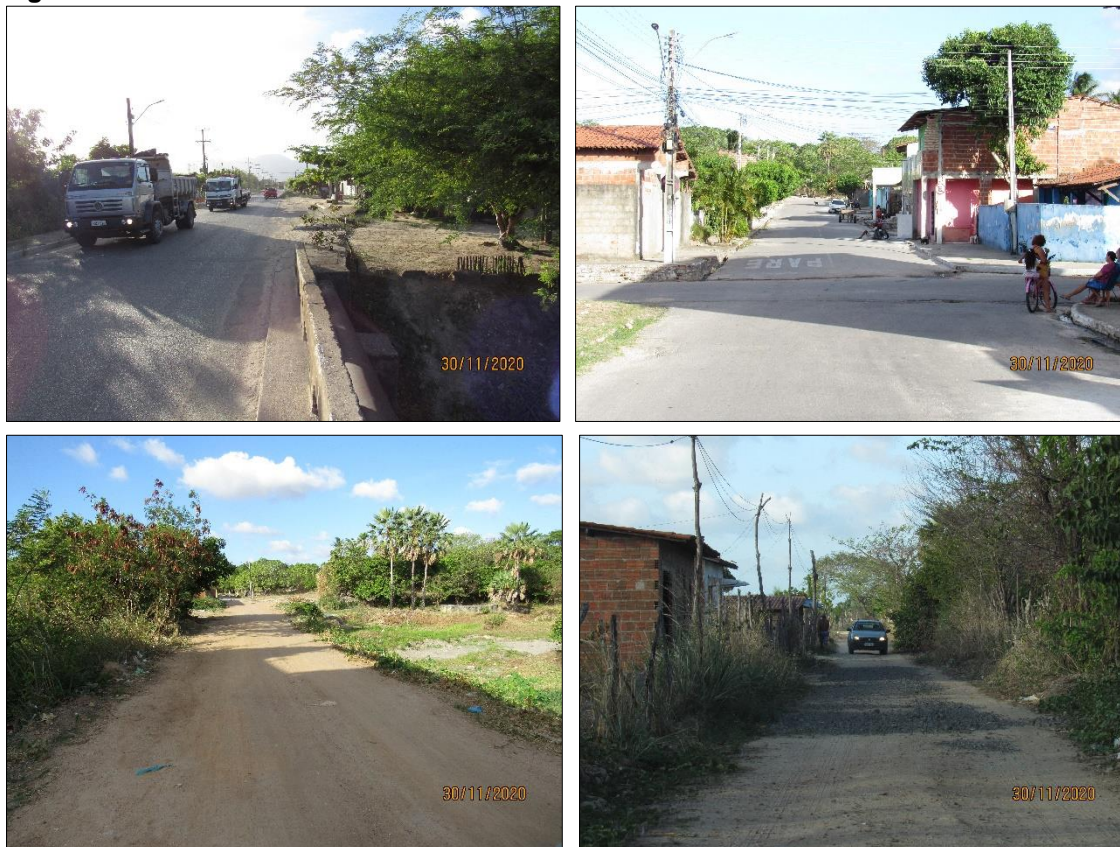
Figura 98: Malha viária em Maracanaú: Rodovia asfaltada e estrada de terra.
