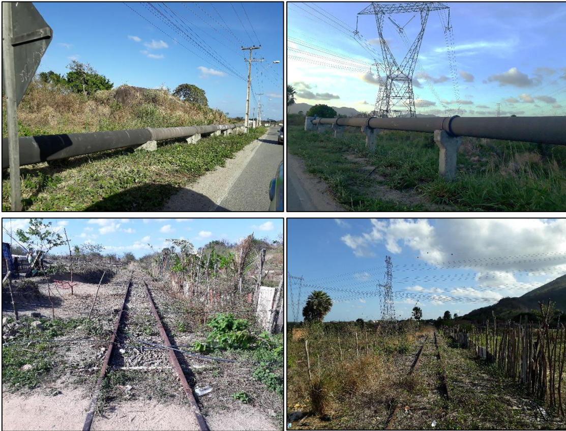
Figura 18: Linhas de Transmissão dividindo espaço com adutoras; ferrovia Transnordestina desativada na CE-350.
