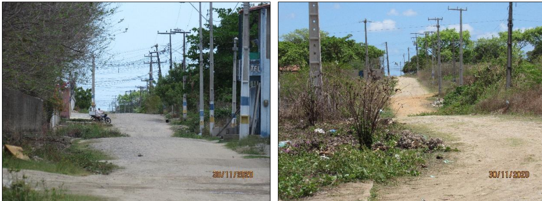
Figura 77: Alinhamento preferencial dos postes à direita, sentido Maracanaú-Pacatuba na Rua cabo João
