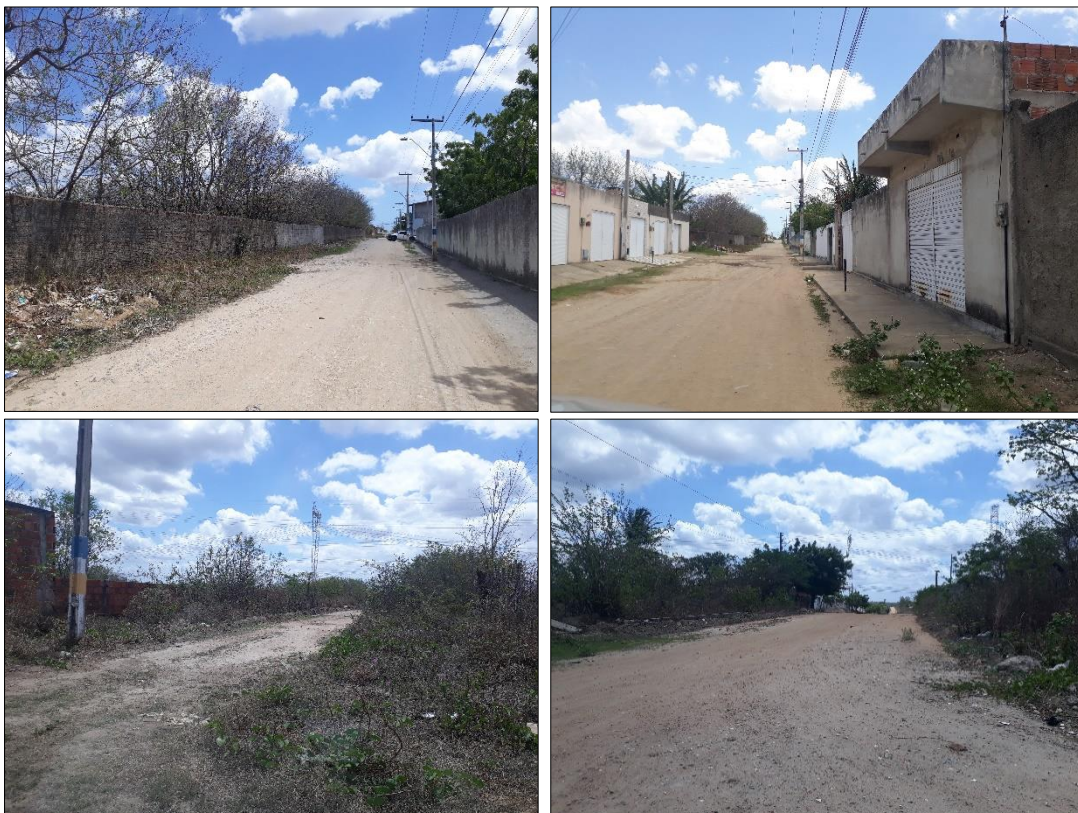
Figura 85: Aspecto dos logradouros em Pavuna na faixa de servidão com pouco estabelecimentos comerciais.
