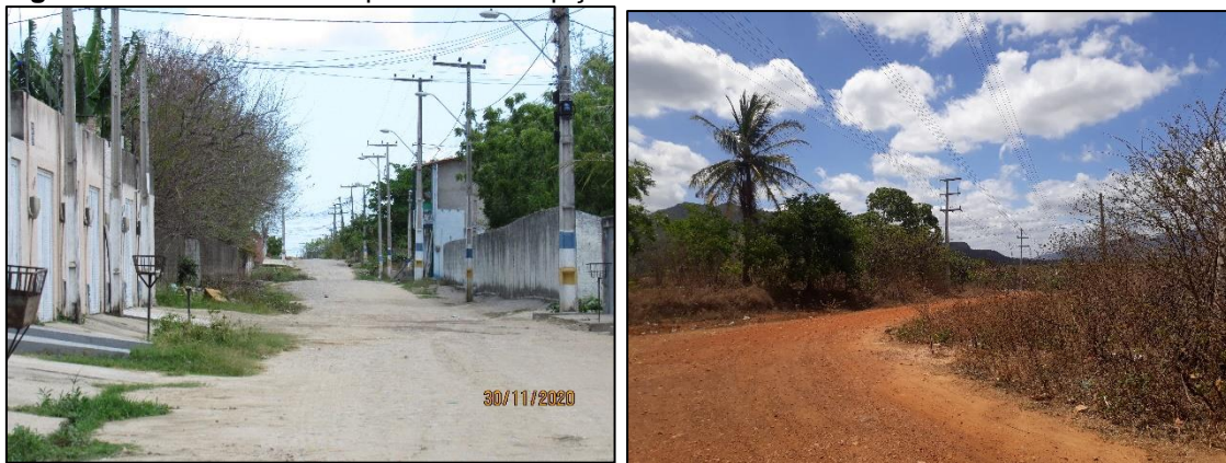
Figura 80: Malha viária em pedra tosca e piçarra na Rua Cabo João
