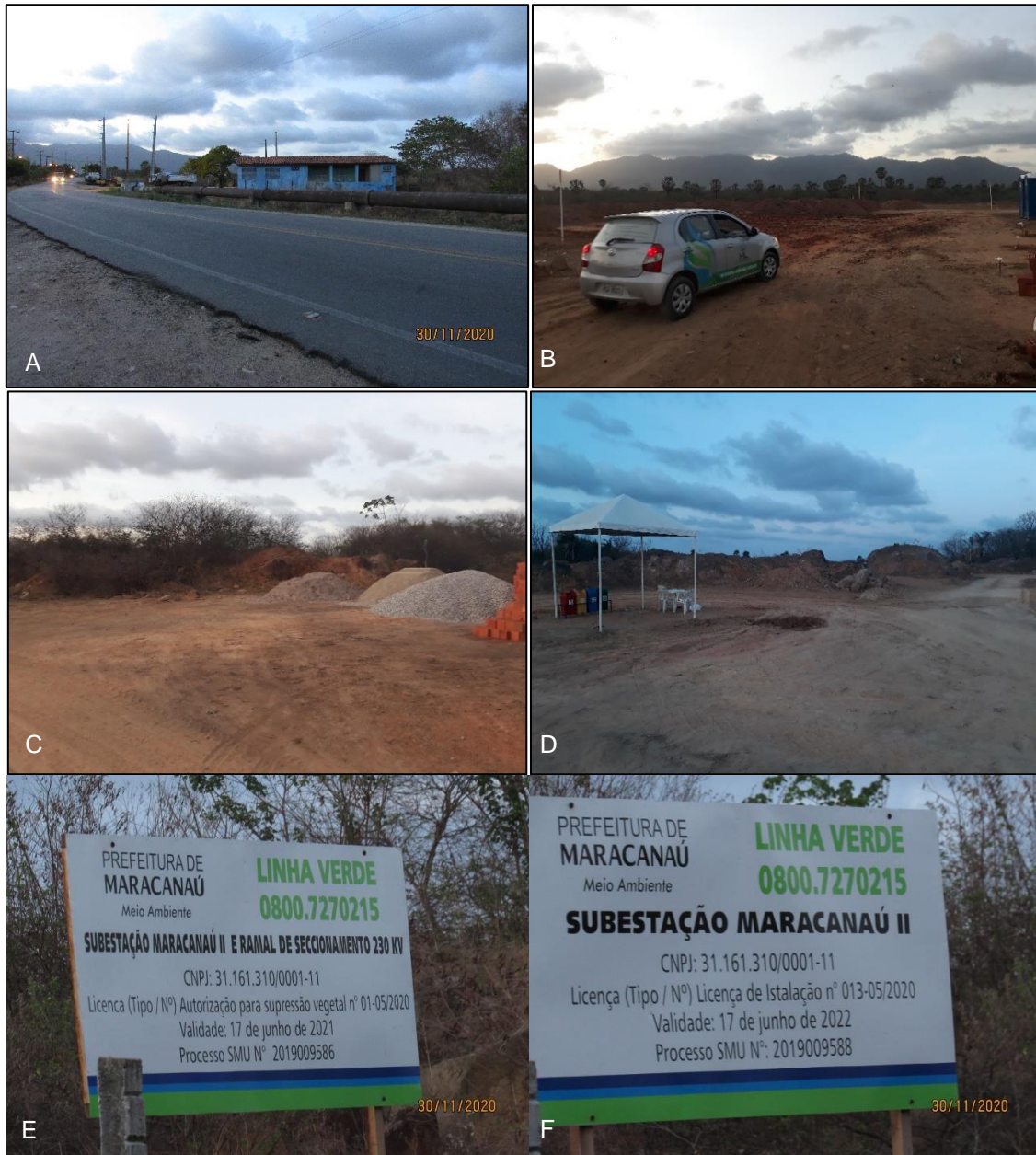
Fonte: HL Soluções Ambientais, 2020. Legenda: A - Acesso a Subestação Maracanaú II pela Rodovia CE-350. B - Entrada no terreno da subestação. C e D - Canteiro de obras. E - Placa de licença do ramal de seccionamento. F - CPlaca de licença da Subestação Maracanaú II.
