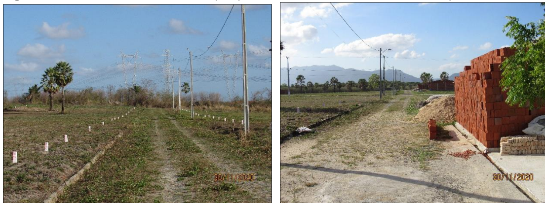
Figura 101: Loteamento na CE-350 por passará a LDAT Maracanaú - Acarape.
