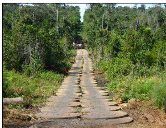
Figura 2.1-11 - Aplicação de bobinas como estivas para acessos em áreas alagáveis.
