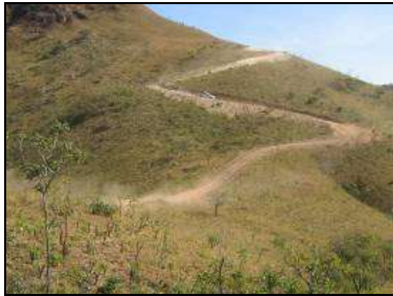
Figura 2.1-10 - Implantação de acessos de acordo com as curvas de nível.
