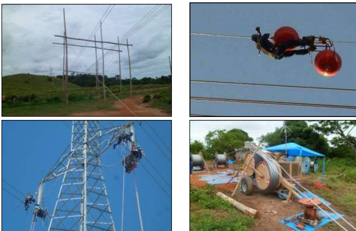
Figura 2.1-18 - Travessia de cabos sobre empancaduras, instalação de esferas de sinalização, grampeamento de cabos e praça de lançamento dos cabos condutores, para-raios, isoladores e acessórios.
