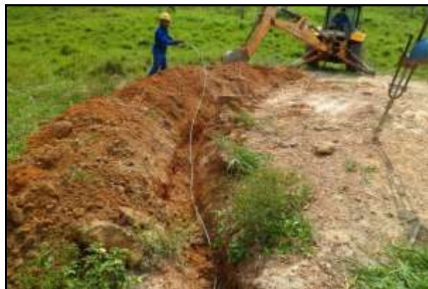
Figura 2.1-17 - Instalação de contrapeso.
