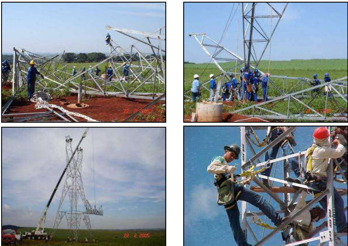
Figura 2.1-16 - Praça de montagens das torres.
