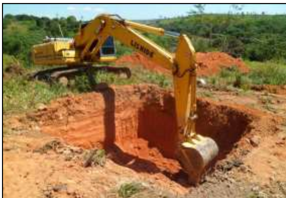
Figura 2.1-13 - Escavação para fundações das torres.
