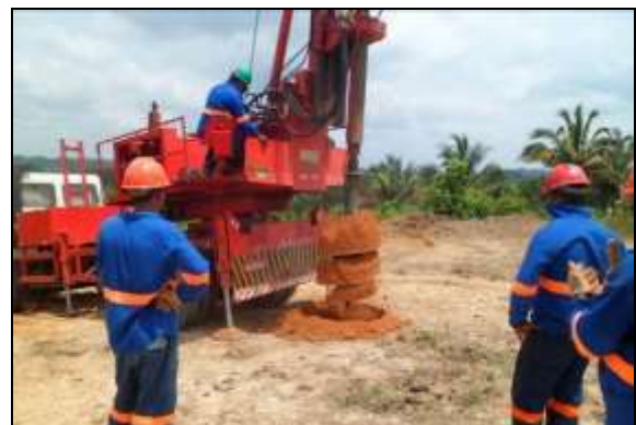
Figura 2.1-13 - Escavação para fundações das torres.
