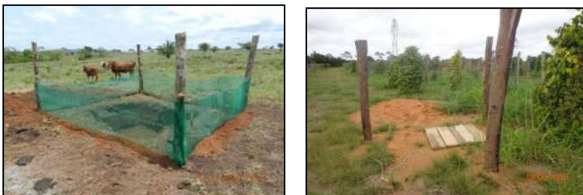
Figura 2.1-14 - Cercamento e cobertura de cavas de fundações.
